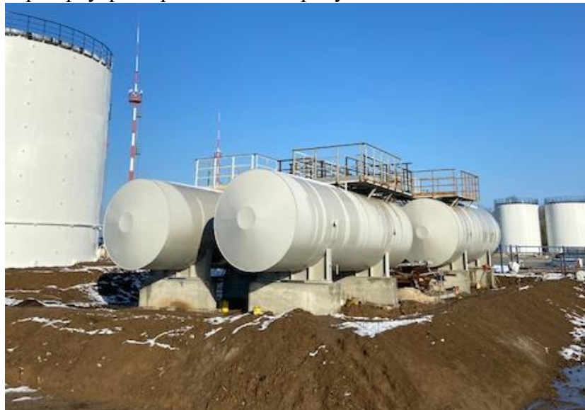
Рисунок 1 – Общий вид резервуаров.
