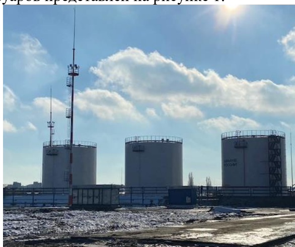
Рисунок 1 - Общий вид резервуаров.
