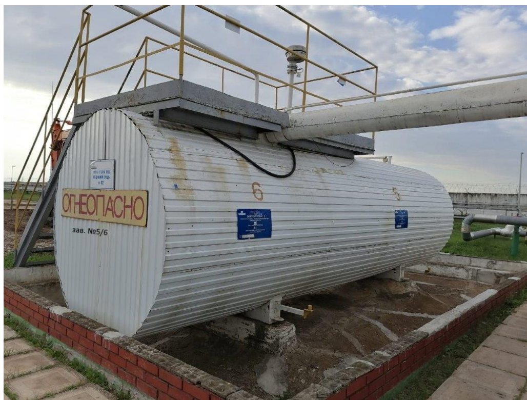
Рисунок 2 – Общий вид резервуара РГС-20 с заводским номером 5/6
