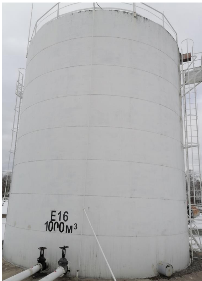
Рисунок 3 – Общий вид резервуара РВС-1000 зав.№ E16
