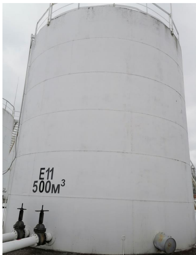
Рисунок 2 – Общий вид резервуара РВС-500 зав.№ E11
