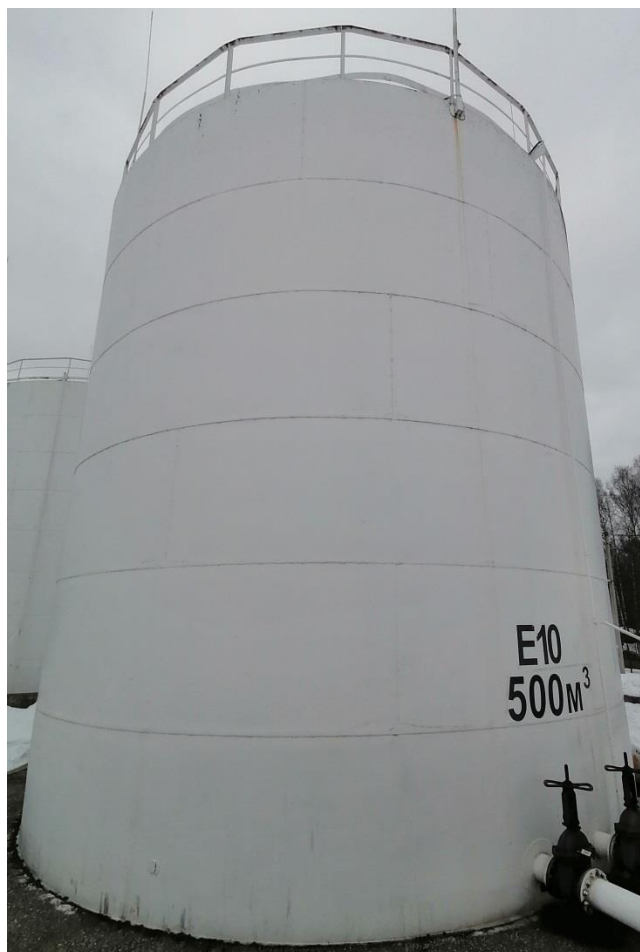
Рисунок 1 – Общий вид резервуара РВС-500 зав.№ E10
