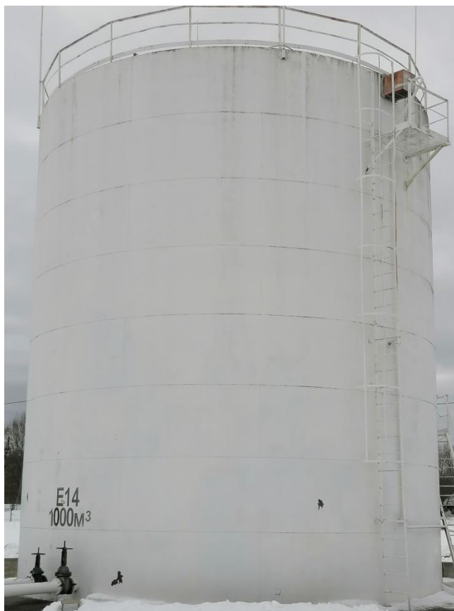
Рисунок 1 – Общий вид резервуара РВС-1000 зав.№ E14
