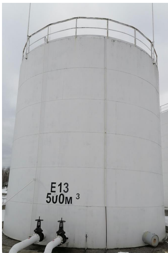
Рисунок 4 – Общий вид резервуара РВС-500 зав.№ E13
