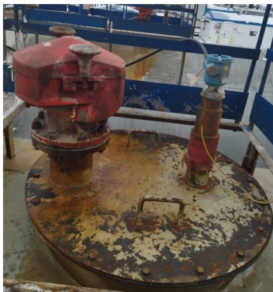
Рисунок 3 – Фото горловины резервуаров РГСН-100
