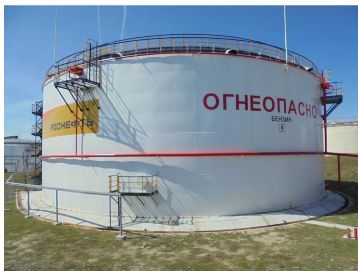
Рисунок 3 – Общий вид резервуаров РВСП-10000
