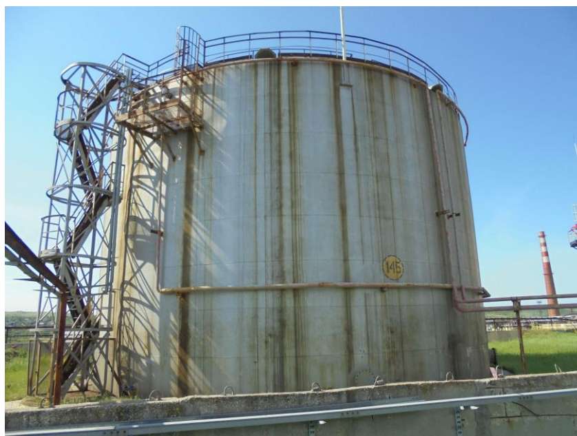
Рисунок 1 – Общий вид резервуаров РВСП-3000
