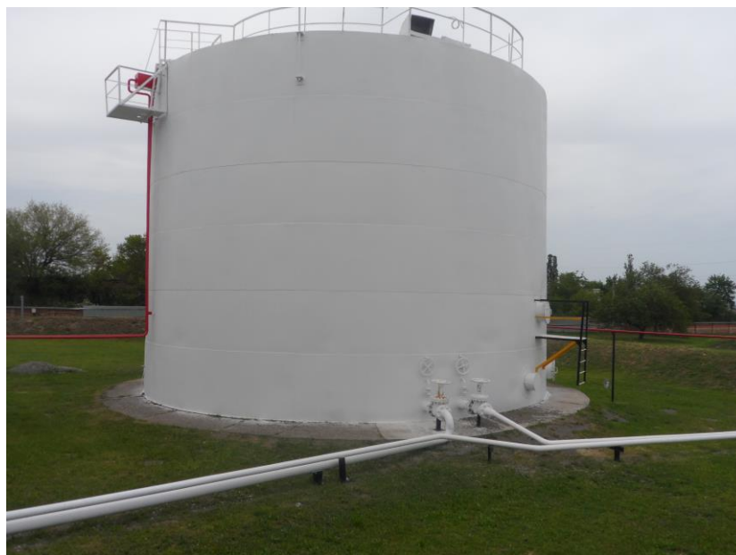
Рисунок 3 – Общий вид резервуаров РВСП-1000
