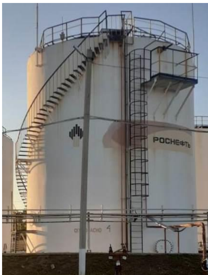
Рисунок 3 – Общий вид резервуаров РВСП-1000
