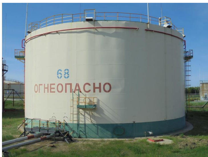
Рисунок 2 – Общий вид резервуаров РВСП-5000
