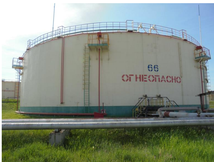
Рисунок 4 – Общий вид резервуара РВСП-20000
