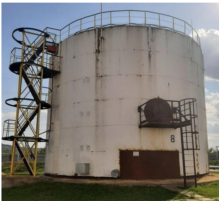
Рисунок 1 – Общий вид резервуара РВСП-1000
