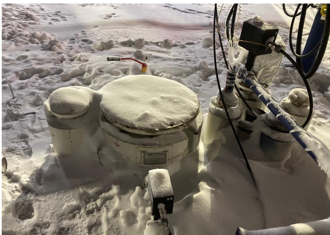
Рисунок 2 – Общий вид резервуара ЕПП8
