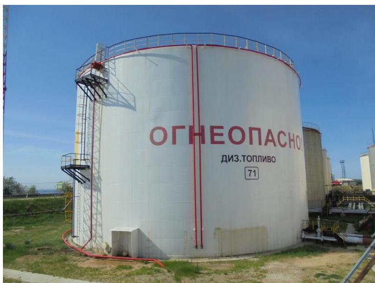
Рисунок 3 – Общий вид резервуаров РВС-10000
