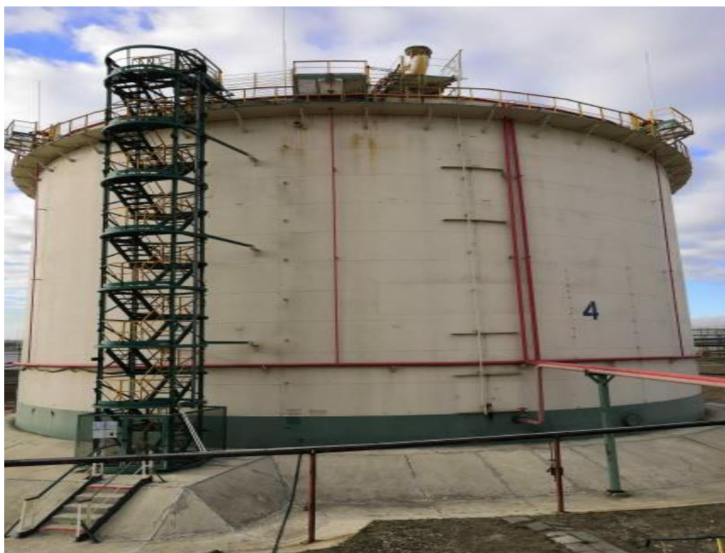
Рисунок 7 – Общий вид резервуаров РВСПК-10000
