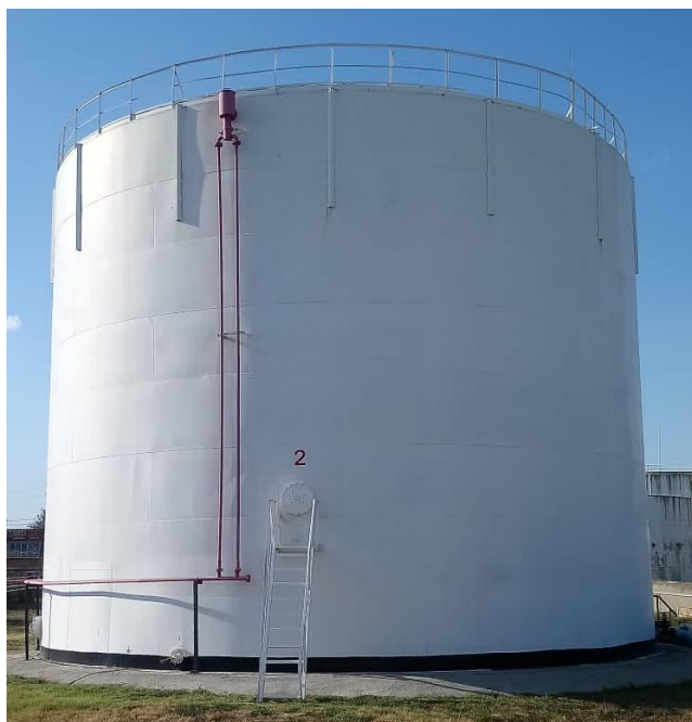
Рисунок 2 – Общий вид резервуара РВСП-2000
