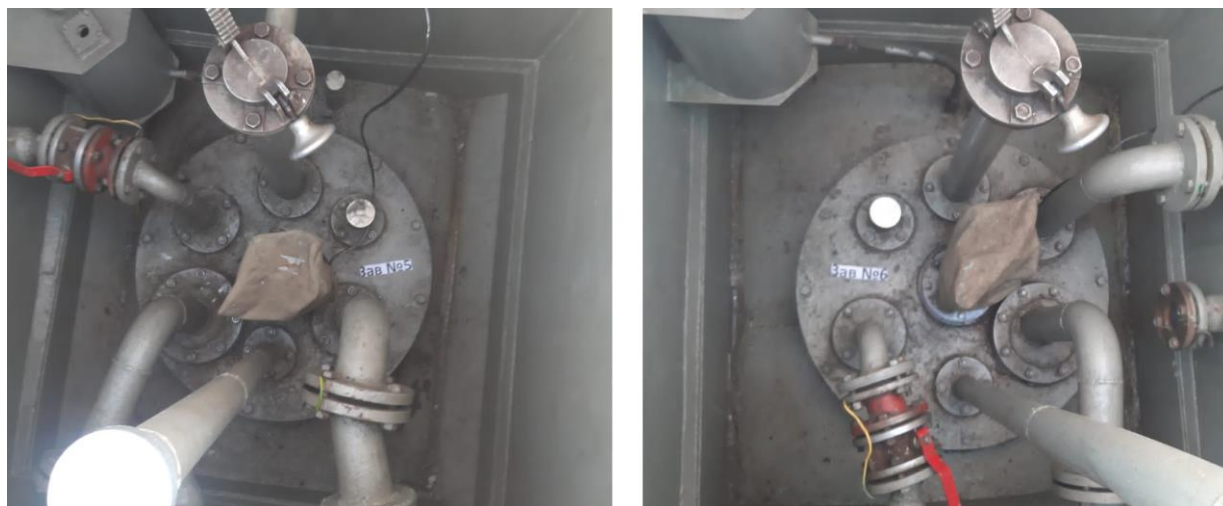
Рисунок 2 – Общий вид резервуаров РГС-50
