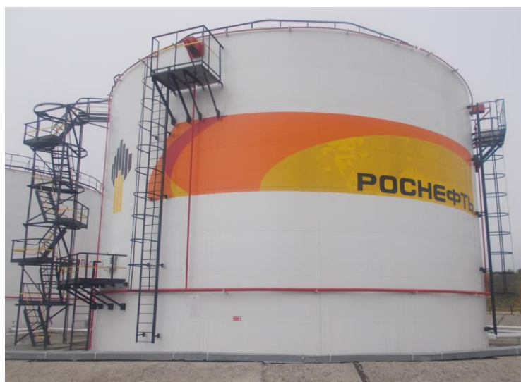
Рисунок 2 – Общий вид резервуаров РВСП-3000
