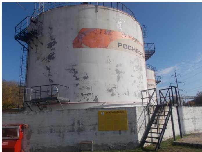
Рисунок 2 – Общий вид резервуаров РВСП-2000
