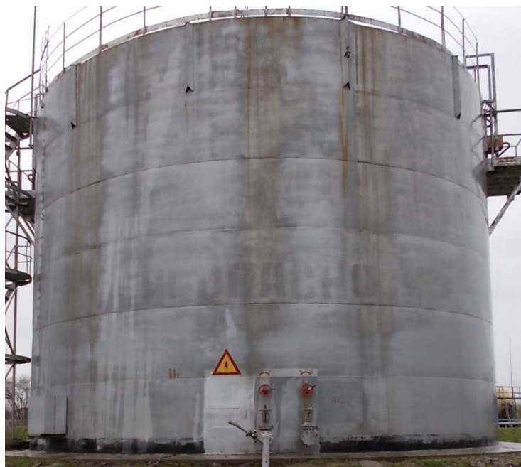
Рисунок 1 – Общий вид резервуара РВС-1000
