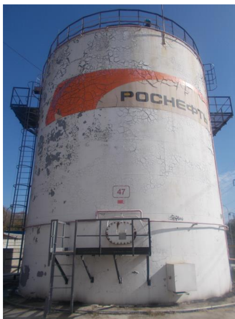
Рисунок 1 – Общий вид резервуаров РВСП-1000
