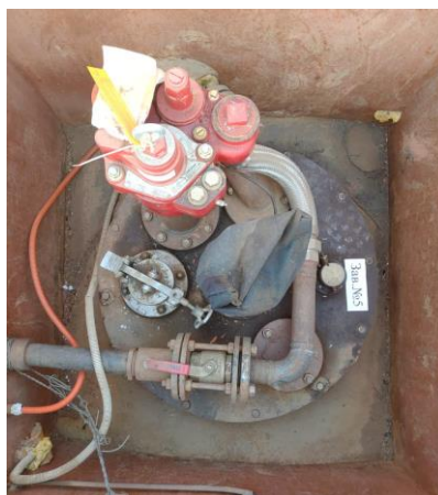
Рисунок 1 – Общий вид резервуара РГС-25
