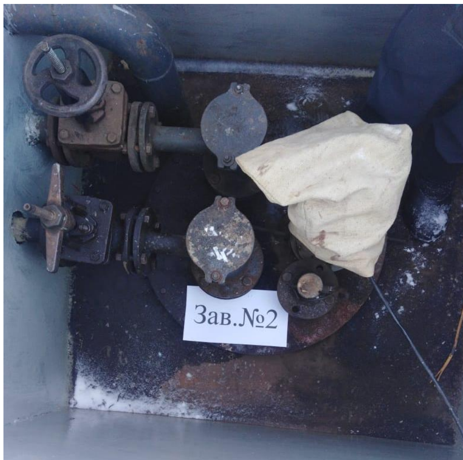
Рисунок 1 – Общий вид резервуара РГС-40
