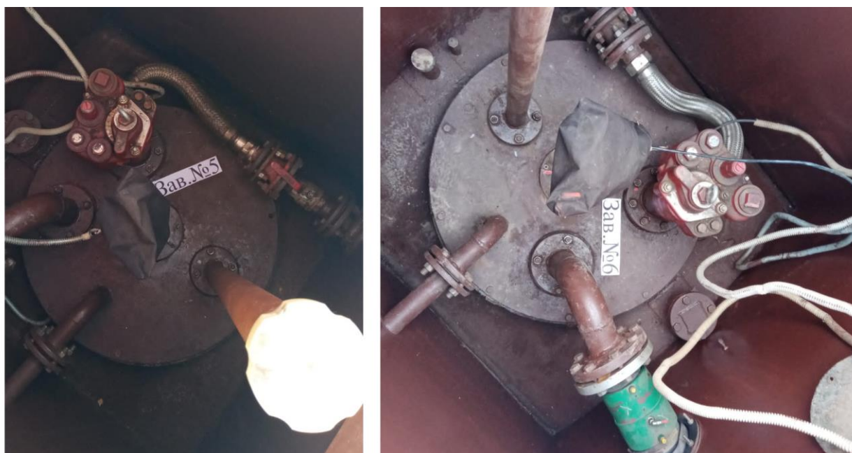
Рисунок 1 – Общий вид резервуаров РГС-25
