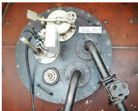
Рисунок 1 – Общий вид резервуара РГС-30
