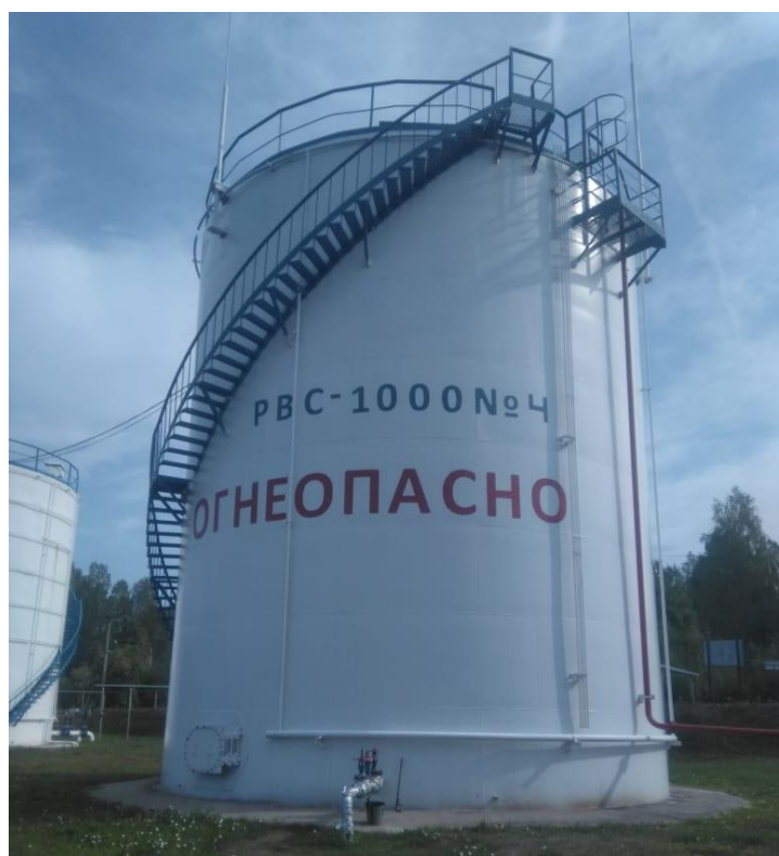
Рисунок 3 – Общий вид резервуара РВС-1000 с заводским номером 01292/1
