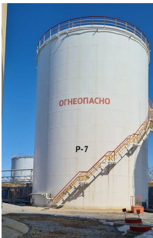
Рисунок 3 – Общий вид резервуара с зав. № 7
