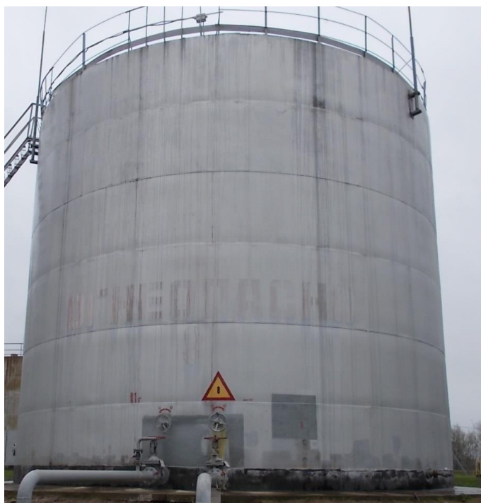
Рисунок 1 – Общий вид резервуаров РВСП-700
