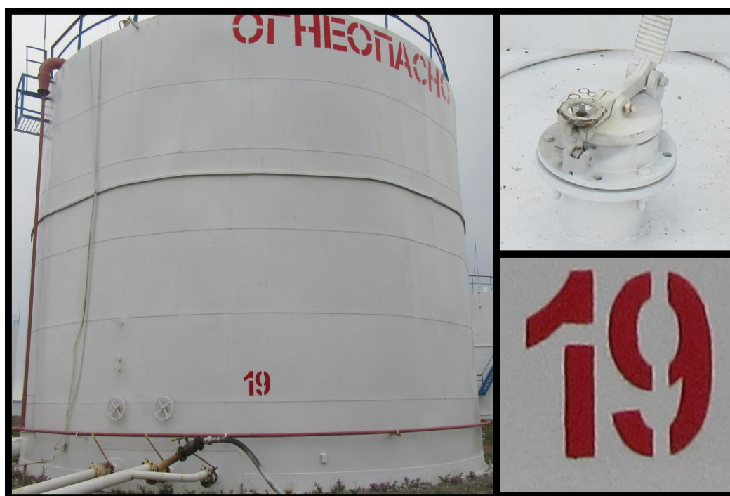
Рисунок 8 - Общий вид резервуаров РВС-1000 № 19
