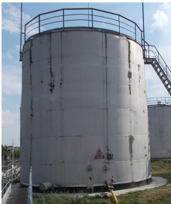
Рисунок 1 – Общий вид резервуаров РВС-400
