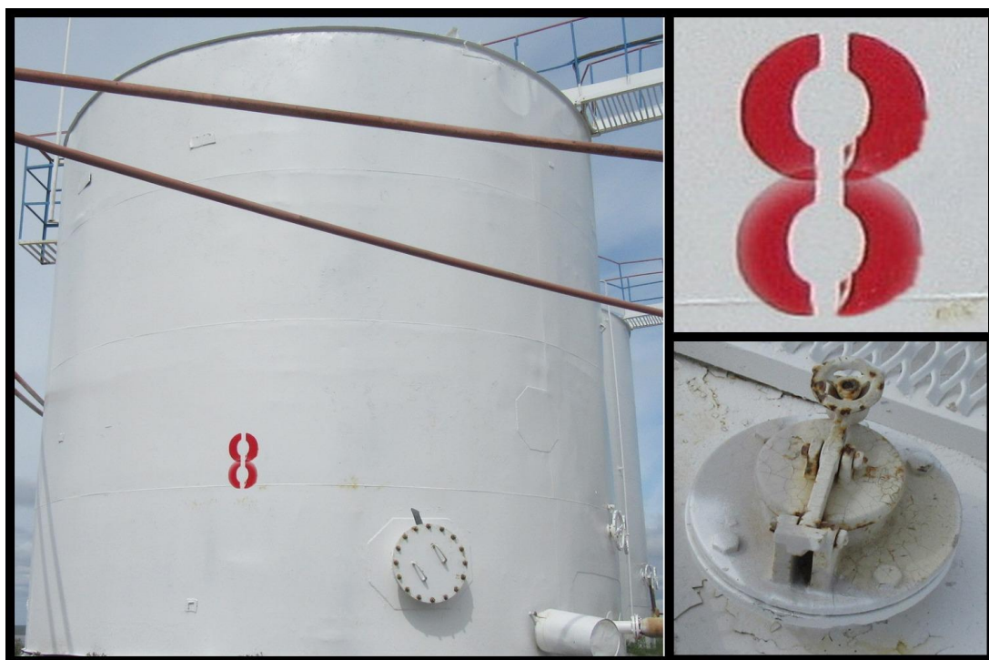
Рисунок 1 - Общий вид резервуаров РВС-200 №8
