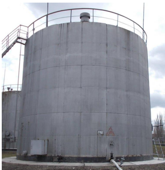
Рисунок 1 – Общий вид резервуаров РВСП-700
