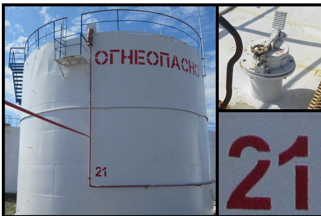
Рисунок 10 - Общий вид резервуаров РВС-1000 № 21
