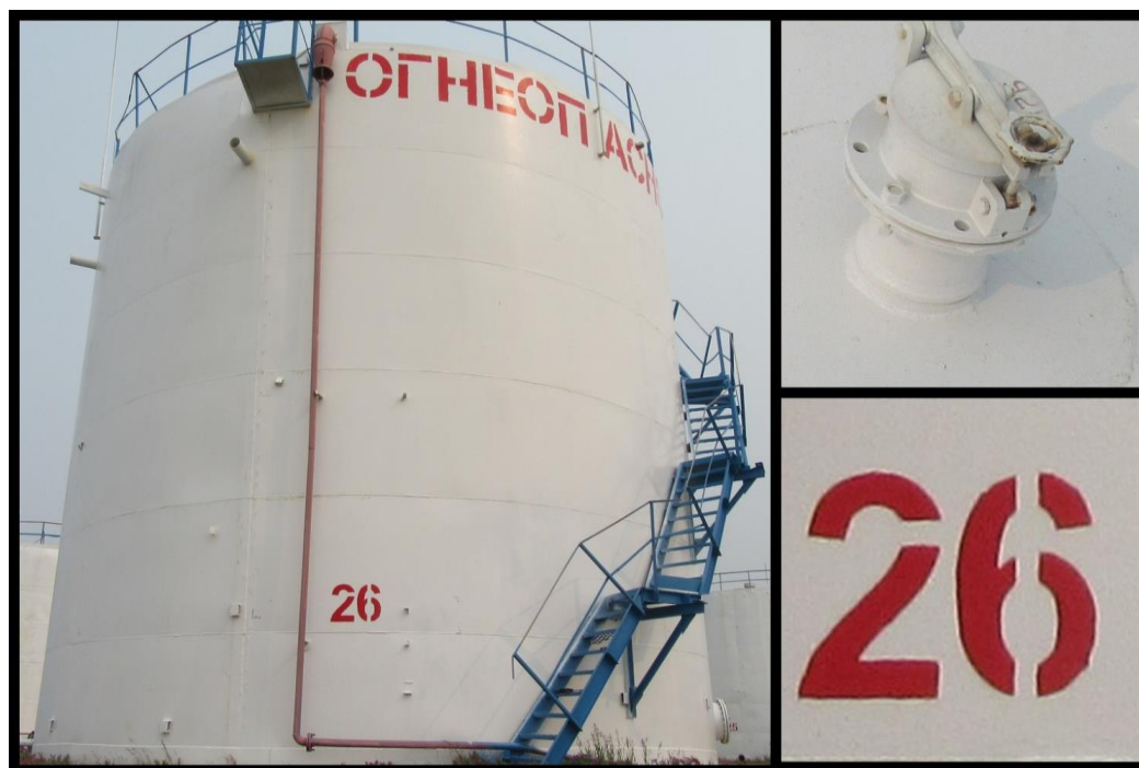
Рисунок 7 - Общий вид резервуаров РВС-700 № 26
