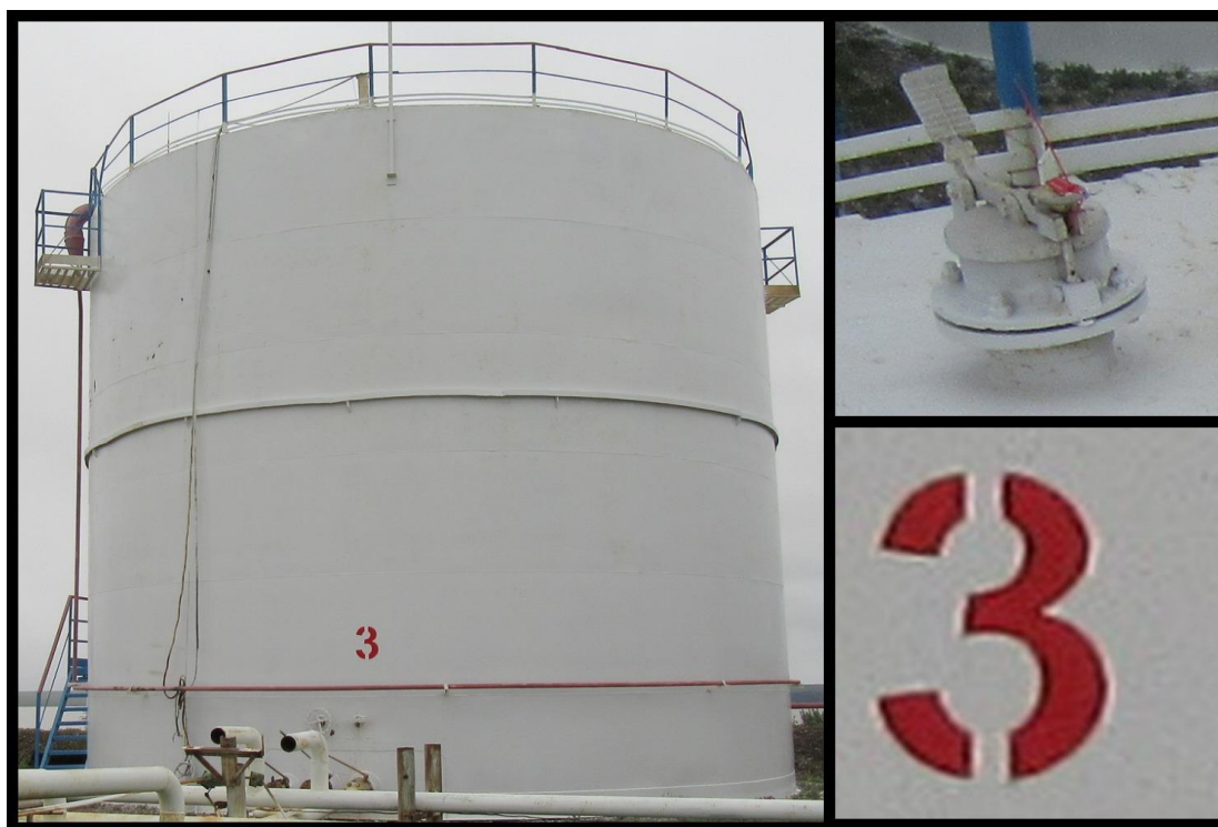
Рисунок 5 - Общий вид резервуаров РВС-700 № 3
