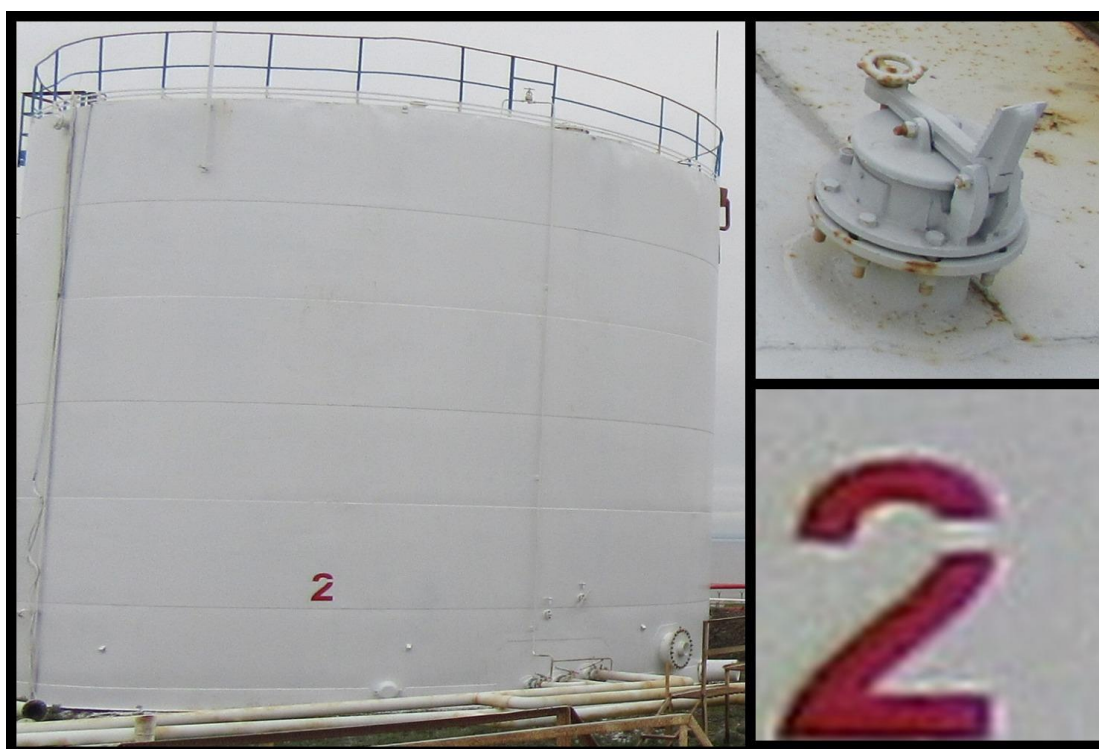
Рисунок 4 - Общий вид резервуаров РВС-700 № 2
