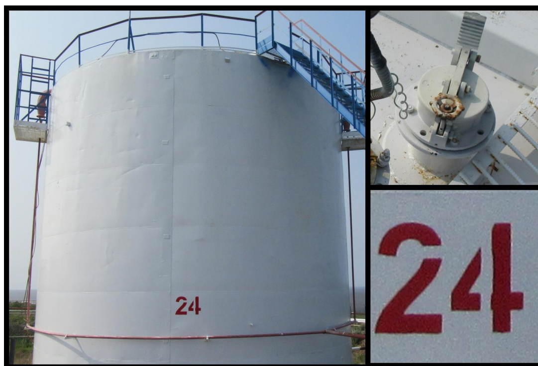
Рисунок 6 - Общий вид резервуаров РВС-700 № 24
