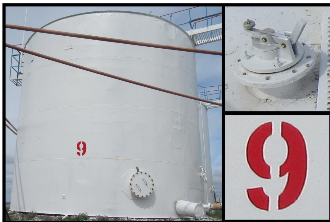
Рисунок 2 - Общий вид резервуаров РВС-200 № 9
