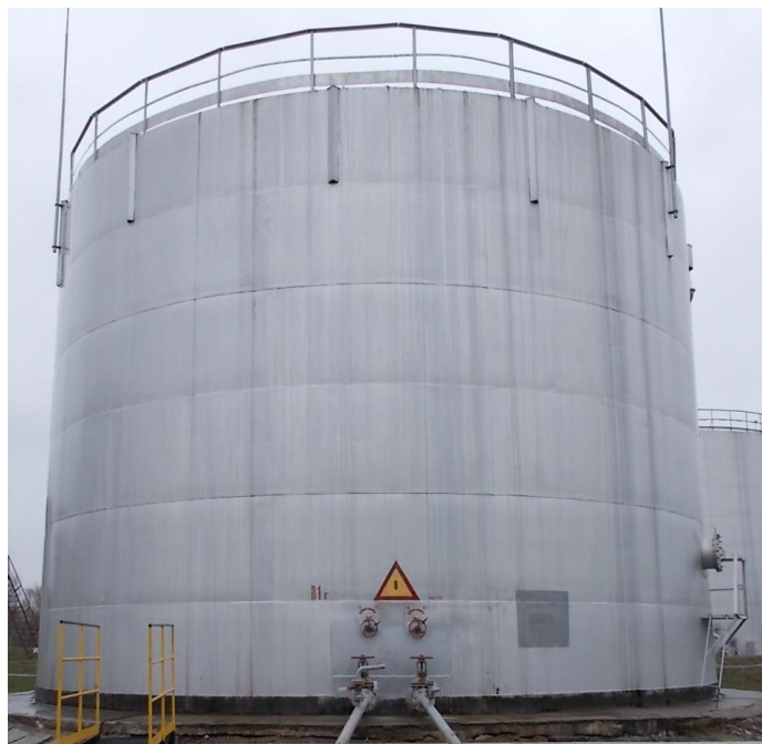
Рисунок 2 – Общий вид резервуаров РВСП-1000
