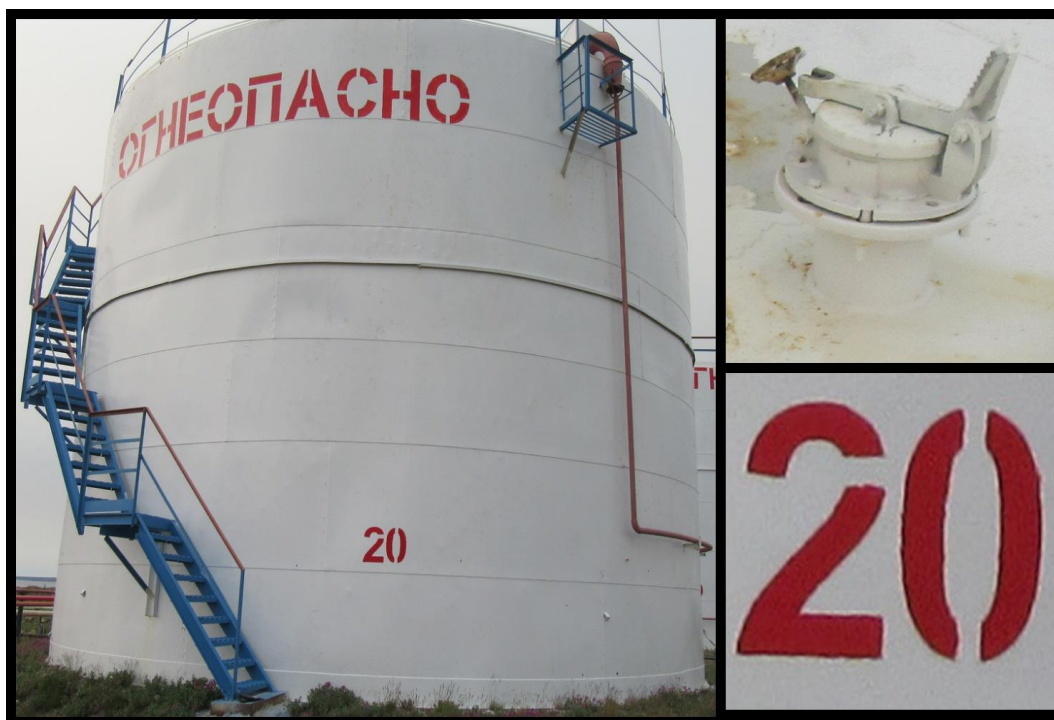
Рисунок 9 - Общий вид резервуаров РВС-1000 № 20
