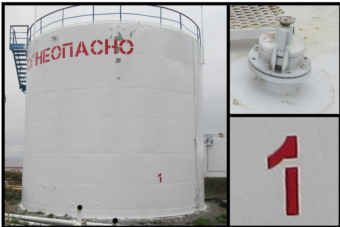
Рисунок 3 - Общий вид резервуаров РВС-700 № 1
