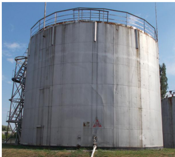
Рисунок 2 – Общий вид резервуаров РВС-1000
