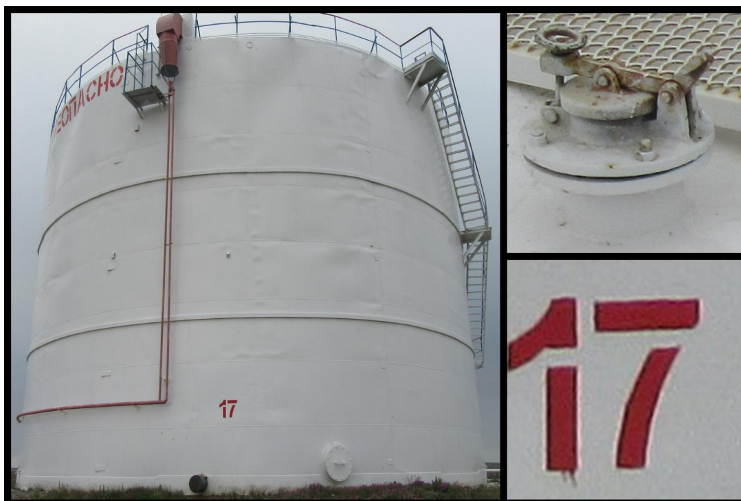
Рисунок 11 - Общий вид резервуаров PBC-3000 № 17
