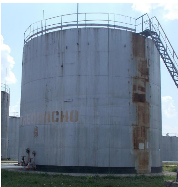
Рисунок 1 – Общий вид резервуаров РВСП-700
