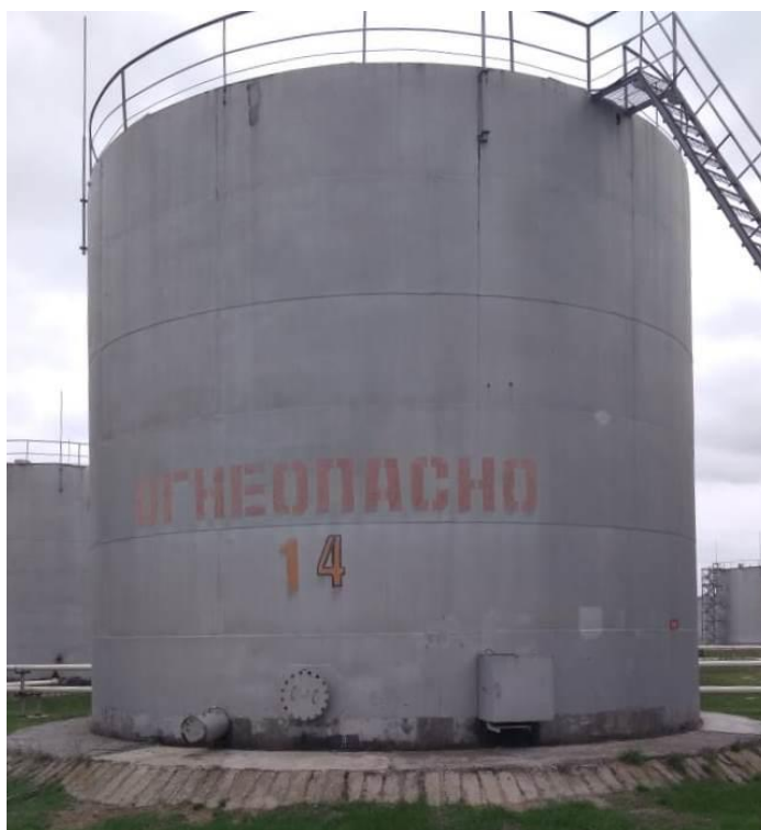
Рисунок 1 – Общий вид резервуаров РВС-700
