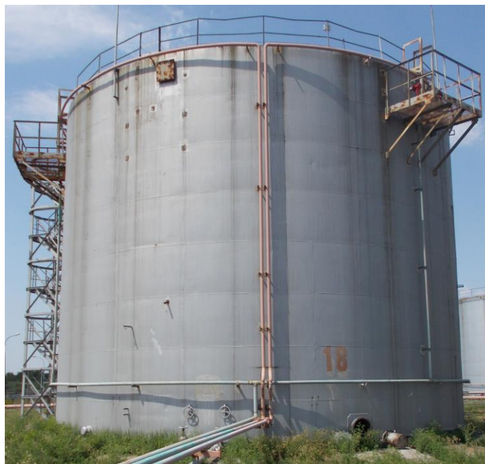
Рисунок 2 – Общий вид резервуаров РВС-2000
