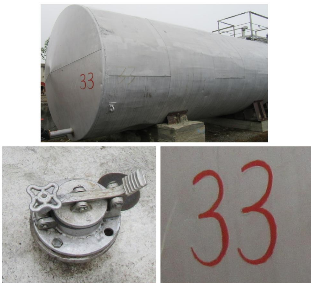
Рисунок 4 - Общий вид резервуара РГС-75 № 33
