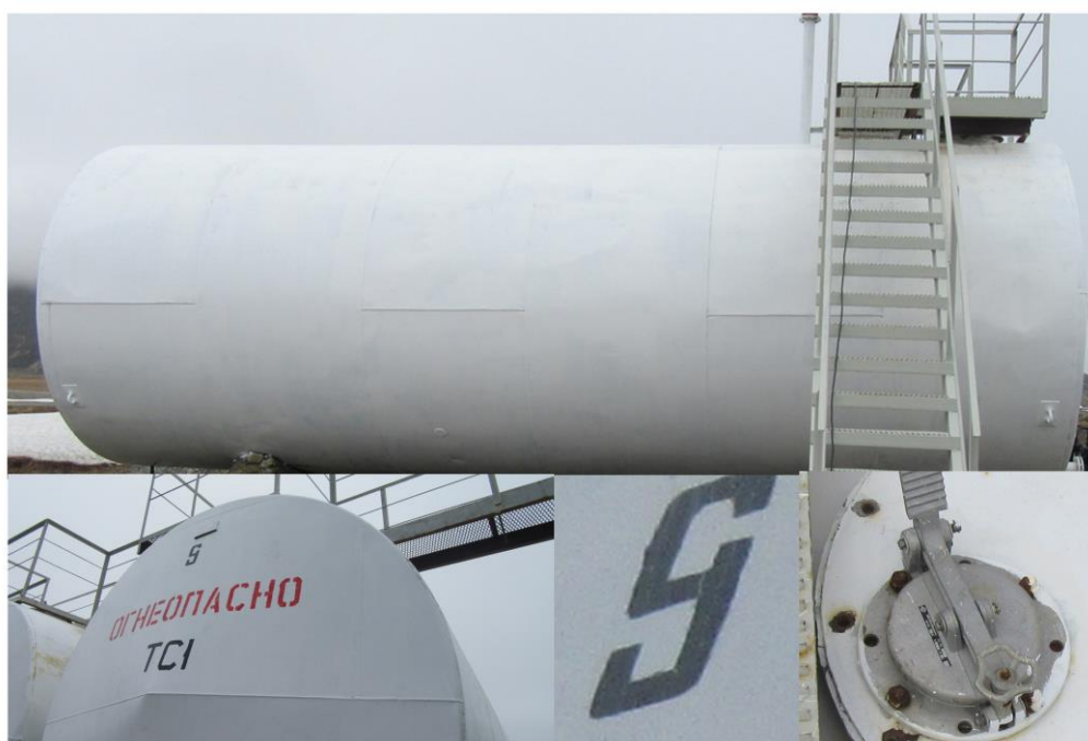
Рисунок 8 - Общий вид резервуара РГС-75 №9
