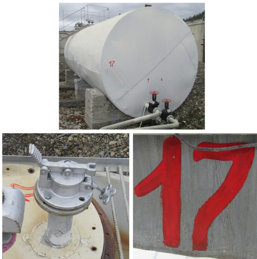
Рисунок 1 - Общий вид резервуара РГС-50 № 17
