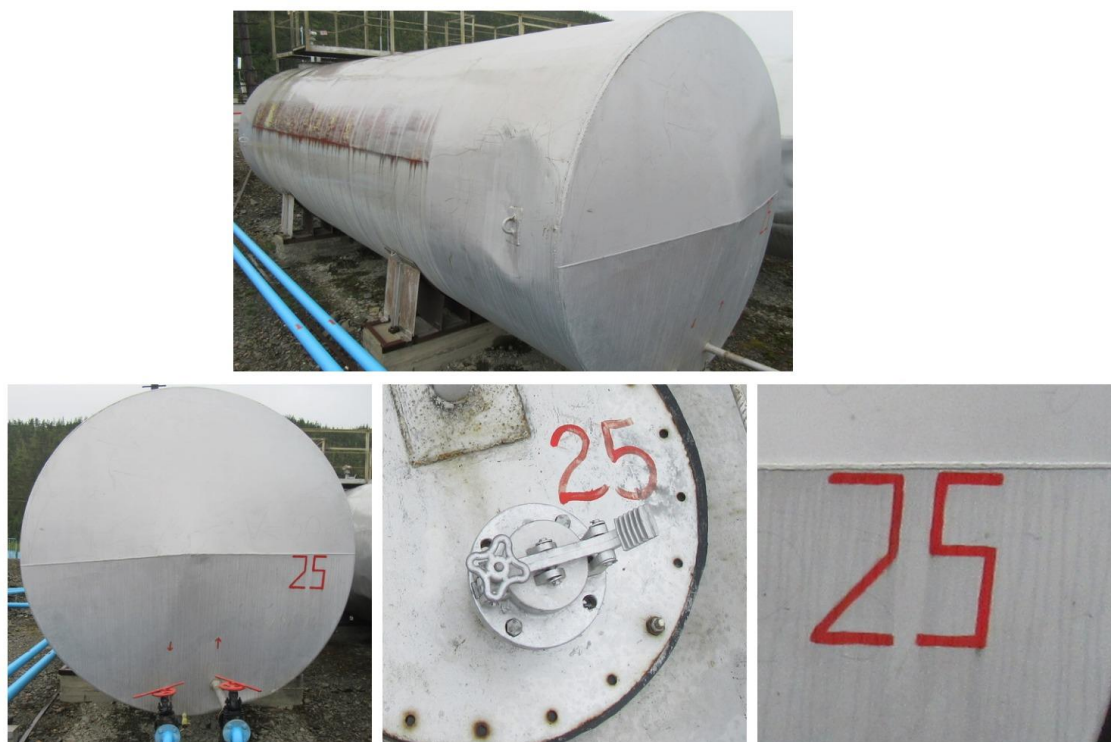
Рисунок 2 - Общий вид резервуара РГС-50 № 25
