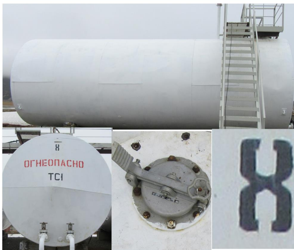
Рисунок 7 - Общий вид резервуара РГС-75 №8
