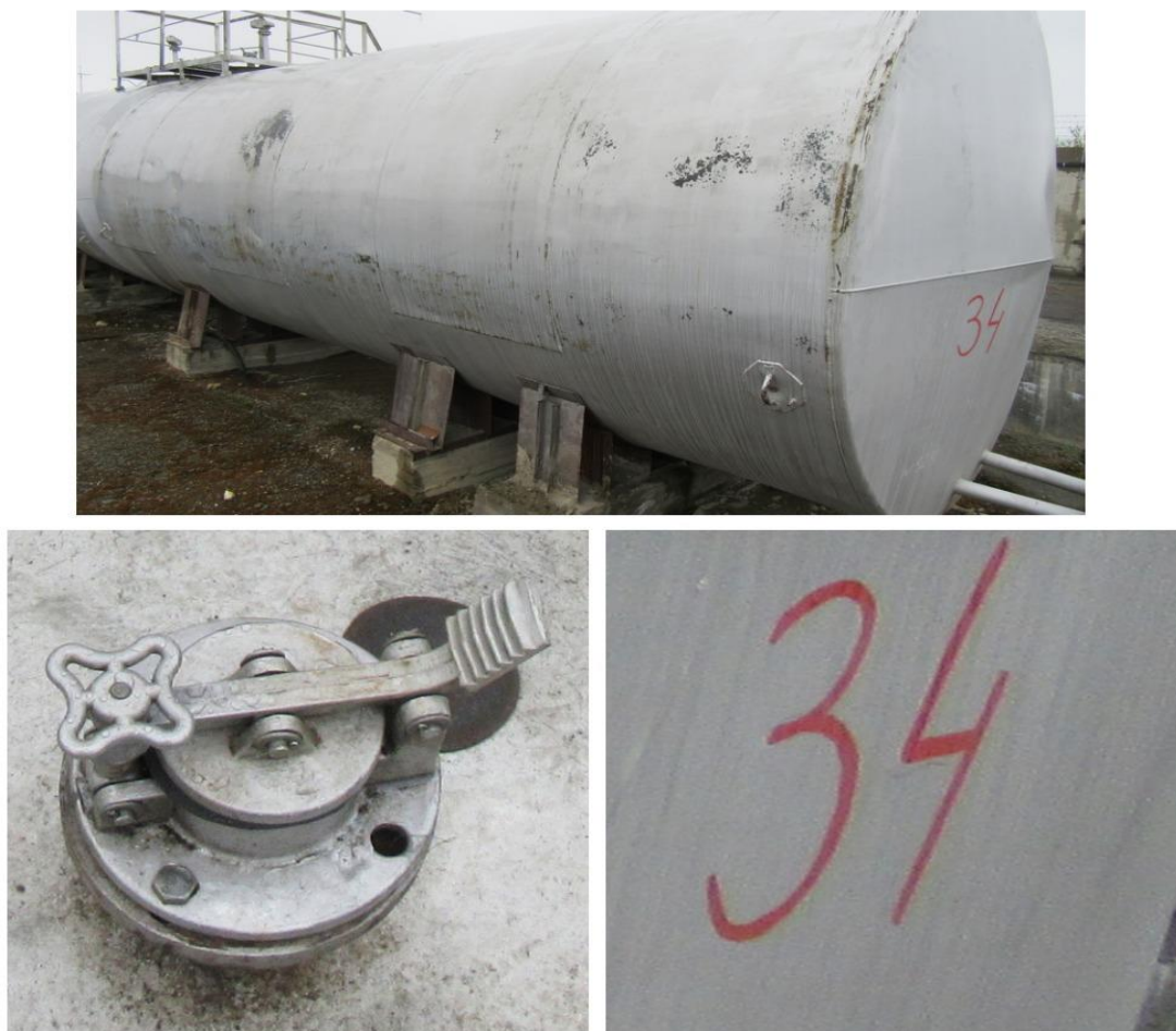
Рисунок 5 - Общий вид резервуара РГС-75 № 34
