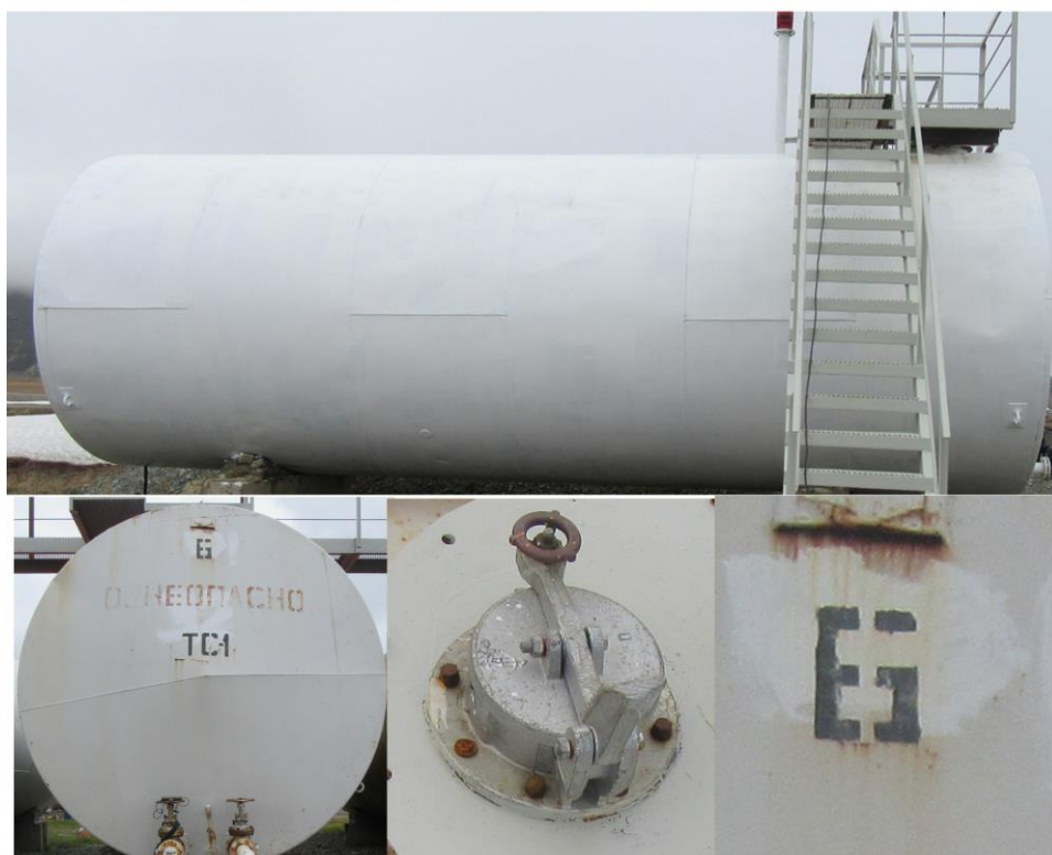
Рисунок 5 - Общий вид резервуара РГС-75 №6
