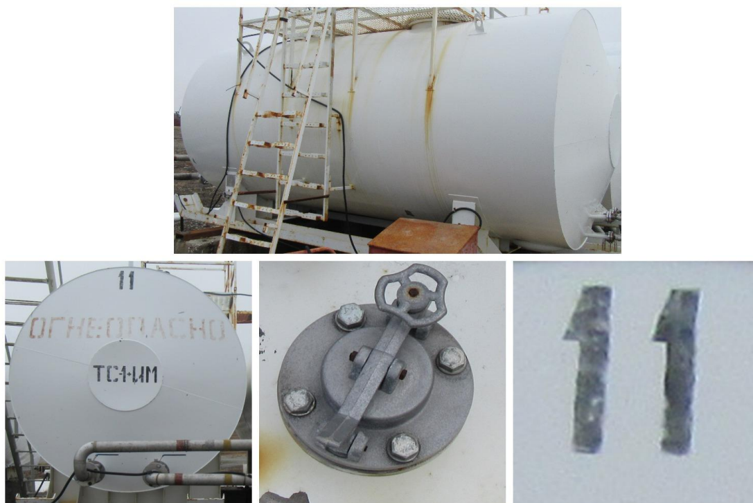
Рисунок 1 - Общий вид резервуара РГС-15 №11
