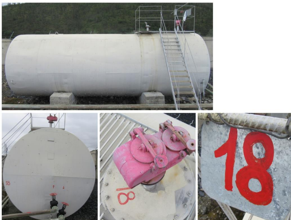
Рисунок 3 - Общий вид резервуара РГС-75 № 18
