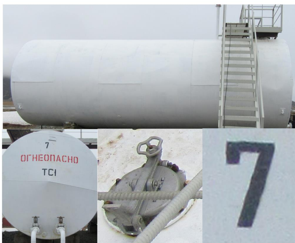
Рисунок 6 - Общий вид резервуара РГС-75 №7
