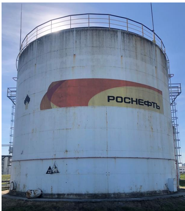
Рисунок 1 – Общий вид резервуаров РВСП-2000
