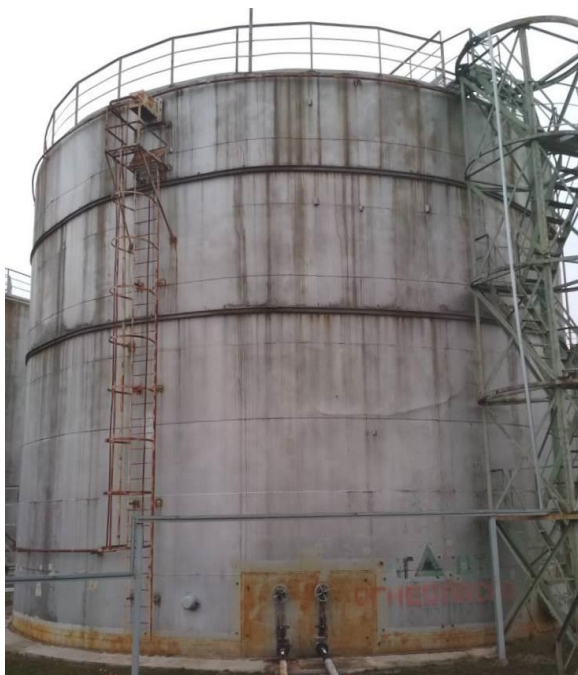
Рисунок 1 – Общий вид резервуаров РВС-2000
