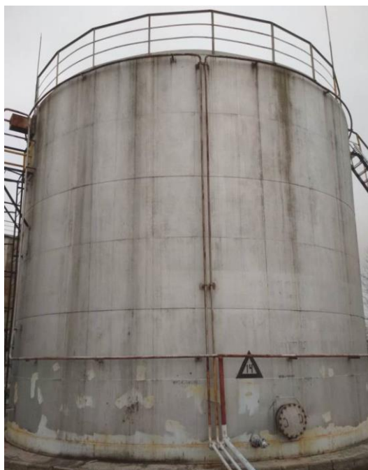
Рисунок 1 – Общий вид резервуара РВСП-700
