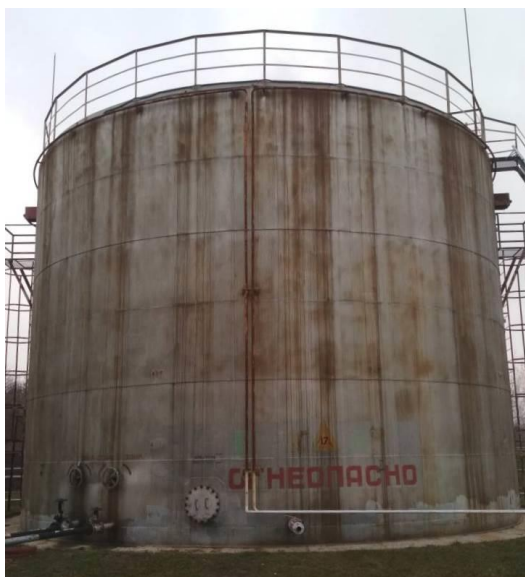
Рисунок 1 – Общий вид резервуаров РВС-1000
