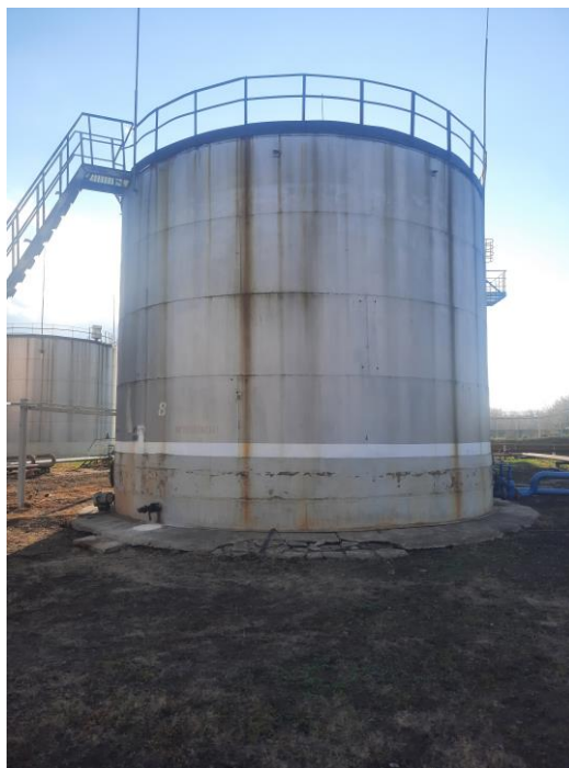
Рисунок 1 – Общий вид резервуара РВС-400
