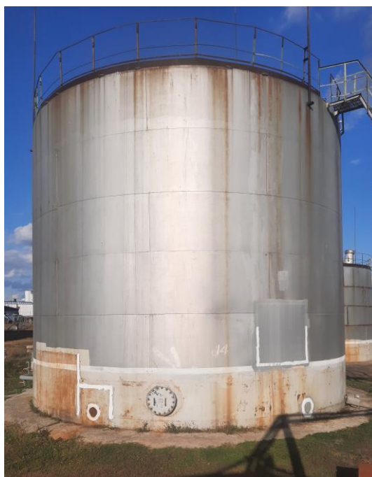
Рисунок 1 – Общий вид резервуаров РВС-700
