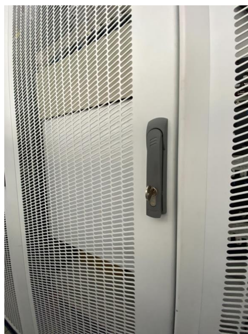
Рисунок 3 - Место блокировки от несанкционированного доступа к статам с оборудованием
