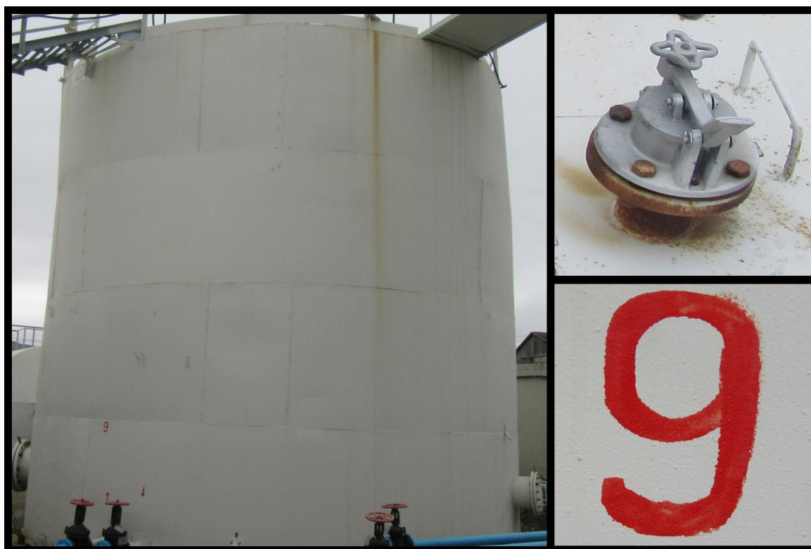
Рисунок 1 – Общий вид резервуара РВС-200 с заводским номером 9
