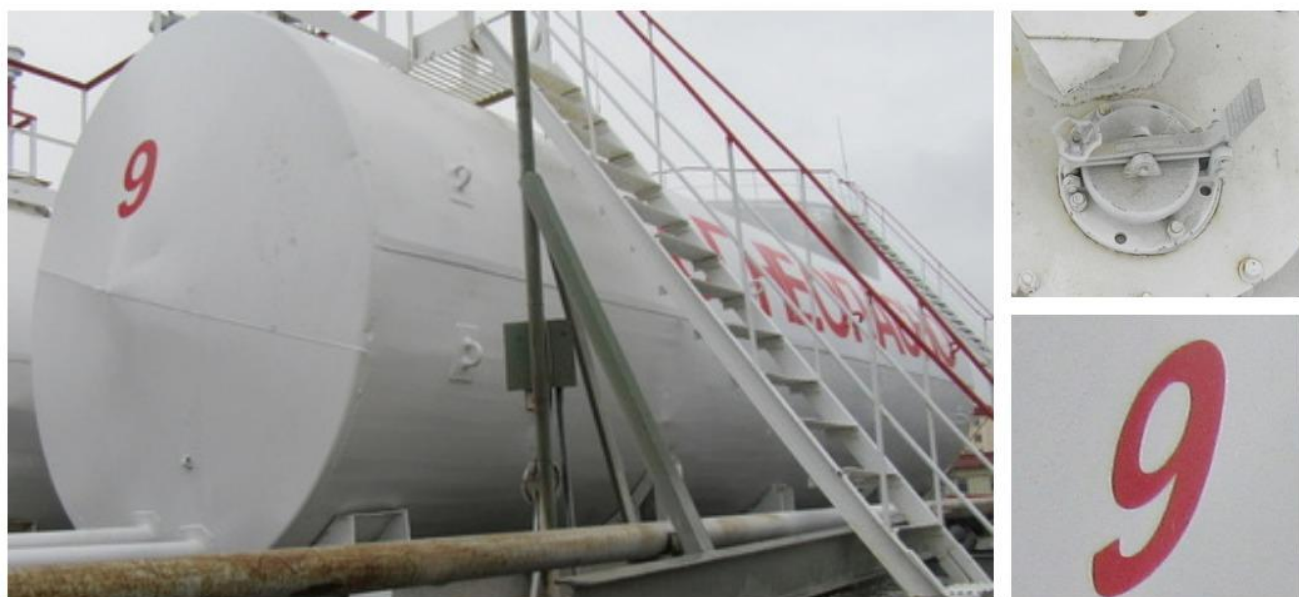
Рисунок 2 – Общий вид резервуара РГС-50 с заводским номером 9
