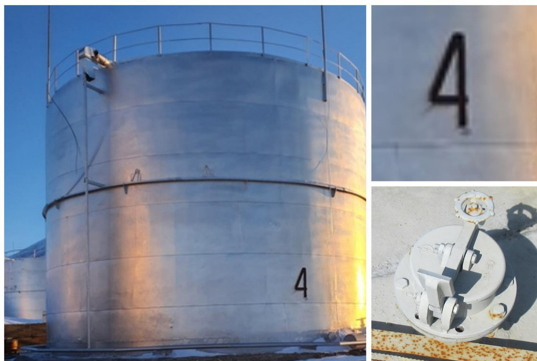
Рисунок 4 – Общий вид резервуара РВС-1000 с заводским номером 4
