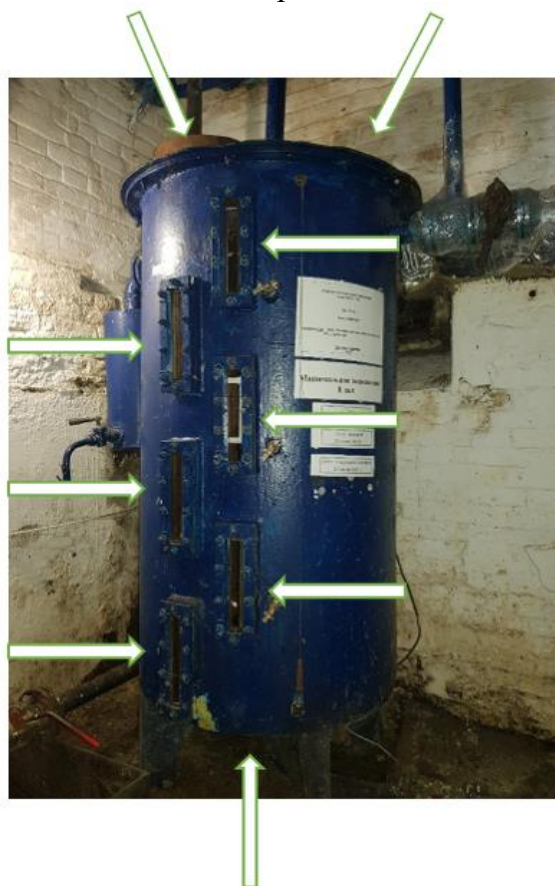
Рисунок 2 – Схема пломбировки мерника ММТ-70У, зав.№ 16 от несанкционированного доступа, обозначение места нанесения знака поверки
