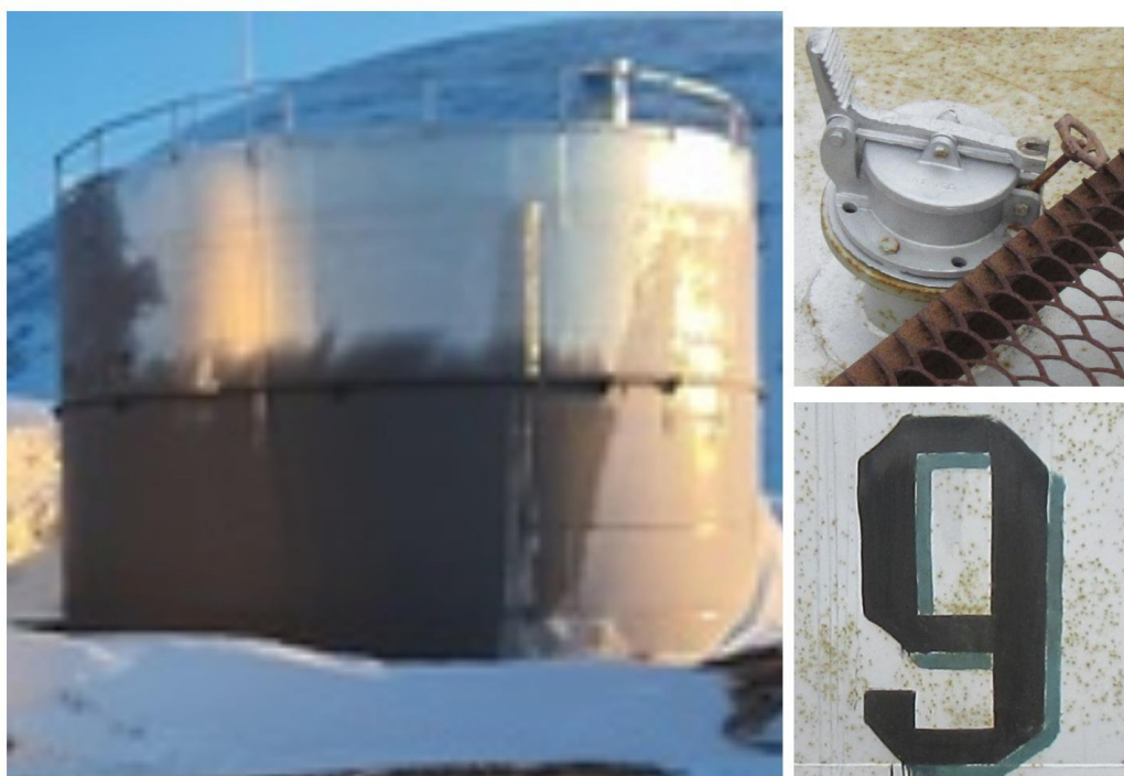
Рисунок 8 – Общий вид резервуара РВС-1000 с заводским номером 9
