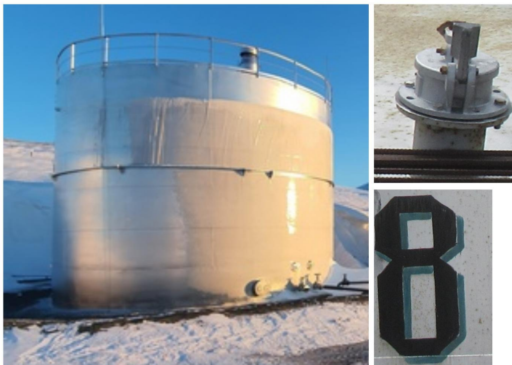
Рисунок 7 – Общий вид резервуара РВС-1000 с заводским номером 8
