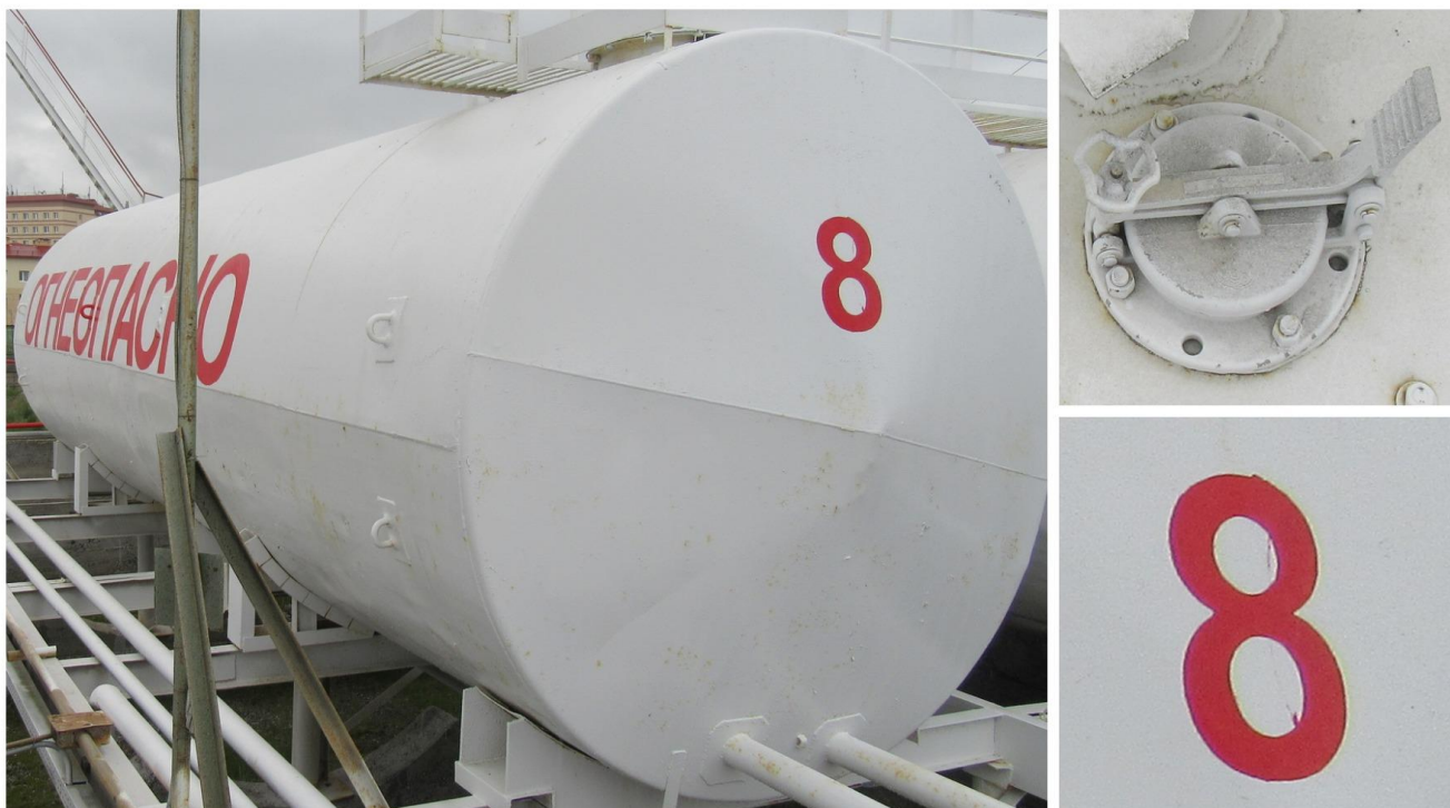
Рисунок 1 – Общий вид резервуара РГС-50 с заводским номером 8
