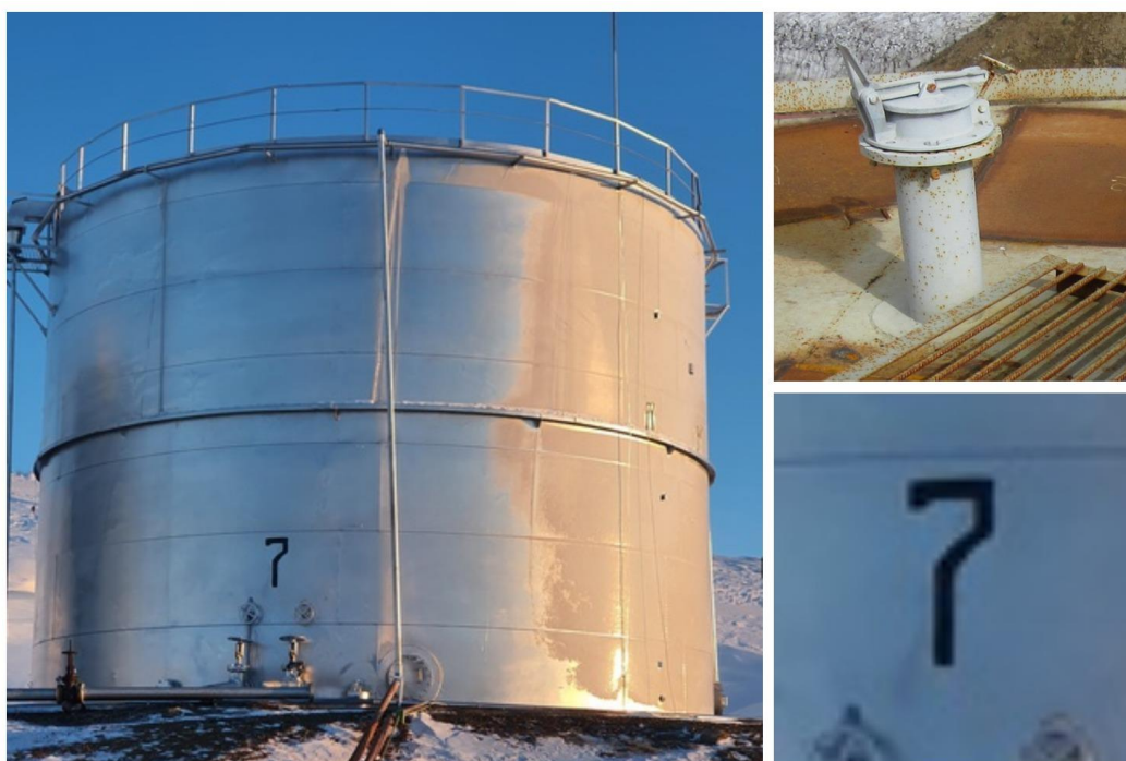
Рисунок 6 – Общий вид резервуара РВС-1000 с заводским номером 7
