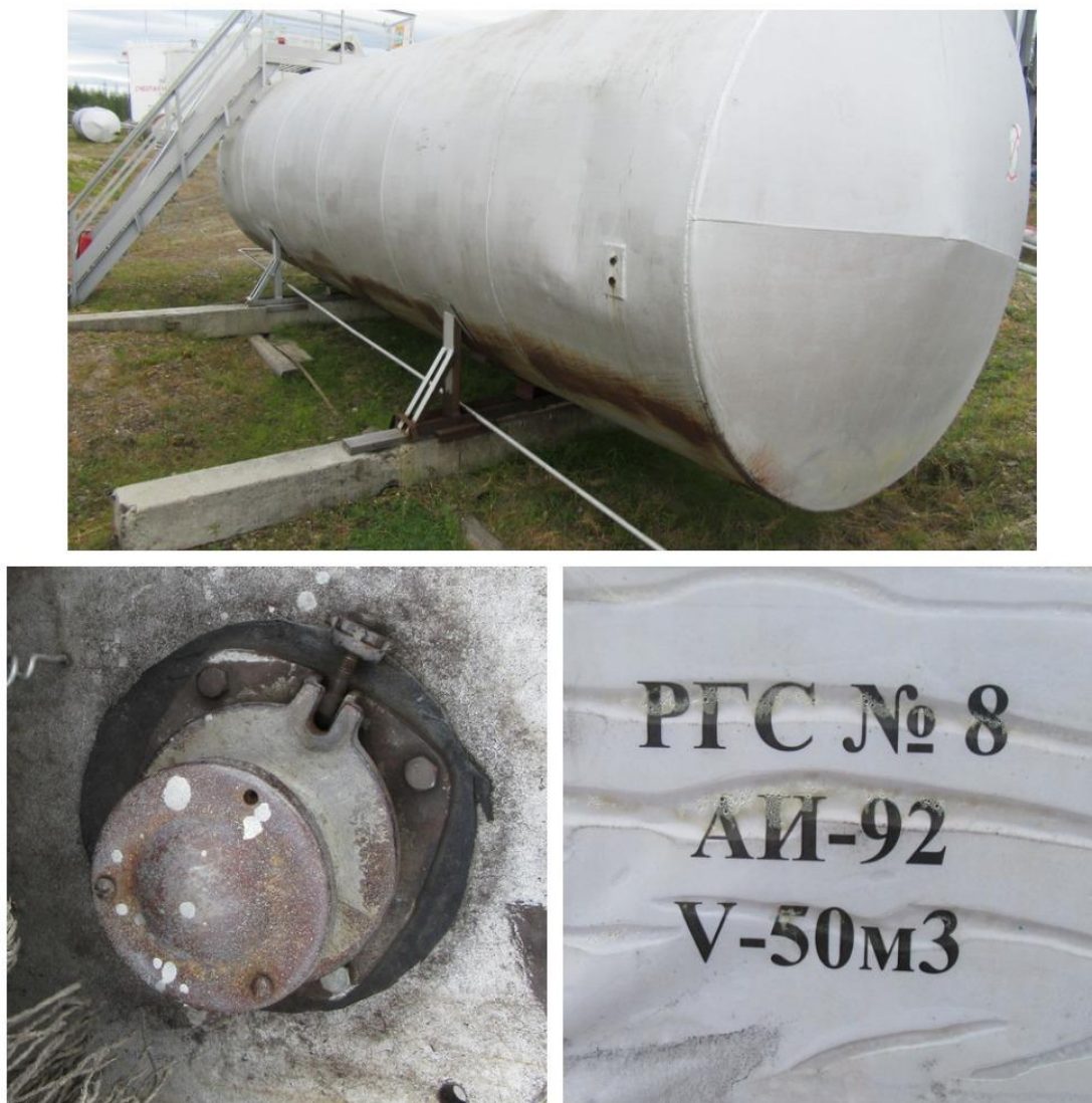
Рисунок 2 – Общий вид резервуара РГС-50 с заводским номером 8
