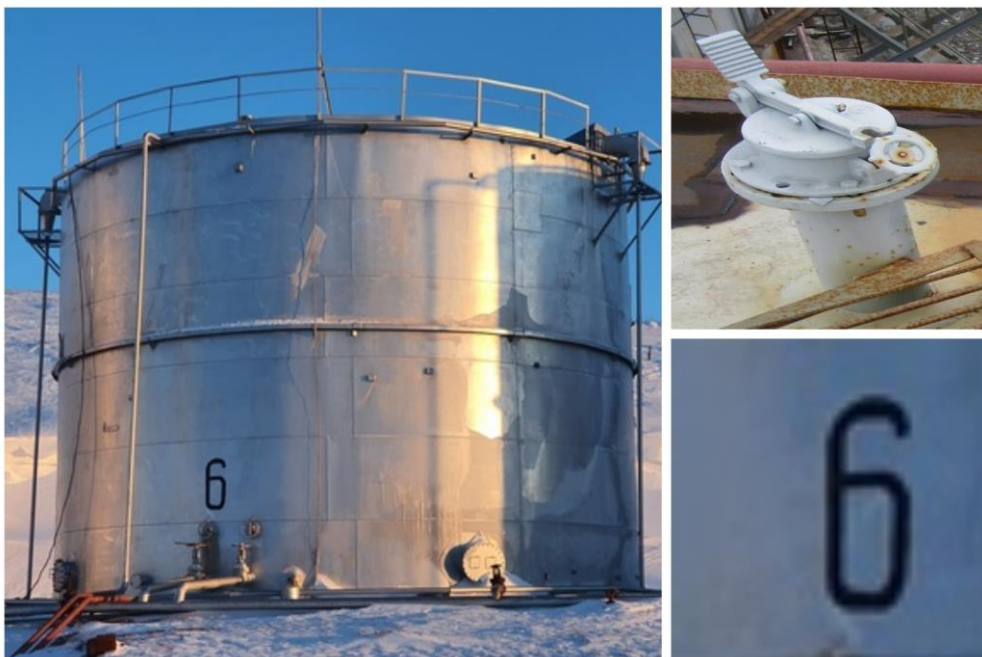
Рисунок 5 – Общий вид резервуара РВС-1000 с заводским номером 6
