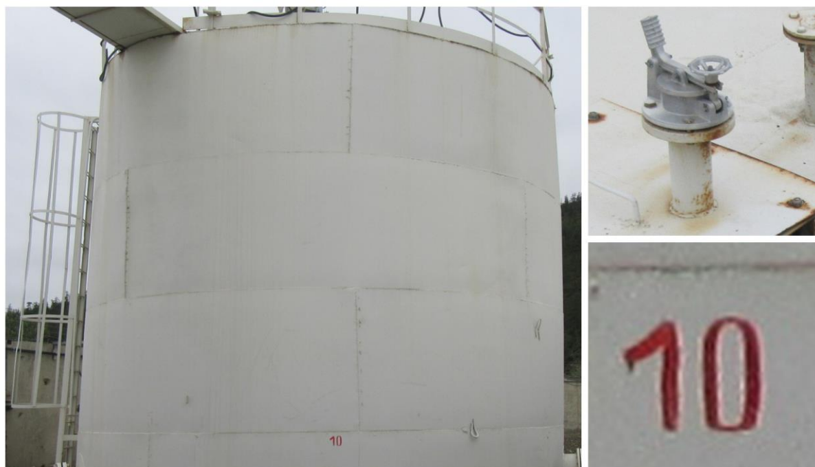
Рисунок 2 – Общий вид резервуара РВС-200 с заводским номером 10
