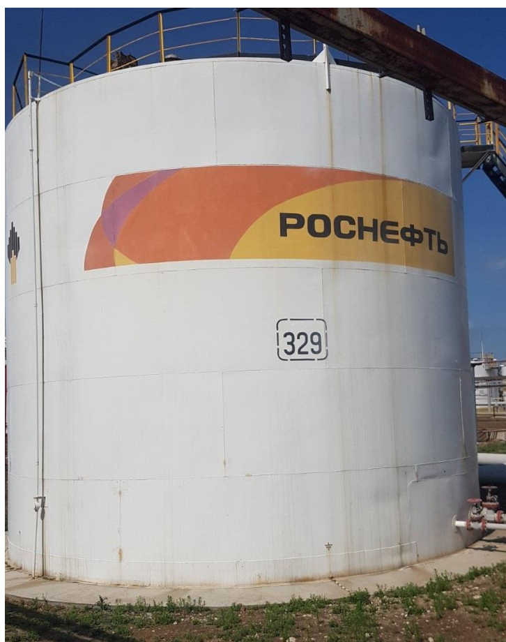
Рисунок 3 – Общий вид резервуара РВС-1000
