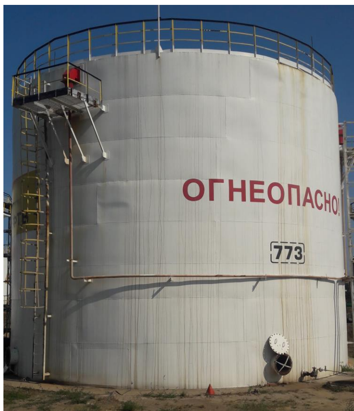
Рисунок 4 – Общий вид резервуаров РВС-2000
