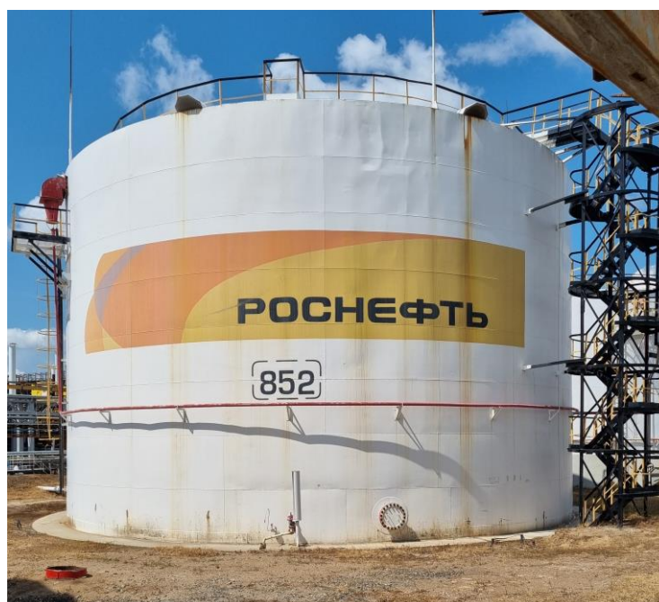
Рисунок 5 – Общий вид резервуаров РВС-3000
