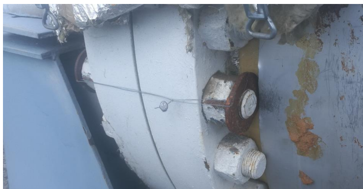
Рисунок 3 – Схема пломбировки фланцевых соединений
