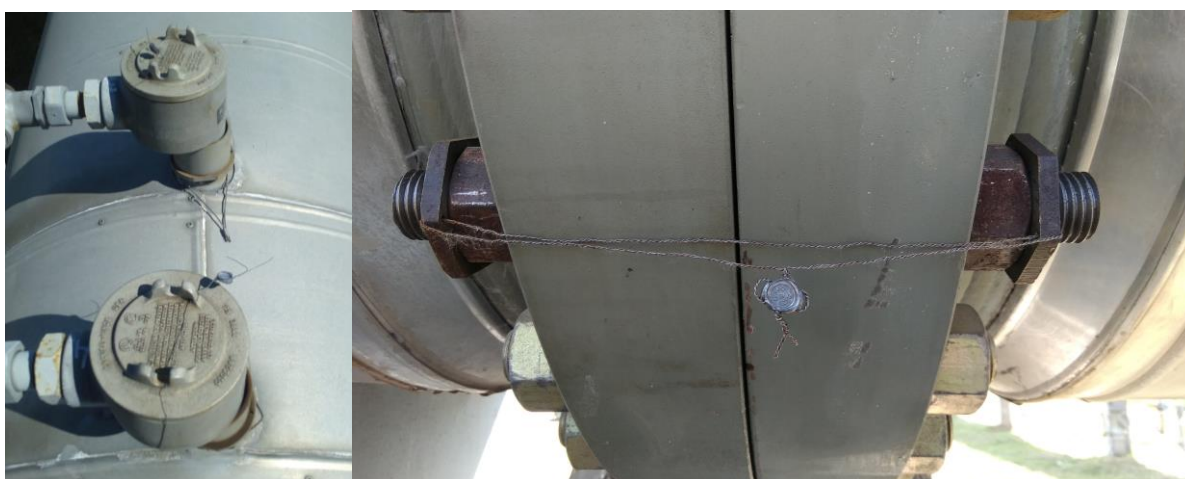
Рисунок 2 – Схема пломбировки детекторов и фланцевых соединений
