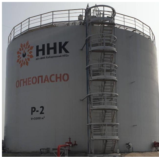
Рисунок 2 – Общий вид резервуара с зав. № 2
