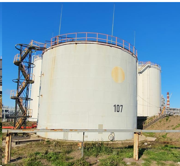
Рисунок 2 – Общий вид резервуара с зав. № 107
