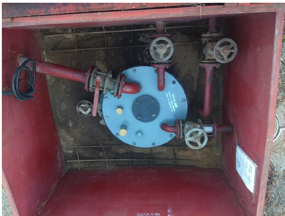
Рисунок 2- Фотография крышки замерного люка резервуара стального горизонтального цилиндрического двустенного РГД-25 заводской номер 19/4.04-01
