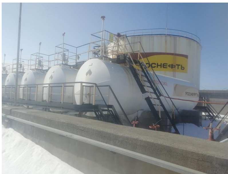
Рисунок 1 – Общий вид резервуаров РГС-65
