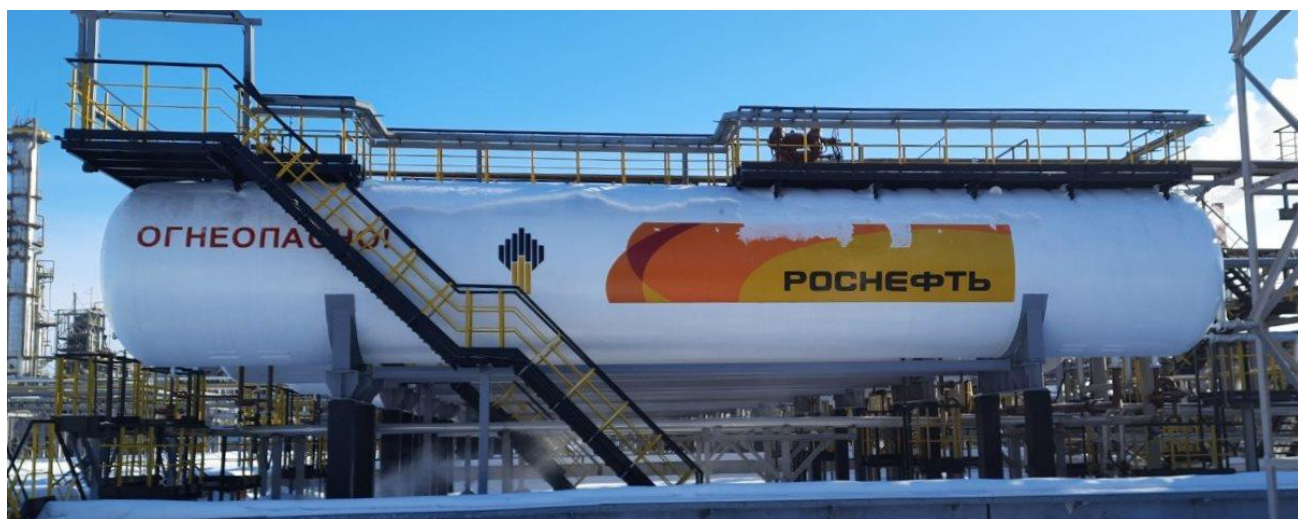
Рисунок 1 – Общий вид резервуаров
