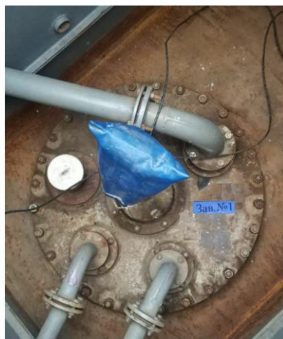
Рисунок 1 – Общий вид резервуара РГС-50
