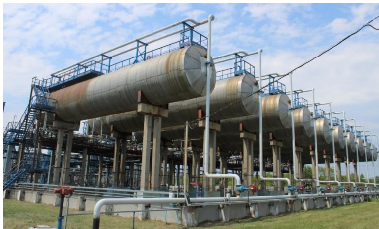
Рисунок 1 – Общий вид резервуаров
