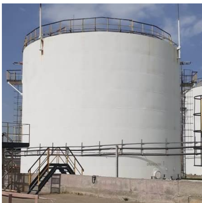
Рисунок 4 – Общий вид резервуаров РВС-2000
