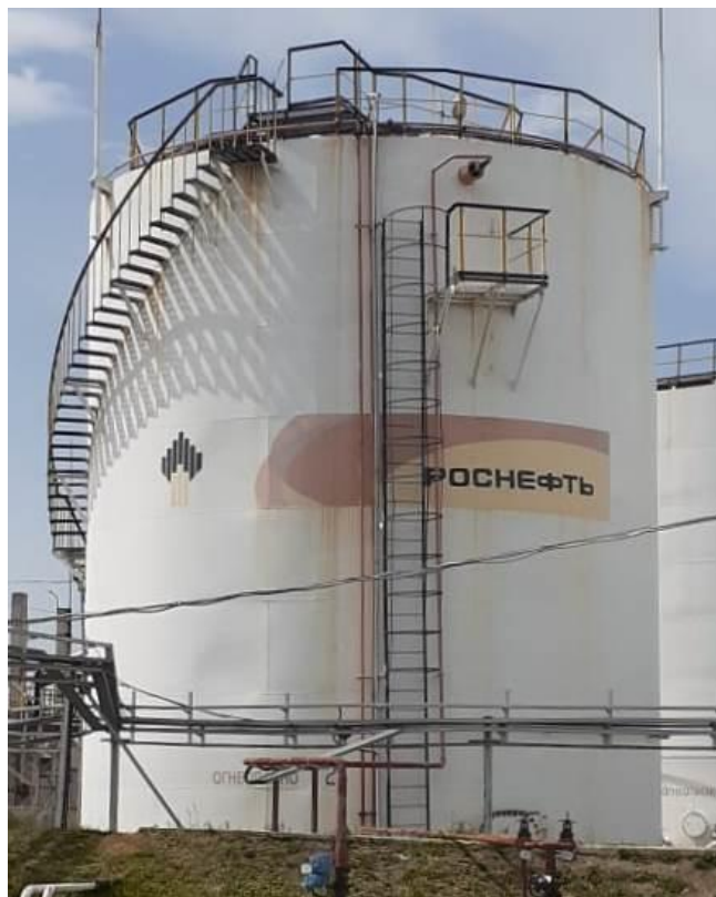
Рисунок 3 – Общий вид резервуаров РВС-1000
