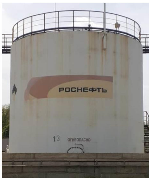
Рисунок 2 – Общий вид резервуаров РВС-700
