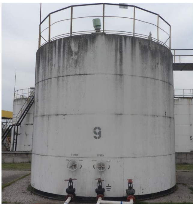
Рисунок 1 – Общий вид резервуаров РВС-200
