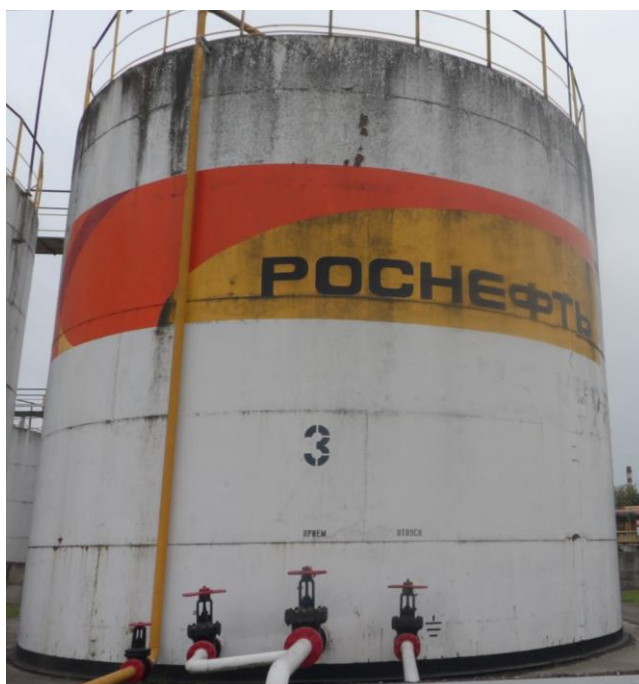
Рисунок 2 – Общий вид резервуаров РВС-400
