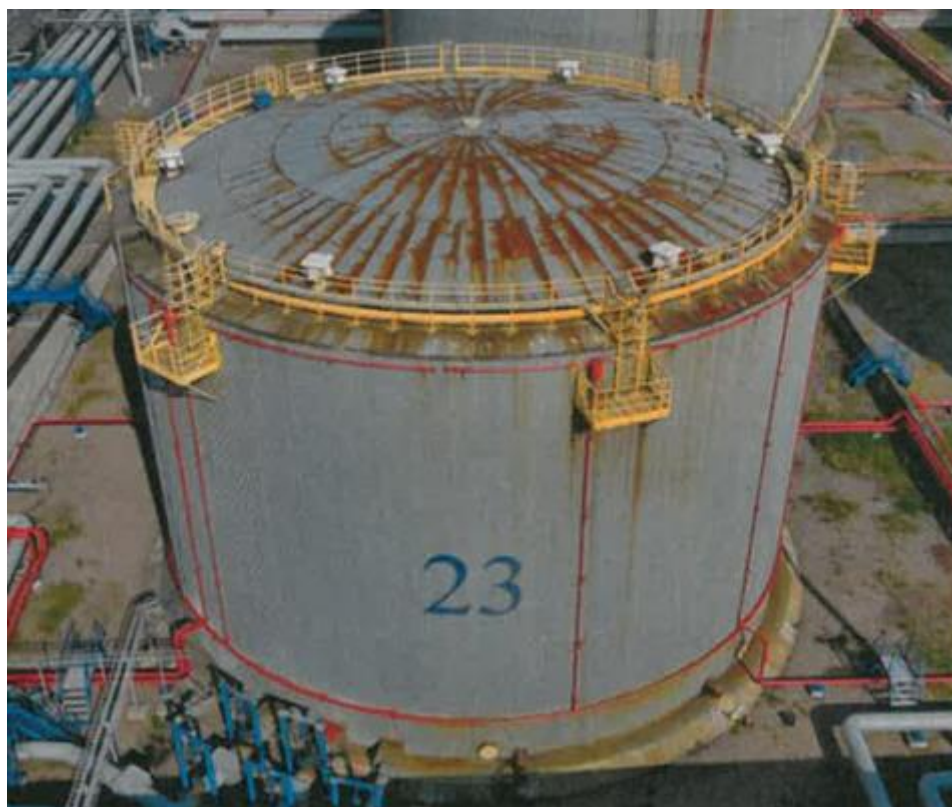
Рисунок 1 – Общий вид резервуара РВС-10000 зав. № 23
