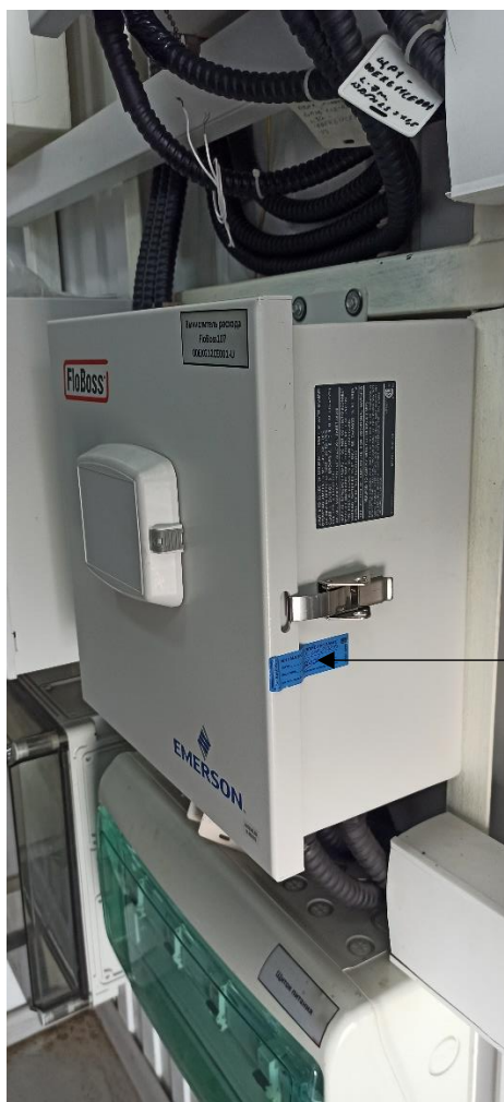
Рисунок 2 – Место нанесения пломб на шкаф измерительного контроллера ROC/FloBoss 107 Нанесение знака поверки на систему не предусмотрено.
