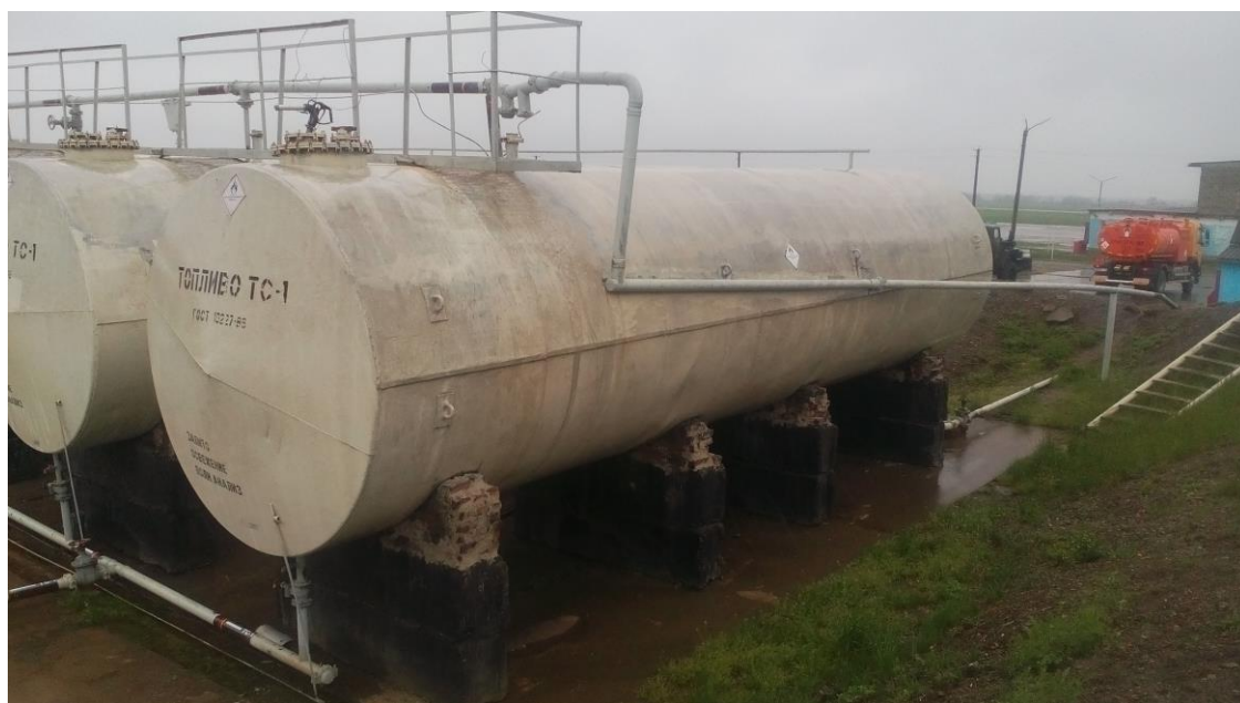
Рисунок 1 – Общий вид резервуаров РГС-60
