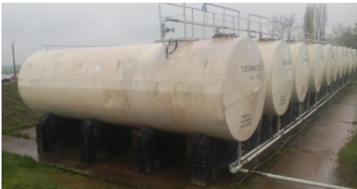
Рисунок 1 – Общий вид резервуаров РГС-50
