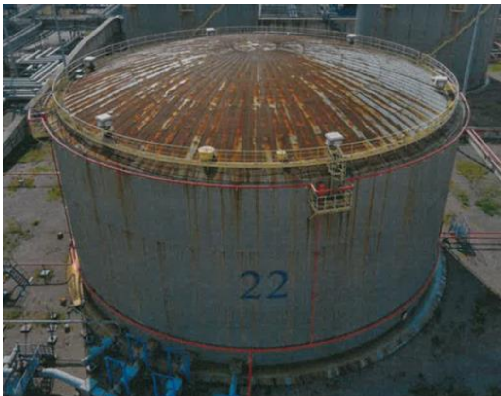
Рисунок 5 – Общий вид резервуара РВС-20000 зав. № 22
