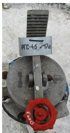
Рисунок 8 – Фотография горловины, замерного люка и заводского номера резервуара стального горизонтального цилиндрического РГС, модификации РГС-4,6 зав.№ 17a
