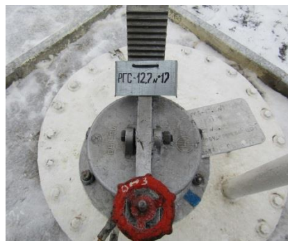
Рисунок 14 – Фотография горловины, замерного люка и заводского номера резервуара стального горизонтального цилиндрического РГС, модификации РГС-12,7 зав.№ 17
