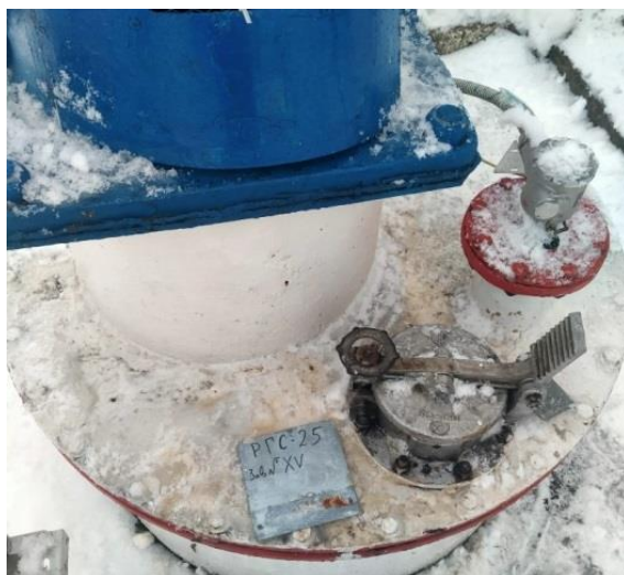
Рисунок 17 – Фотография горловины, замерного люка и заводского номера резервуара стального горизонтального цилиндрического РГС, модификации РГС-25 зав.№ XV
