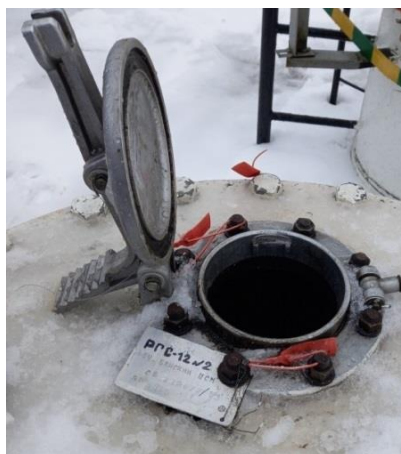
Рисунок 12 – Фотография горловины, замерного люка и заводского номера резервуара стального горизонтального цилиндрического РГС, модификации РГС-12 зав.№ 2
