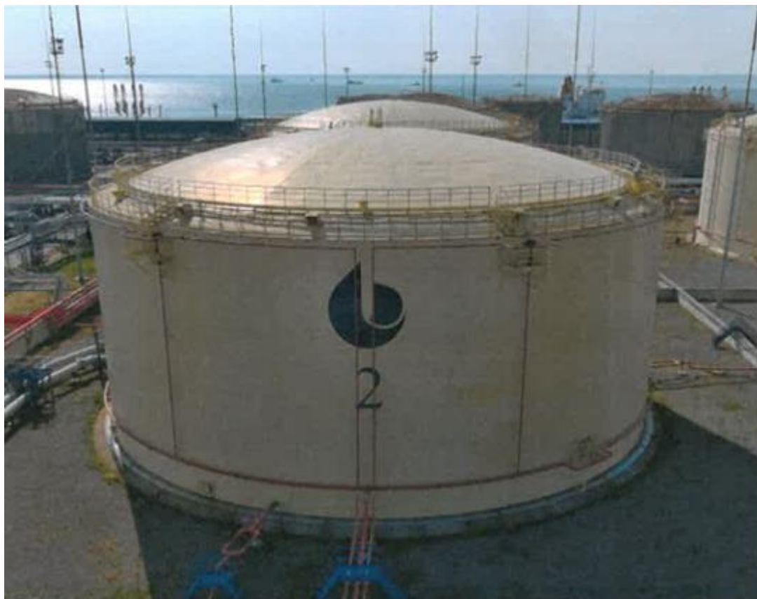
Рисунок 2 – Общий вид резервуара РВСП-30000 зав. № 2
