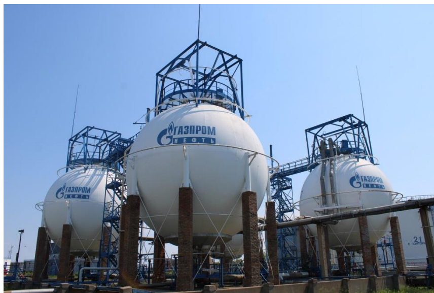
Рисунок 1 – Общий вид резервуаров стальных сферических (шаровых) РШС-600
