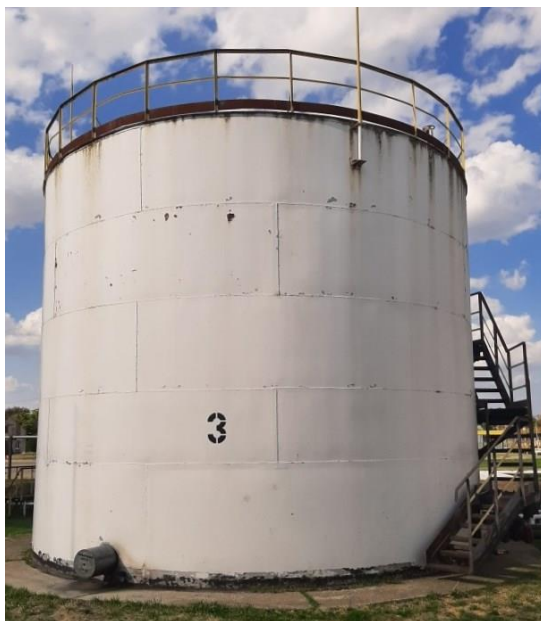
Рисунок 2 – Общий вид резервуаров РВС-400
