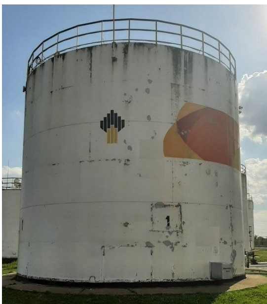
Рисунок 3 – Общий вид резервуаров РВС-700
