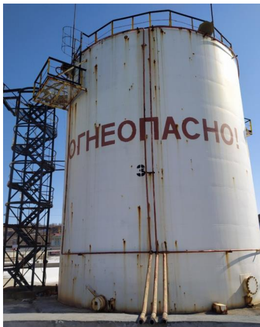
Рисунок 1 – Общий вид резервуара РВСП-1000
