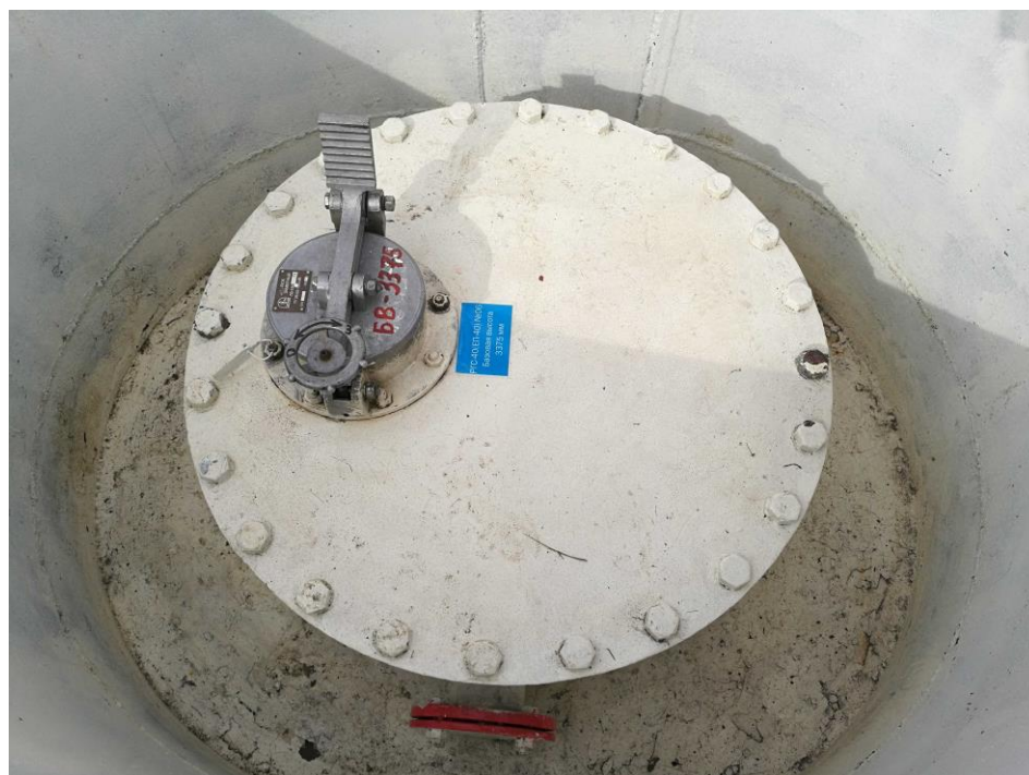
Рисунок 3 – Общий вид резервуара РГС-40
