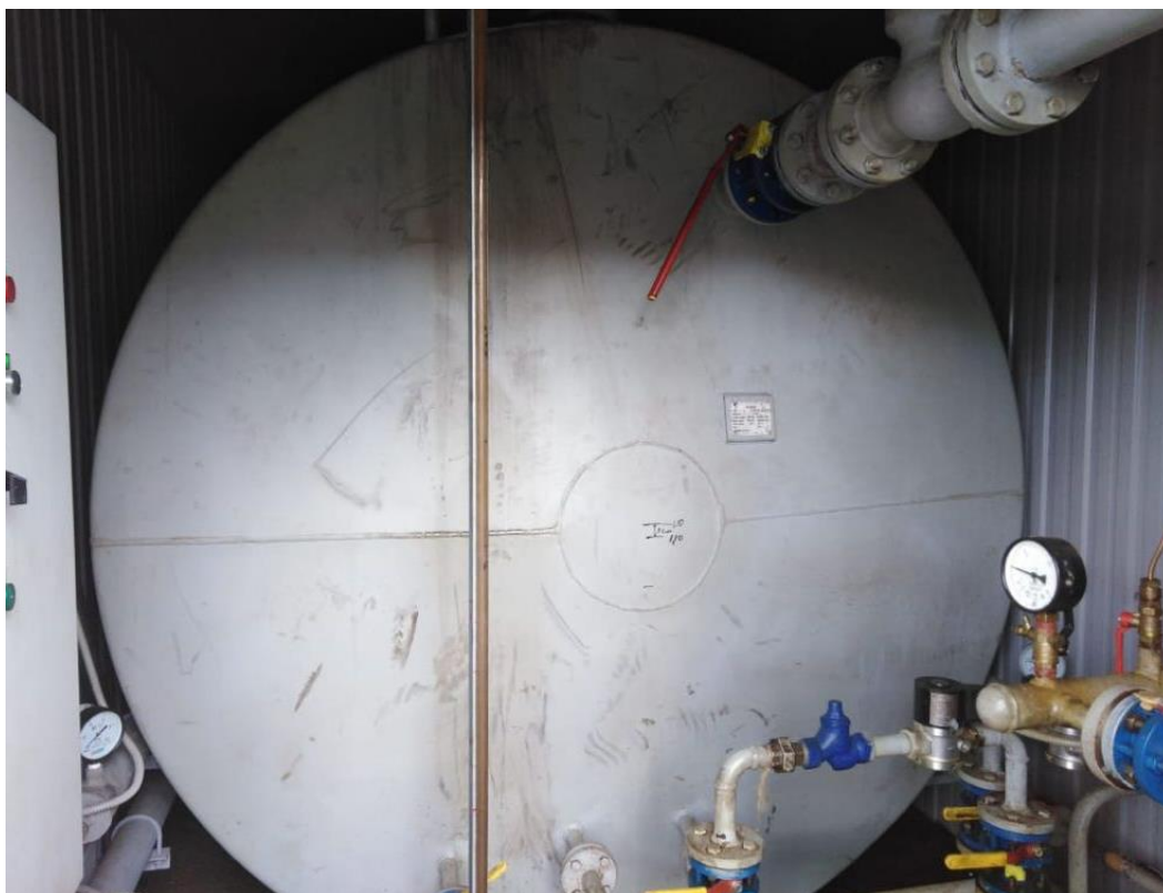
Рисунок 2 – Общий вид резервуаров Р-25
