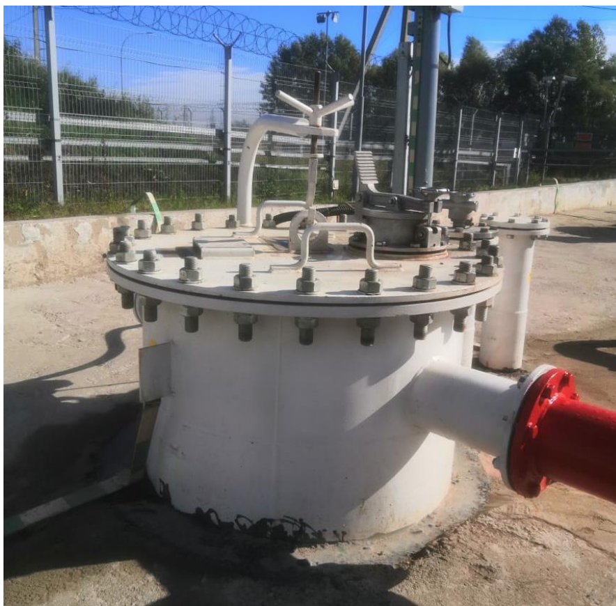
Рисунок 2 – Общий вид резервуара РГС-8
