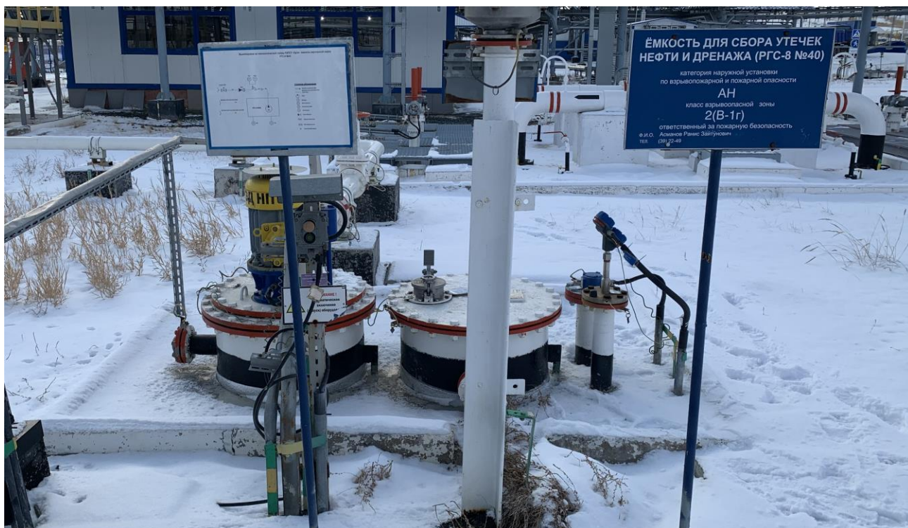
Рисунок 2 – Общий вид резервуара РГС-8
