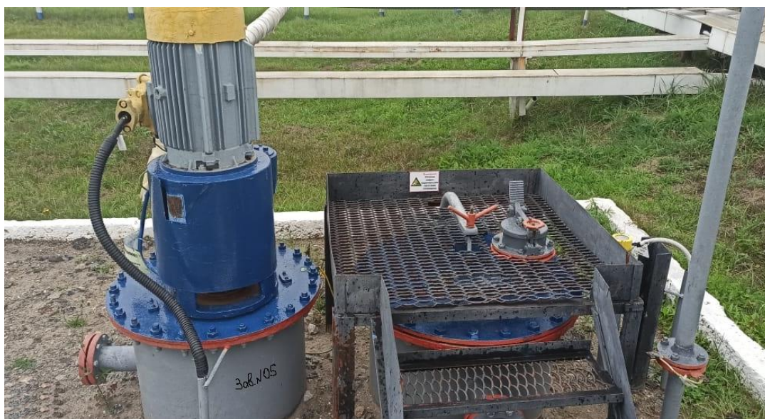
Рисунок 1 – Общий вид резервуара РГС-8
