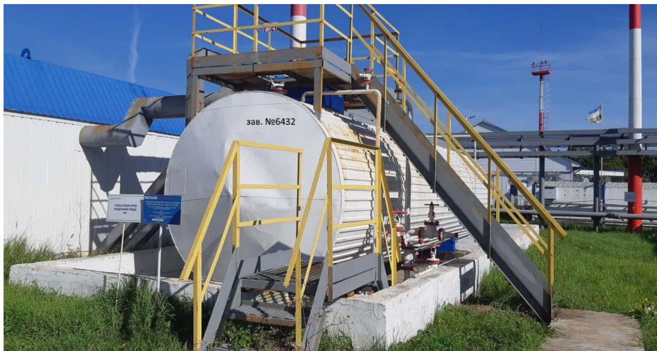
Рисунок 1 – Общий вид резервуара РГС-50
