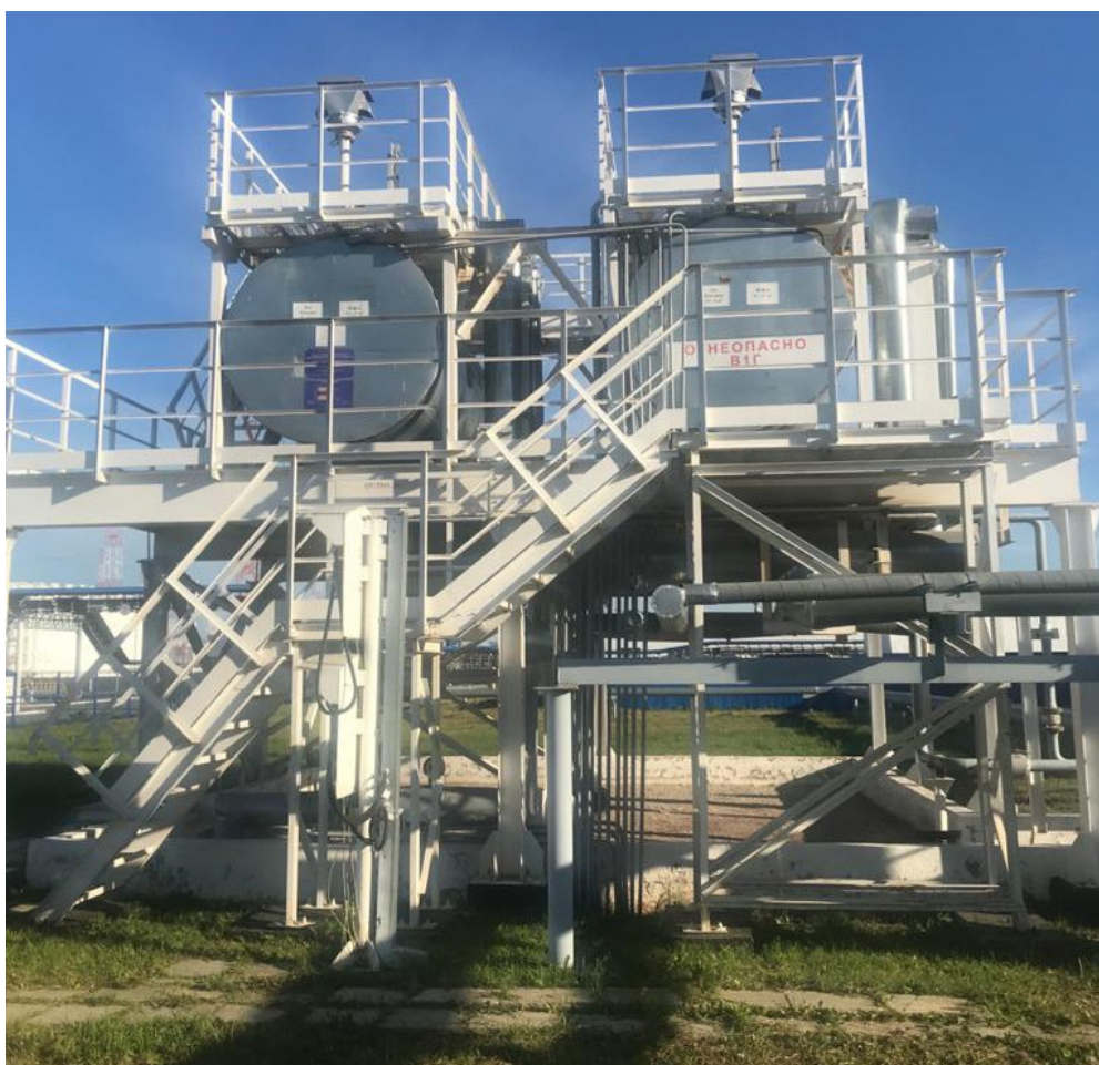
Рисунок 2 – Общий вид резервуаров РГС-20
