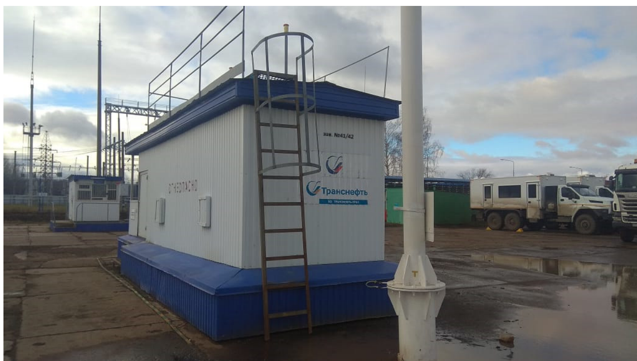
Рисунок 2 – Общий вид резервуара РГС-20
