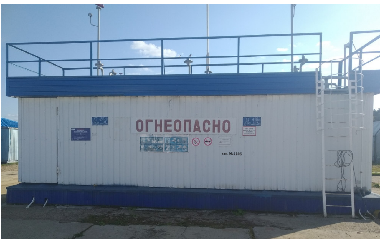
Рисунок 2 – Общий вид резервуара РГС-20 ЦТТиСТ, участок Улу-Теляк
