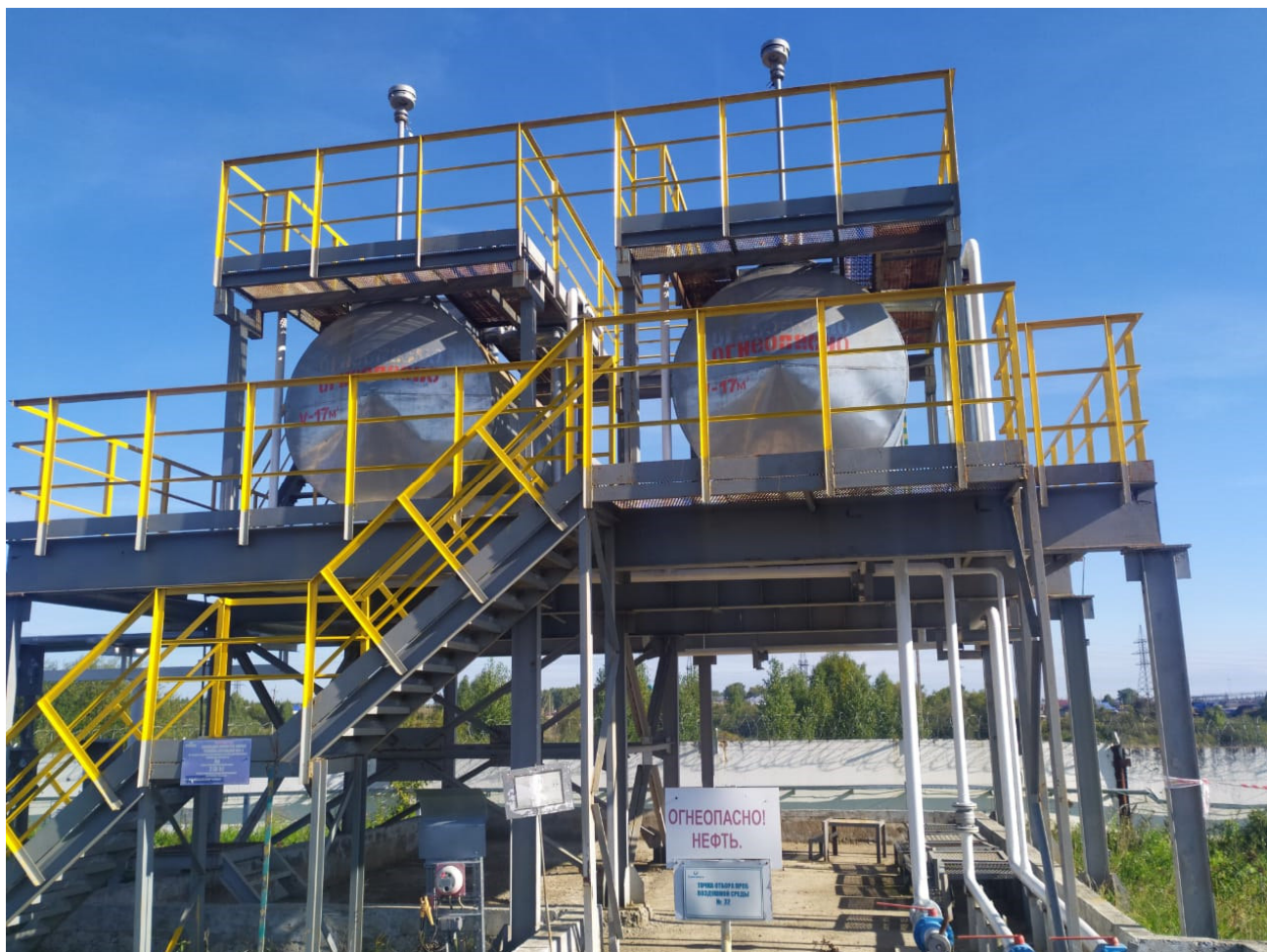
Рисунок 2 – Общий вид резервуаров РГС-20 ЛПДС «Кропачево»
