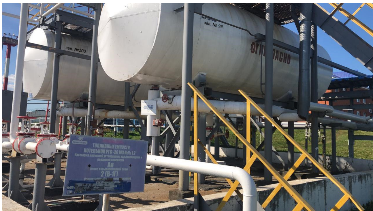
Рисунок 3 – Общий вид резервуаров РГС-20 ЛПДС «Черкассы»
