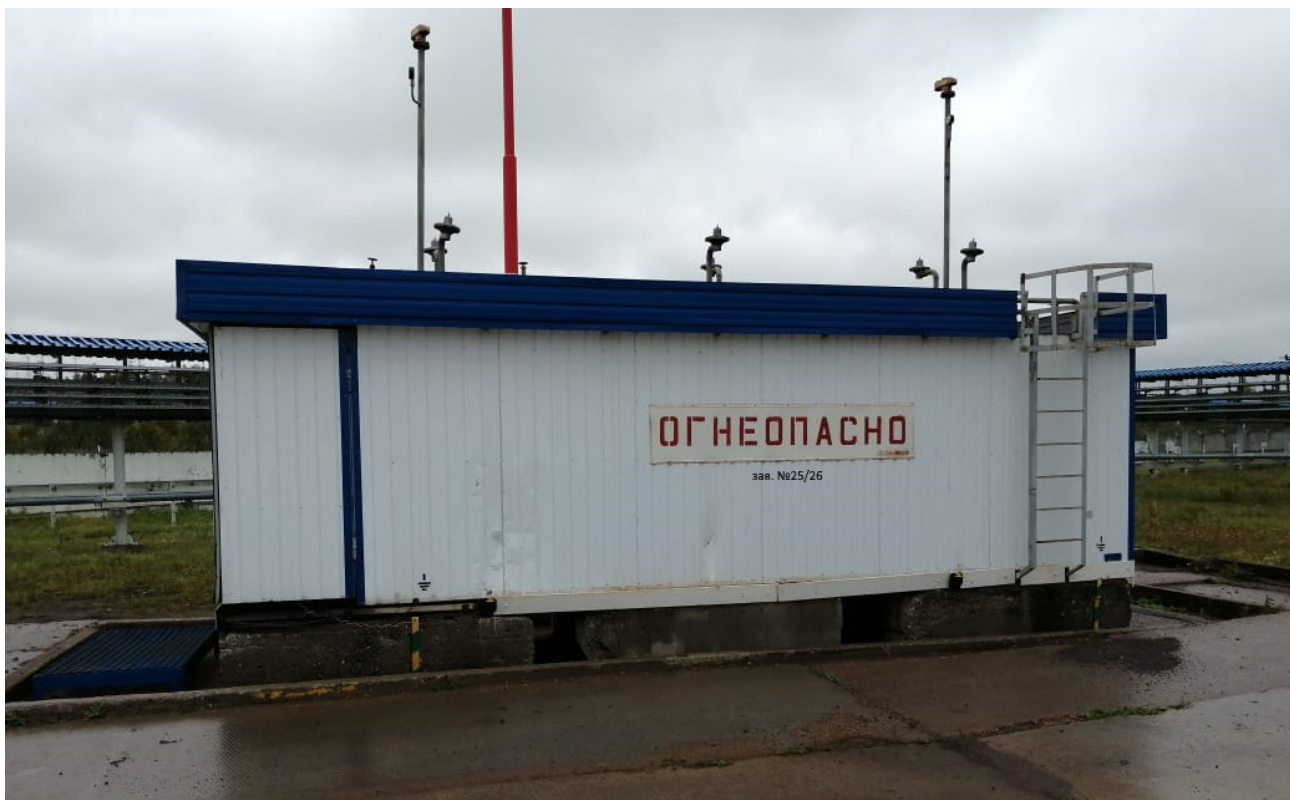
Рисунок 1 – Общий вид резервуара РГС-20 ЦТТиСТ, участок Кропачево
