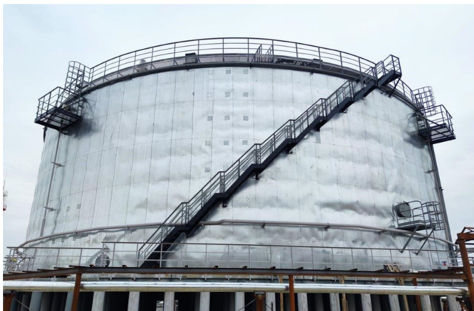
Рисунок 1 – Общий вид резервуаров
