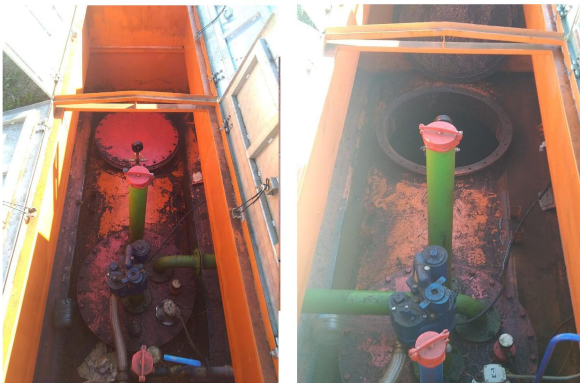
Рисунок 3 – Общий вид резервуаров Р-25
