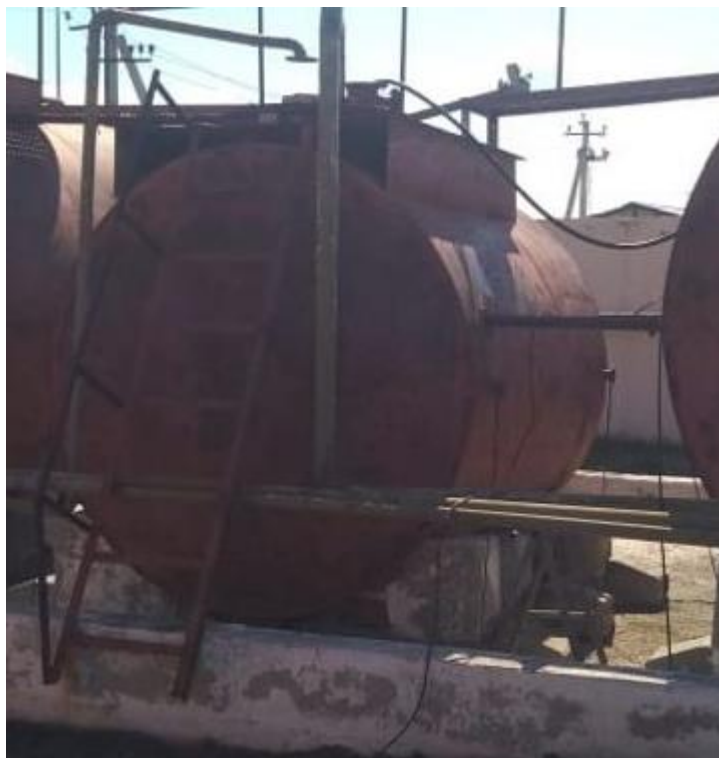
Рисунок 2 – Общий вид резервуара Р-10
