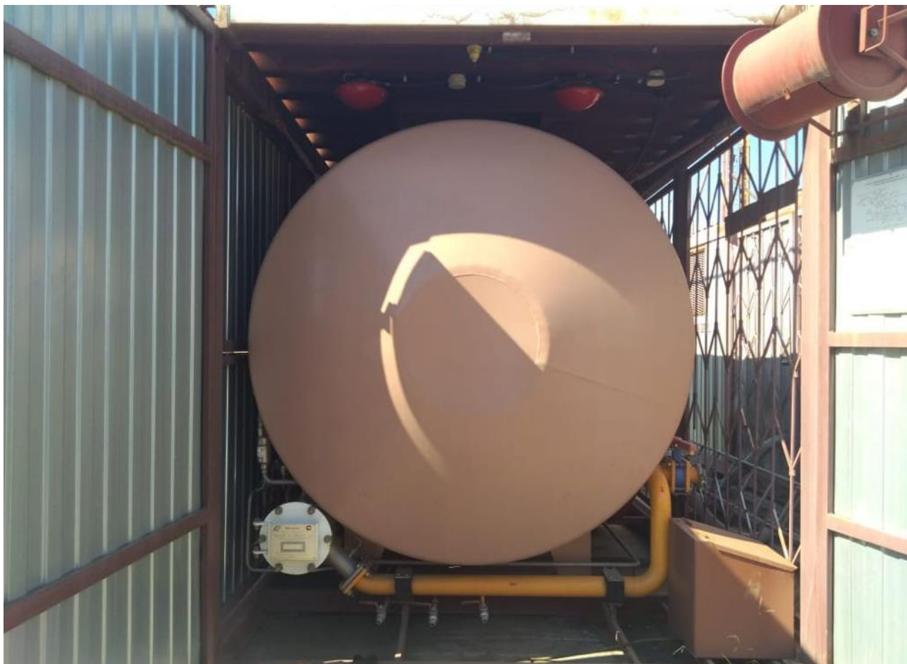
Рисунок 2 – Общий вид резервуара Рк-8
