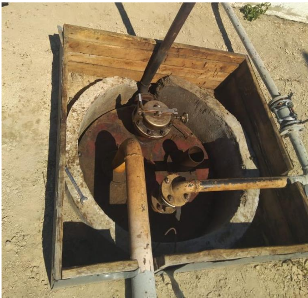
Рисунок 2 – Общий вид резервуара Р-10
