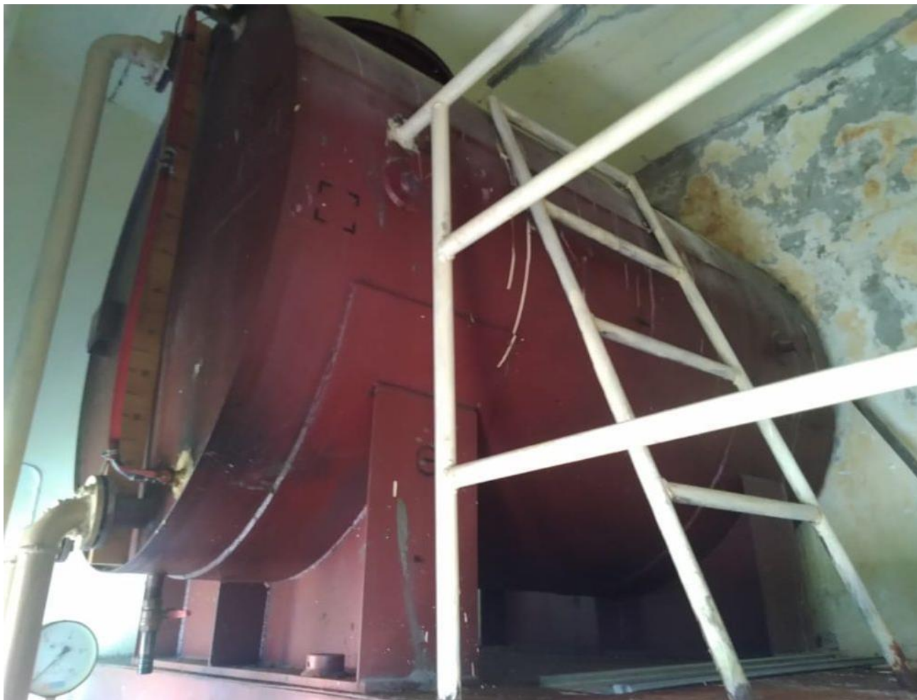
Рисунок 2 – Общий вид резервуара Р-3
