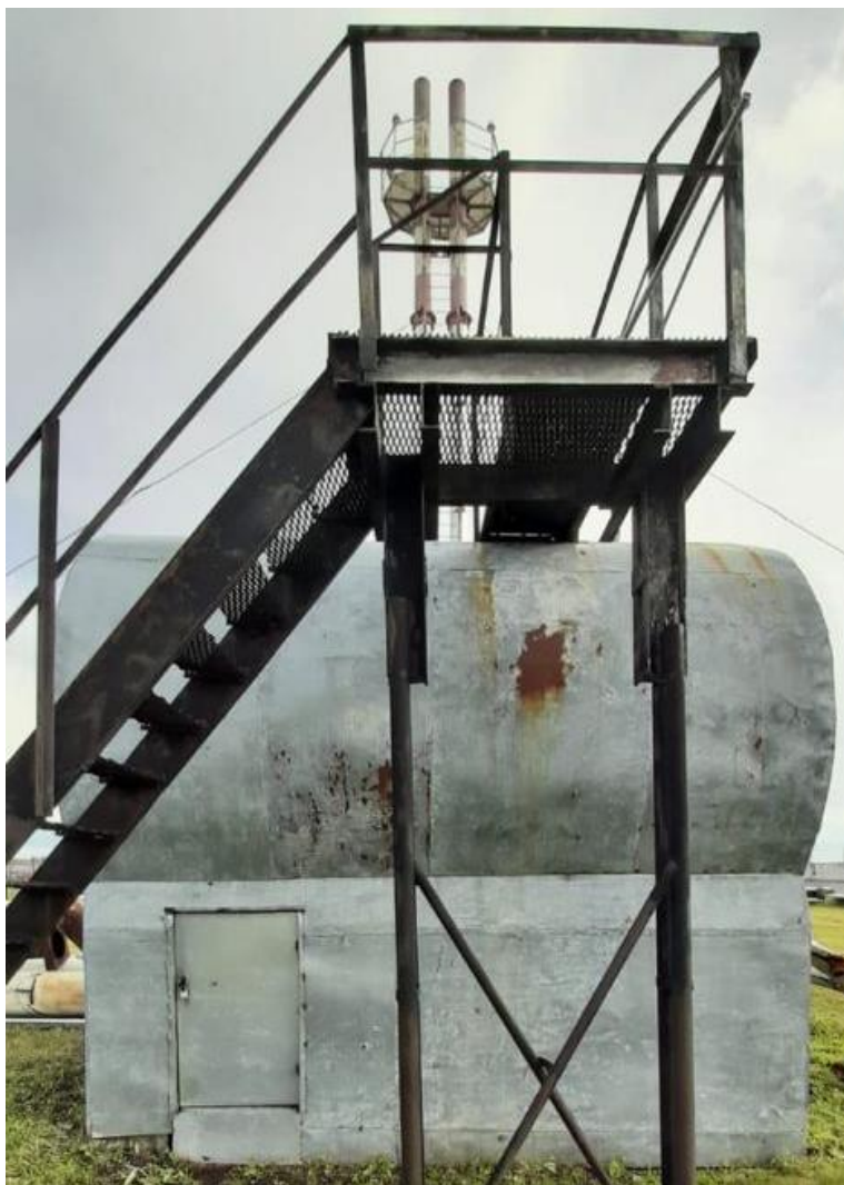
Рисунок 2 – Общий вид резервуара Р-25
