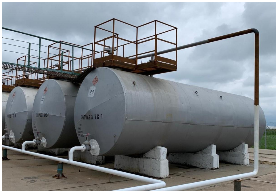
Рисунок 1 – Общий вид резервуаров РГС-50
