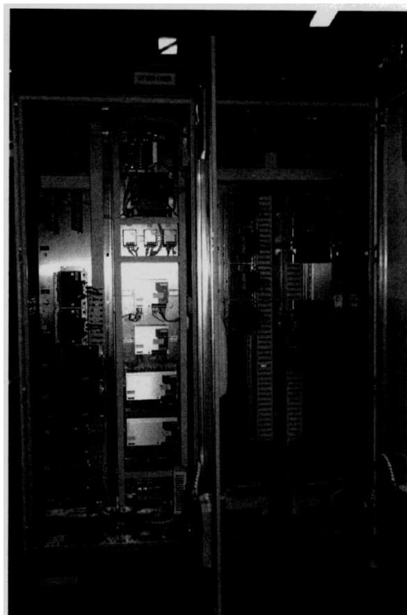
Рисунок 2 — Внешний вид приборного шкафа
