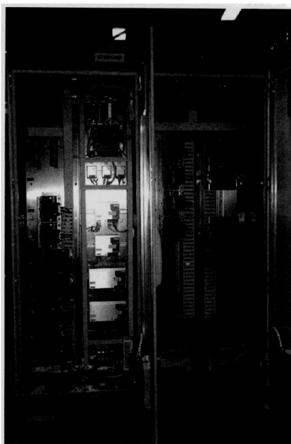
Рисунок 2 — Внешний вид приборного шкафа
