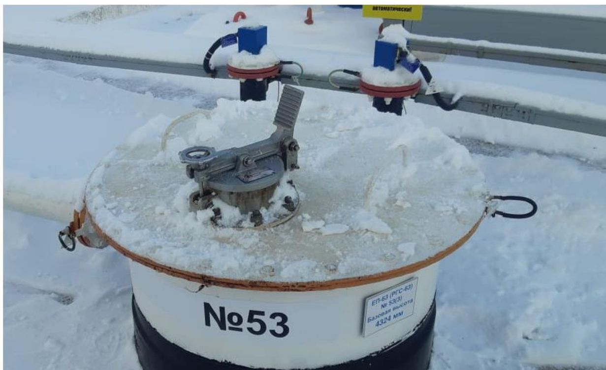
Рисунок 2 – Общий вид резервуара РГС-63 с заводским номером 53
