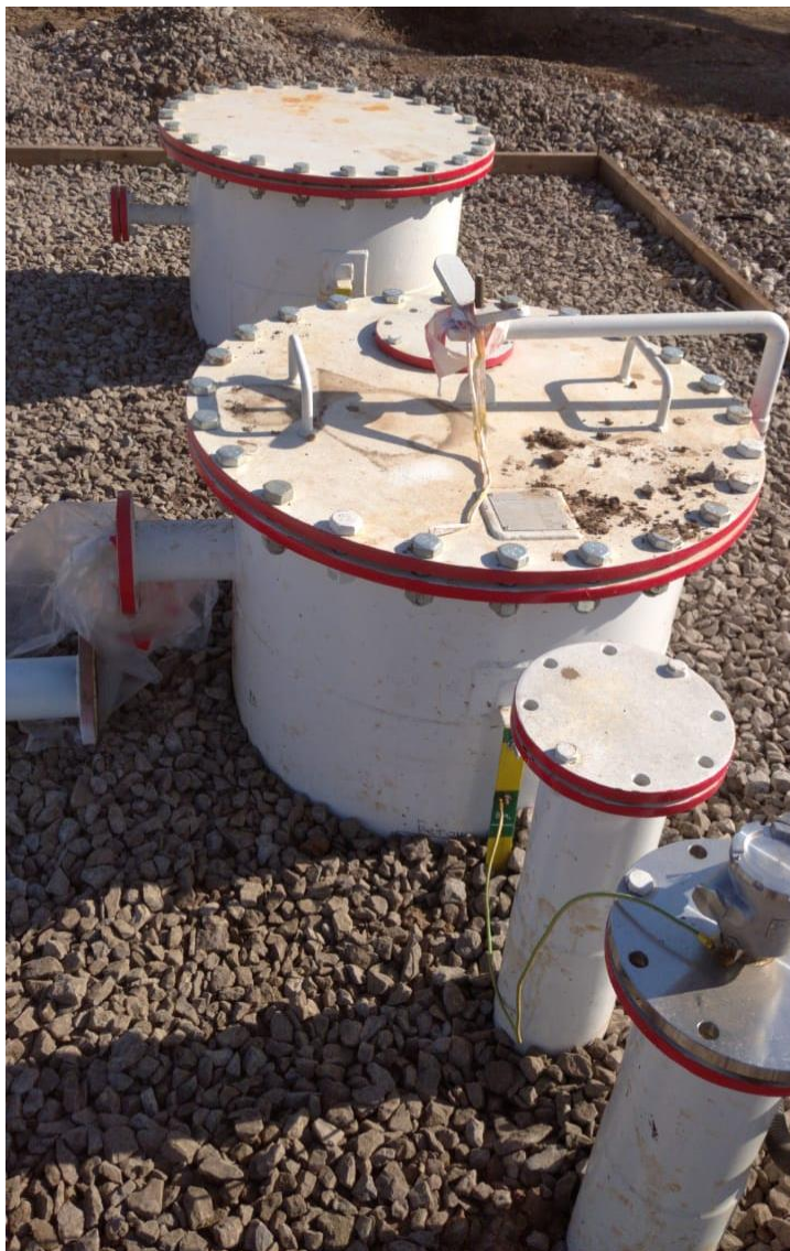
Рисунок 2 – Общий вид резервуара РГС-20
