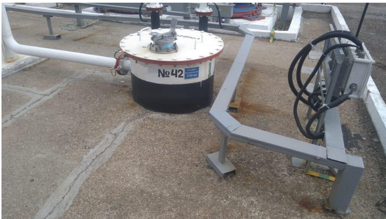
Рисунок 1 – Общий вид резервуара РГС-25
