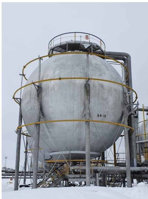
Рисунок 8 – Общий вид резервуаров РШС-600
