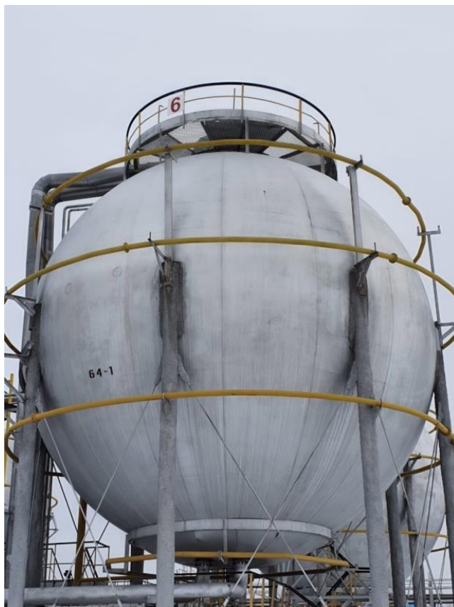
Рисунок 7 – Общий вид резервуаров РШС-600
