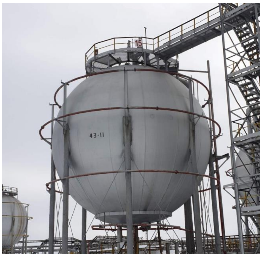
Рисунок 6— Общий вид резервуаров РШС-600
