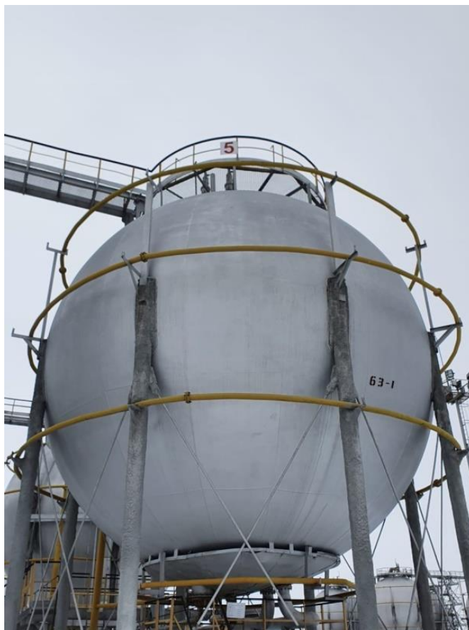
Рисунок 5 – Общий вид резервуаров РШС-600
