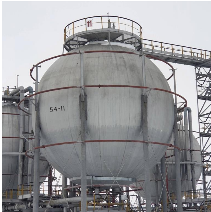
Рисунок 10– Общий вид резервуаров РШС-600
