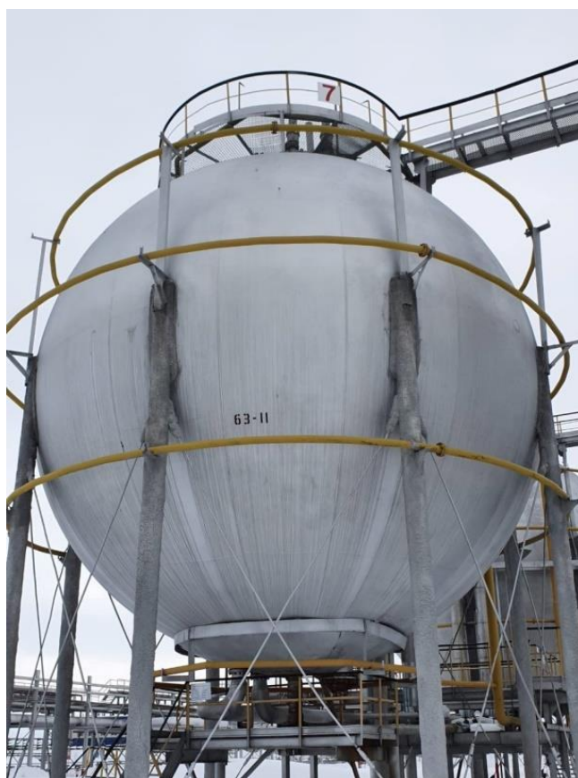
Рисунок 6 – Общий вид резервуаров РШС-600
