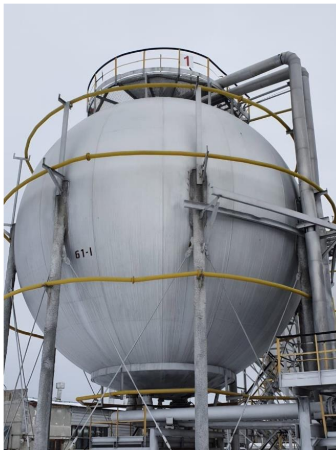
Рисунок 3 – Общий вид резервуаров РШС-600
