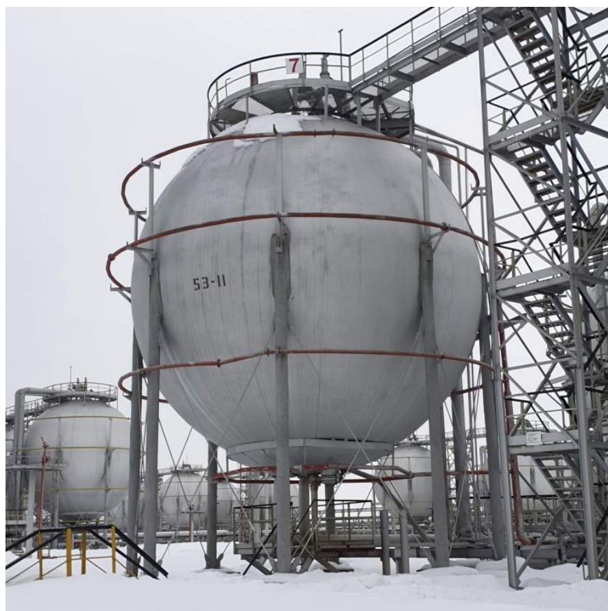
Рисунок 8– Общий вид резервуаров РШС-600
