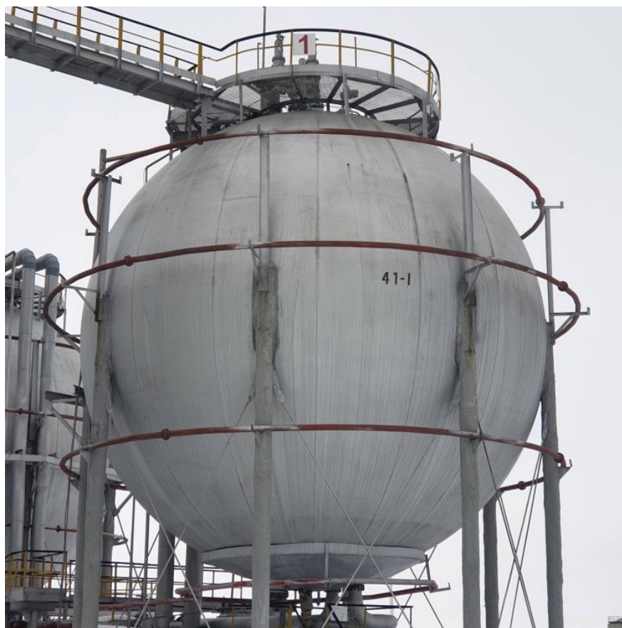
Рисунок 1 – Общий вид резервуаров РШС-600
