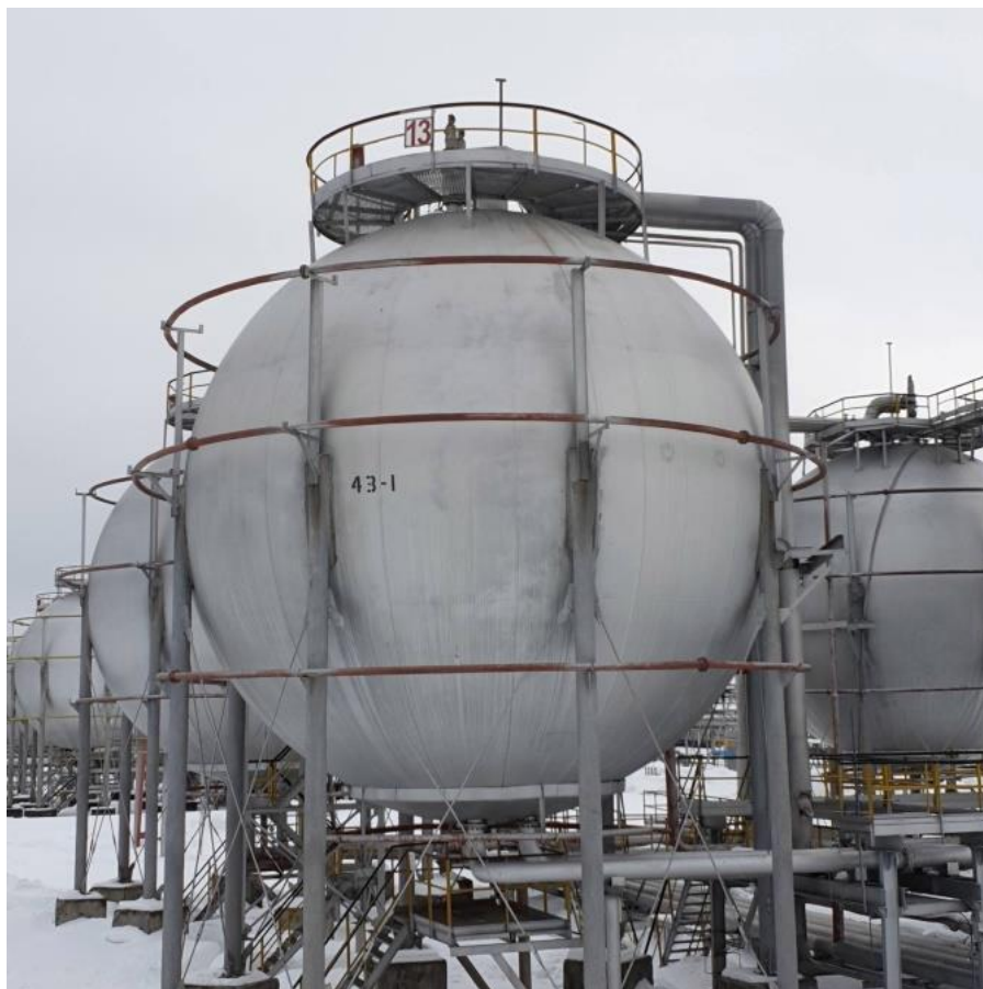
Рисунок 5— Общий вид резервуаров РШС-600
