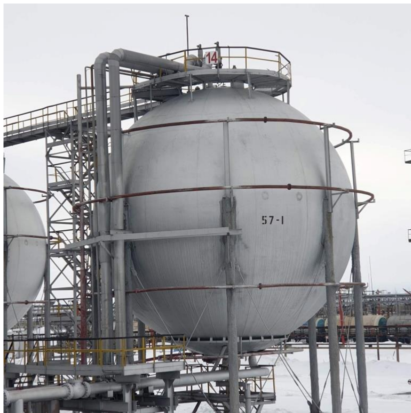
Рисунок 13– Общий вид резервуаров РШС-600
