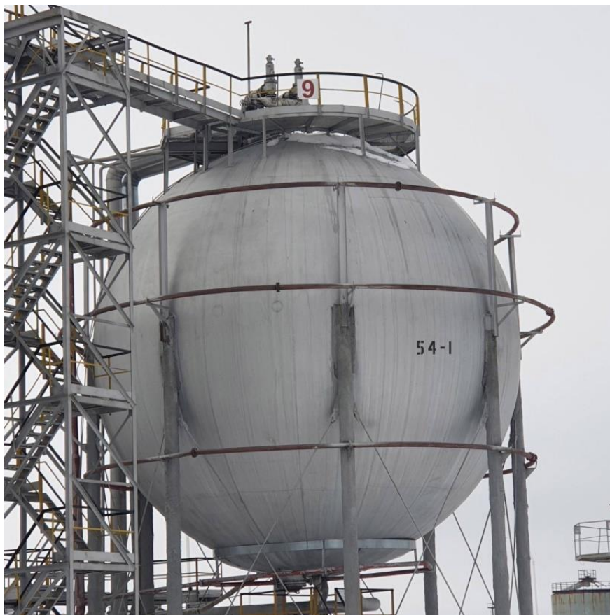
Рисунок 9– Общий вид резервуаров РШС-600
