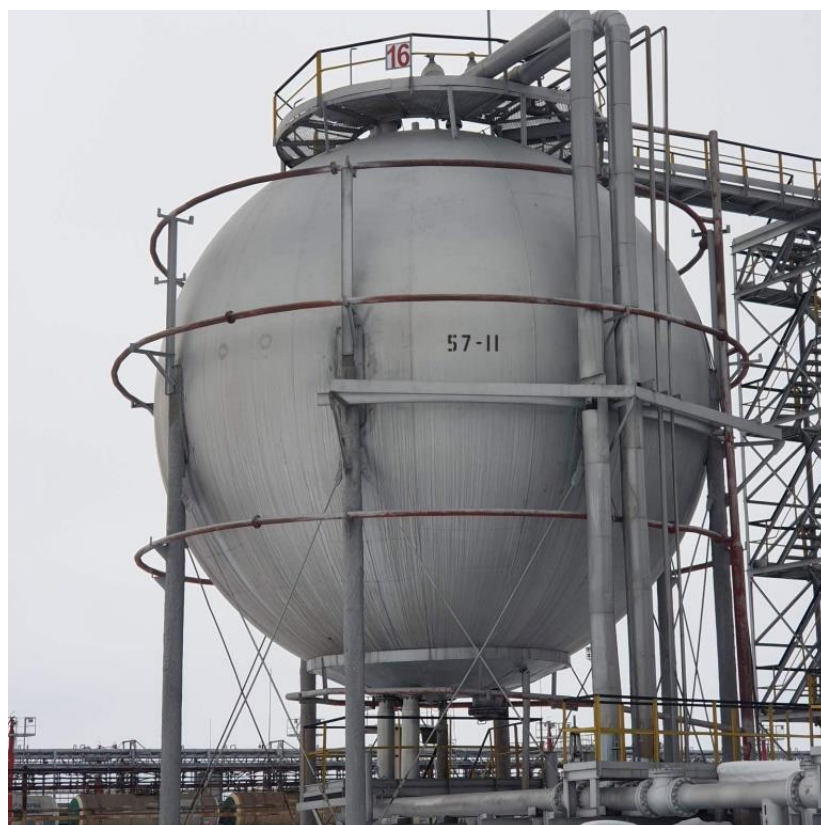
Рисунок 14– Общий вид резервуаров РШС-600
