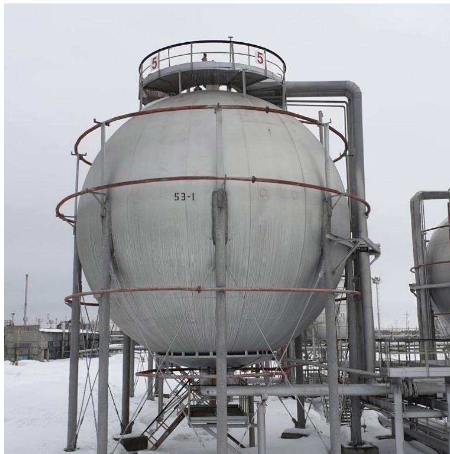
Рисунок 7– Общий вид резервуаров РШС-600
