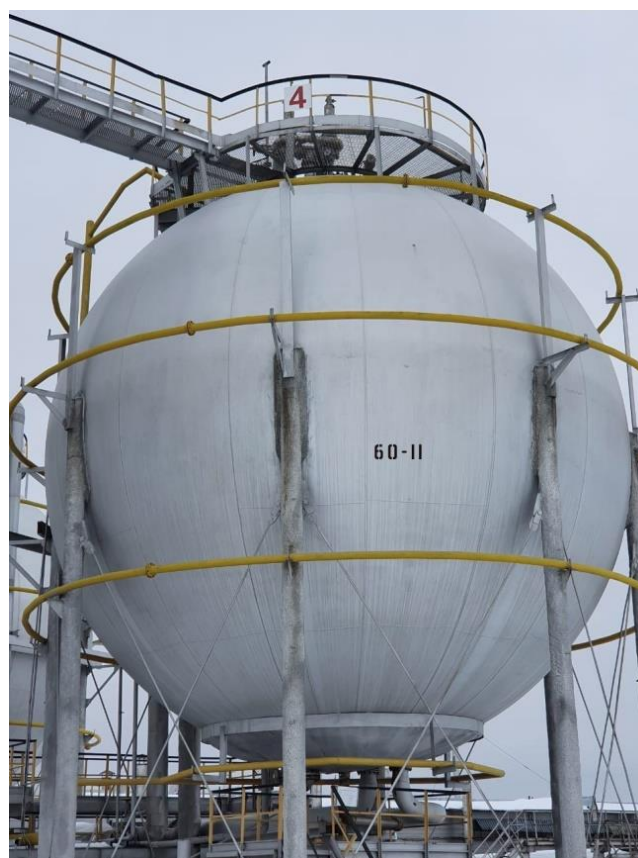
Рисунок 2 – Общий вид резервуаров РШС-600
