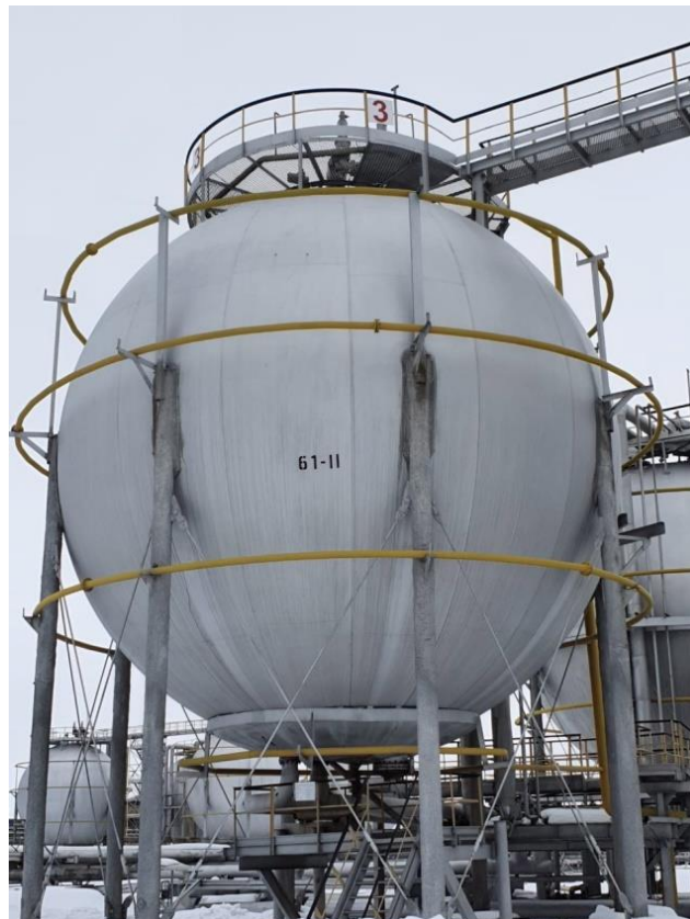
Рисунок 4 – Общий вид резервуаров РШС-600
