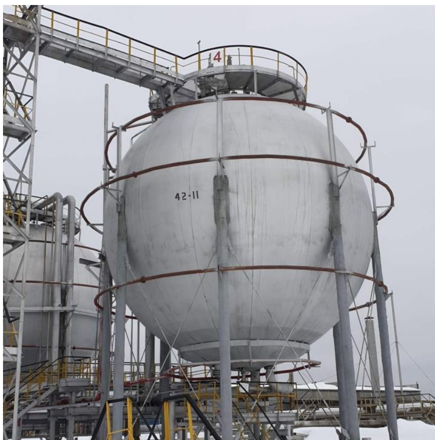
Рисунок 4— Общий вид резервуаров РШС-600
