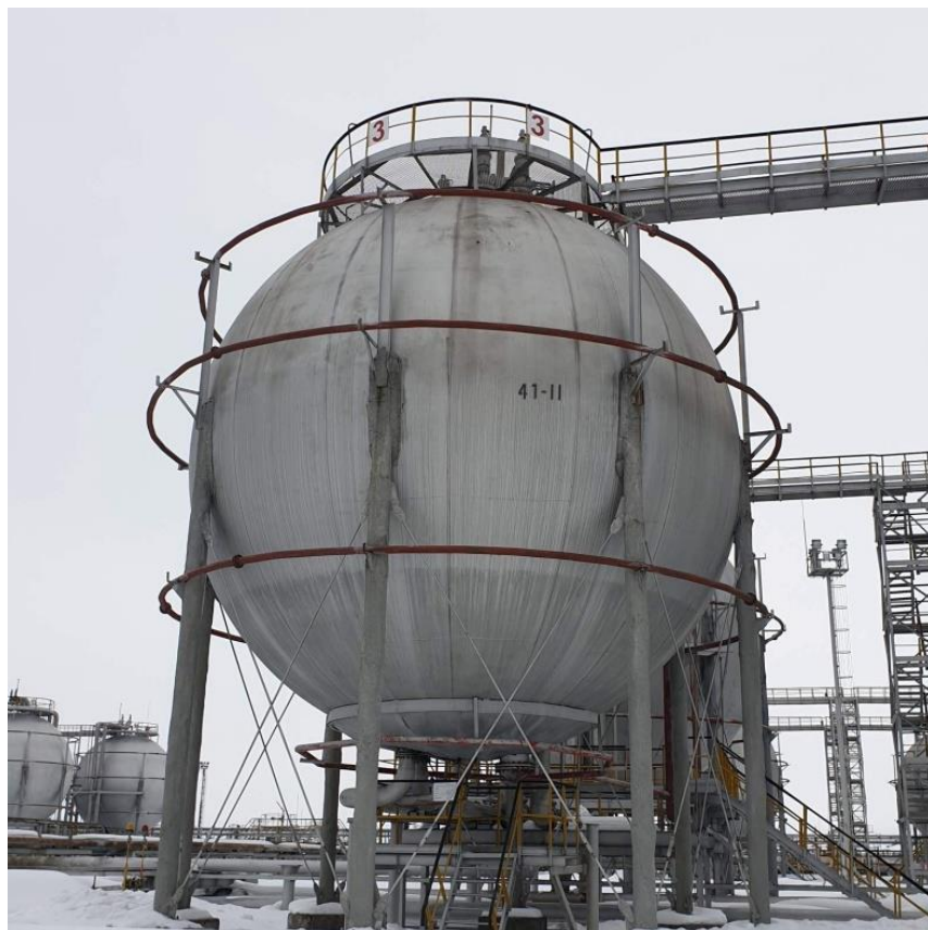
Рисунок 2 – Общий вид резервуаров РШС-600
