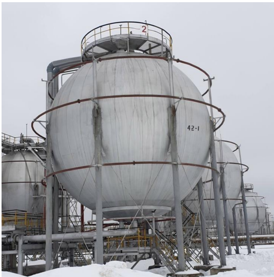
Рисунок 3— Общий вид резервуаров РШС-600
