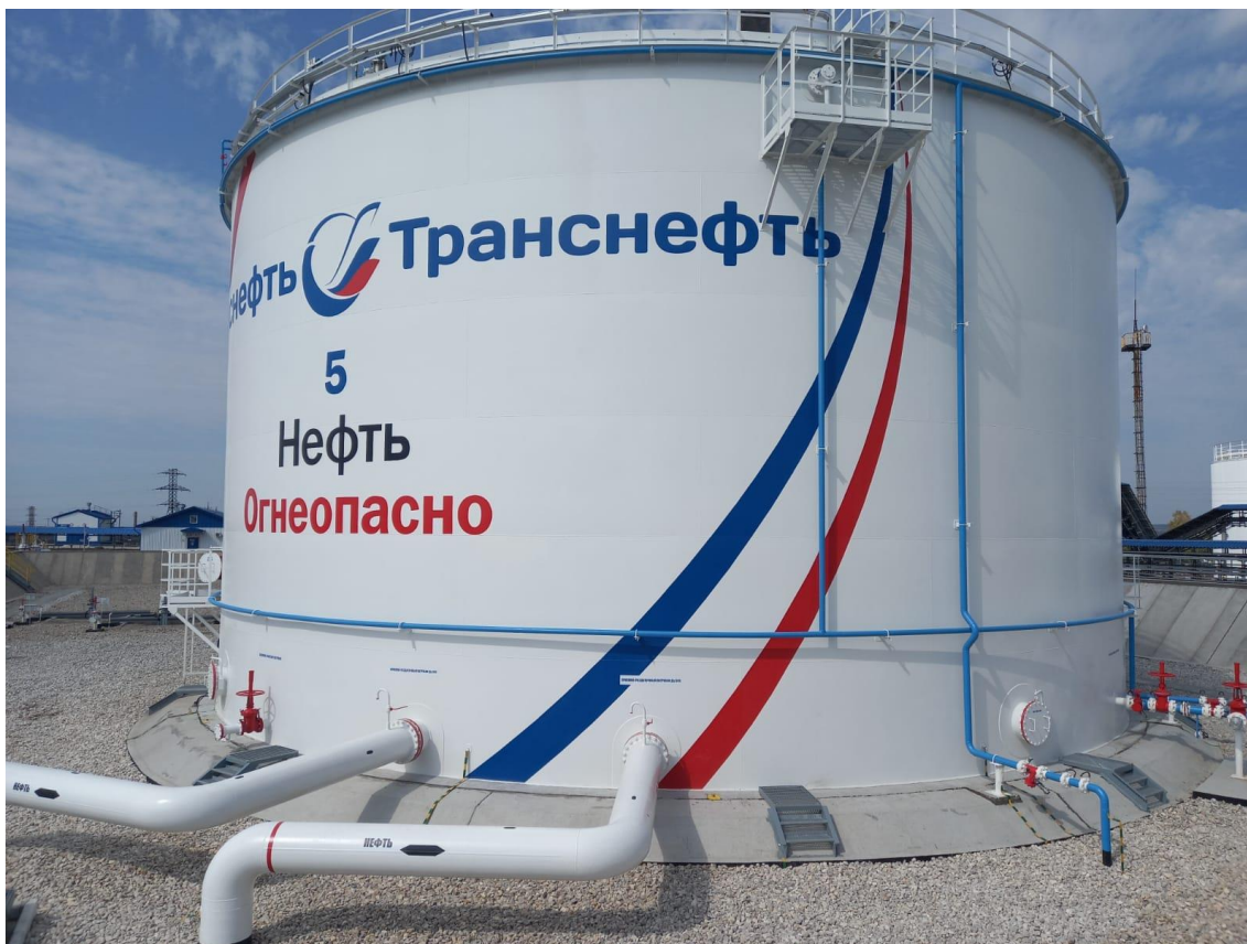
Рисунок 1 – Общий вид резервуара РВСП-5000
