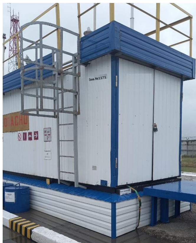
Рисунок 2 – Общий вид резервуара РГС-20 с заводским номером 1171
