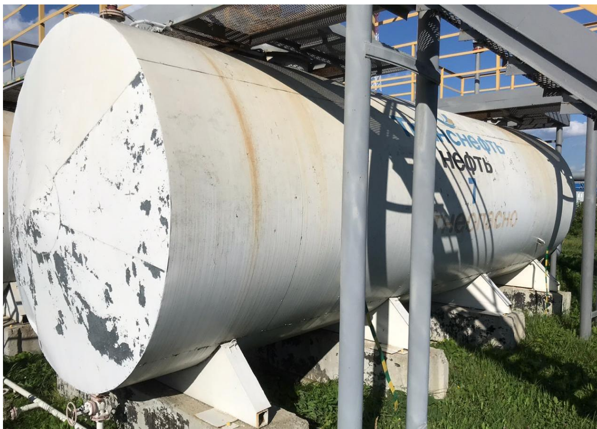
Рисунок 2 – Общий вид резервуара РГС-60 с заводским номером 23
