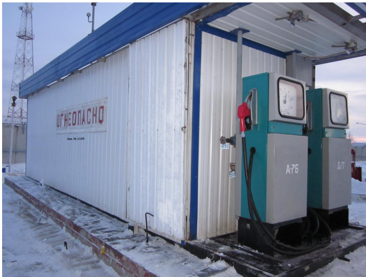
Рисунок 1 – Общий вид резервуара РГС-20 с заводским номером 1169
