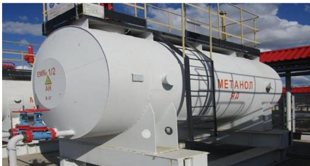
Рисунок 1 – Общий вид резервуаров горизонтальных стальных цилиндрических РГС-16
