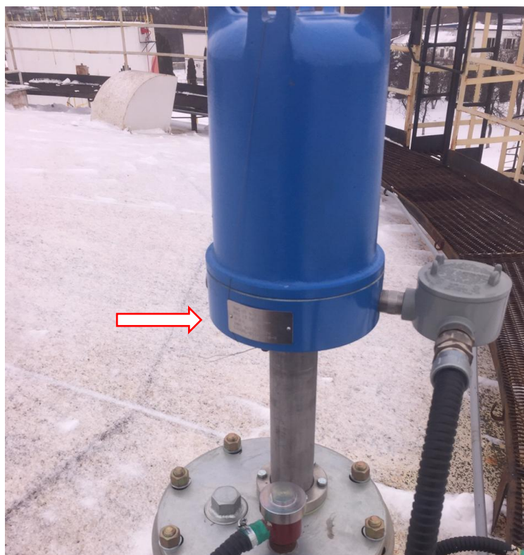
Рисунок 1 – Общий вид микропроцессорного трансмиттера с трубной конструкцией и место нанесения заводского номера
