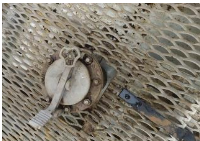
Рисунок 3 – замерной люк РВС-2000
