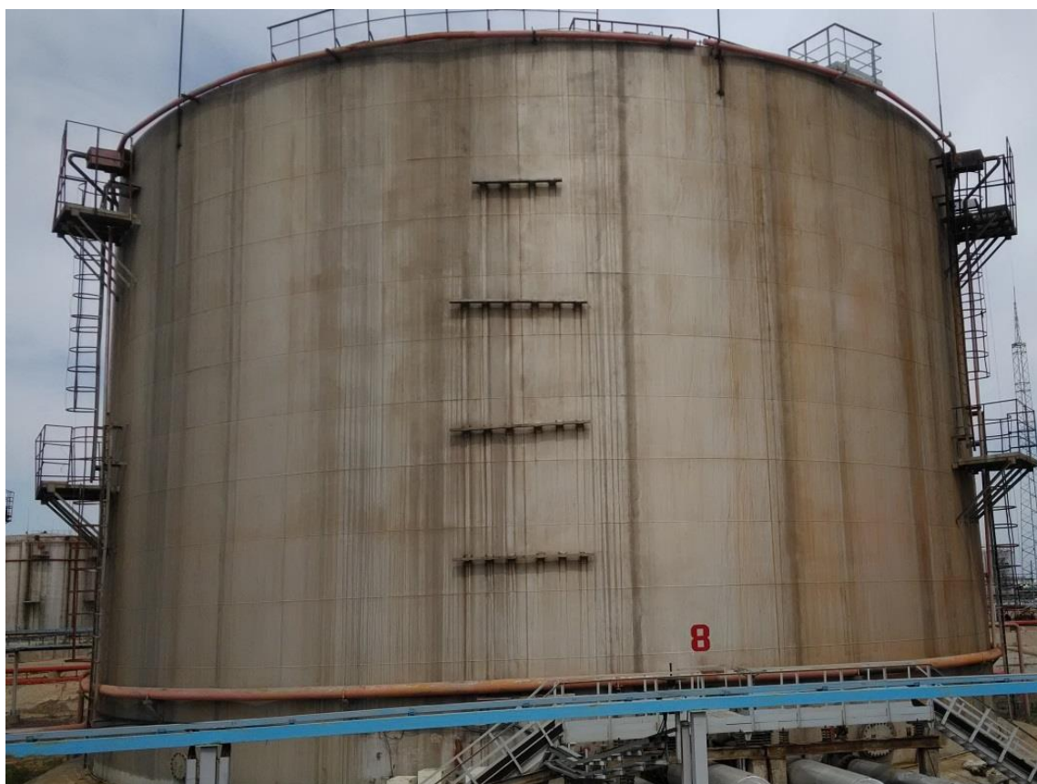
Рисунок 8 – Общий вид резервуара РВСП-10000 зав.№ 8
