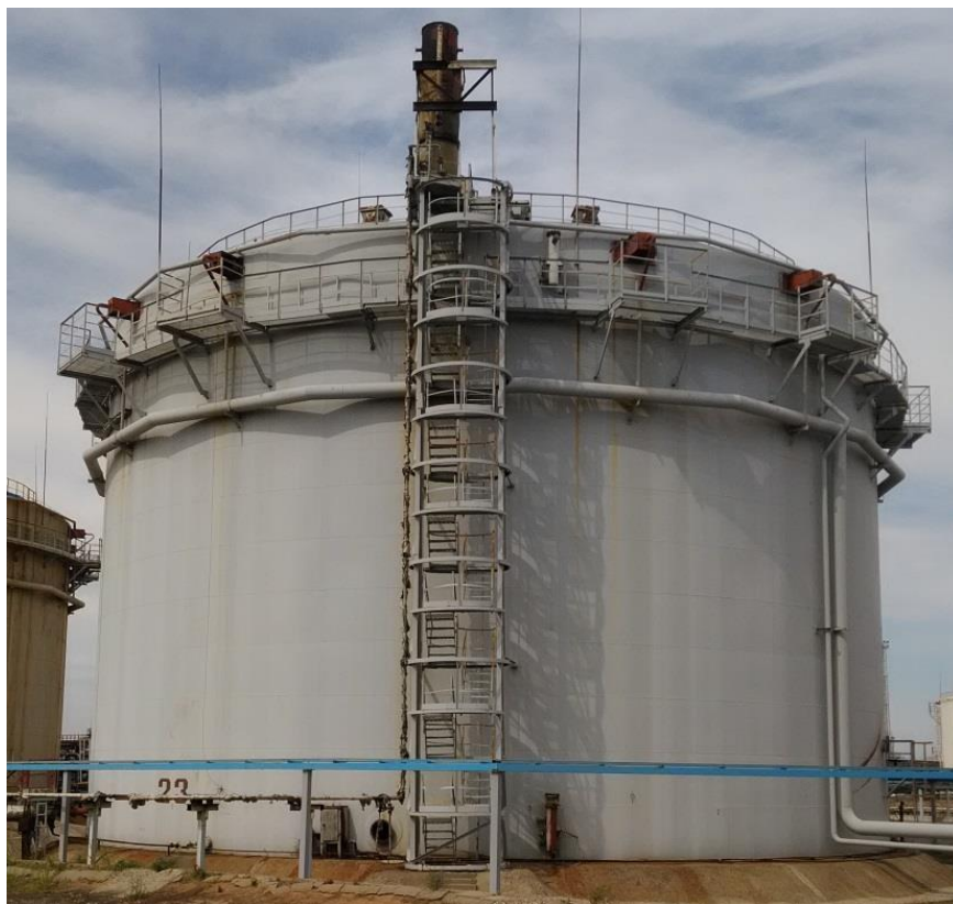
Рисунок 11 – Общий вид резервуара РВСП-10000 зав.№ 23
