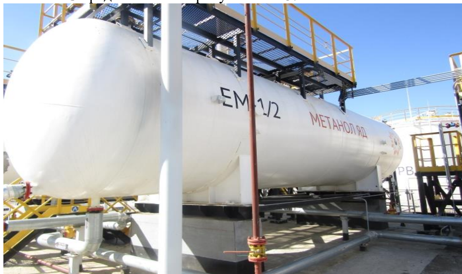
Рисунок 1 – Общий вид резервуаров горизонтальных стальных цилиндрических РГС-75
