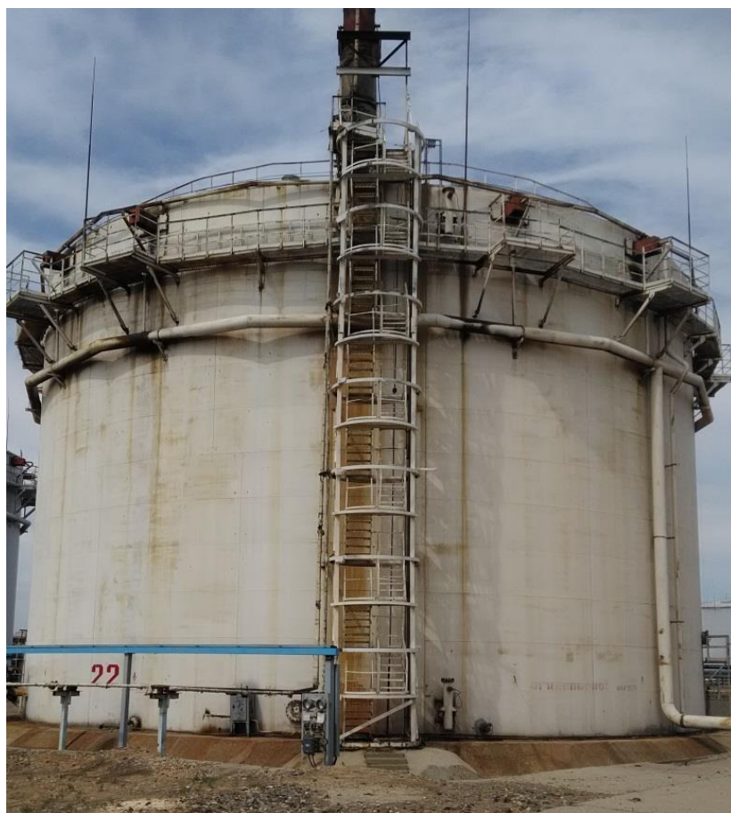
Рисунок 10 – Общий вид резервуара РВСП-10000 зав.№ 22
