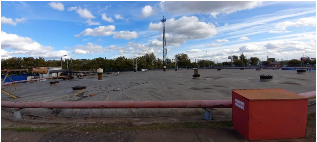
Рисунок 1 – Общий вид резервуара ЖБР-11500
