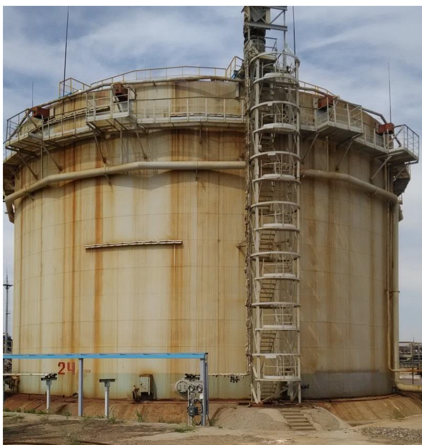
Рисунок 12 – Общий вид резервуара РВСП-10000 зав.№ 24
