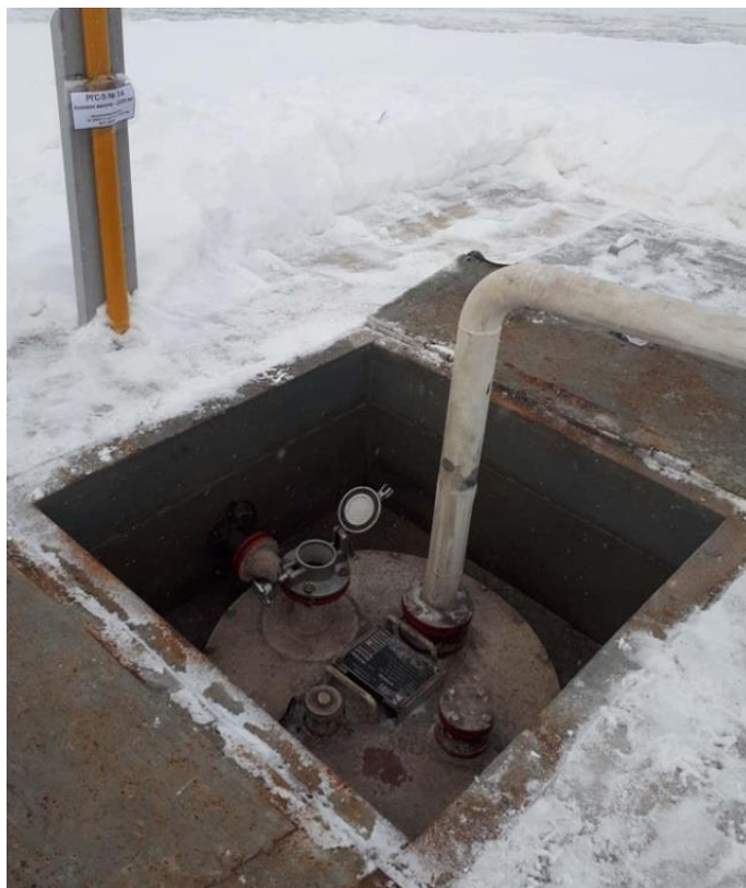
Рисунок 1 – Общий вид резервуара РГС-5
