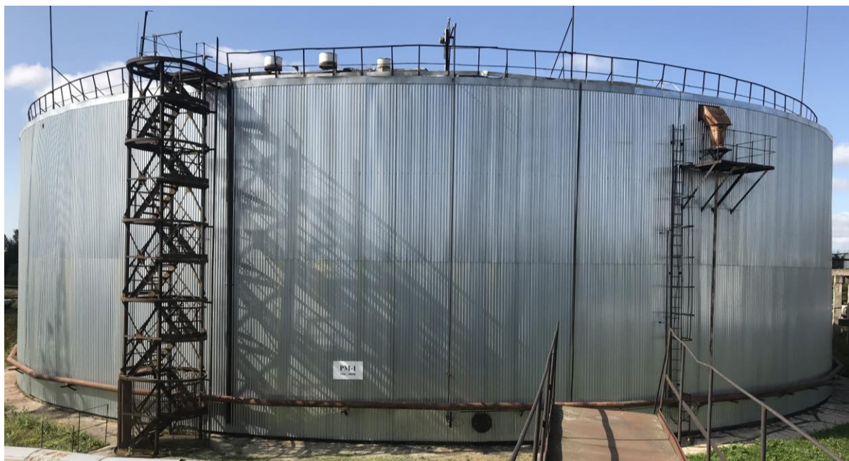
Рисунок 1 – Общий вида резервуара РВС-20000
