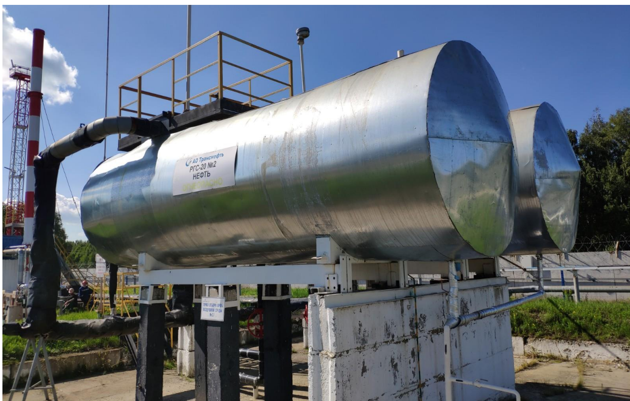
Рисунок 2 – Общий вид резервуара РГС-20 зав.№2
