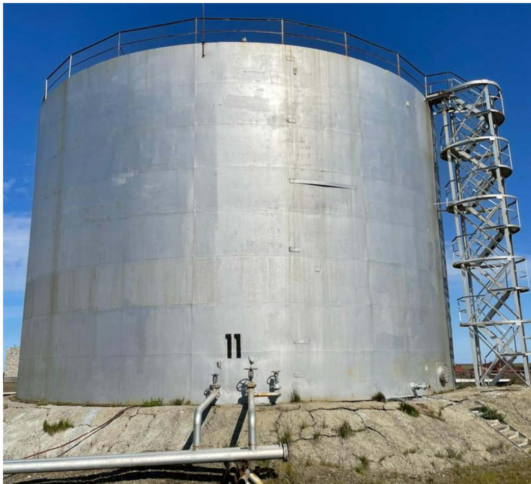
Рисунок 1 – Общий вид резервуара РВС-3000 с заводским номером 11
