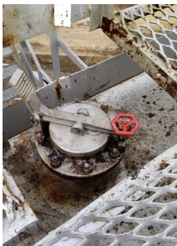
Рисунок 4 – Горловина и замерной люк резервуара стального горизонтального цилиндрического РВС-5000, заводской № 29
