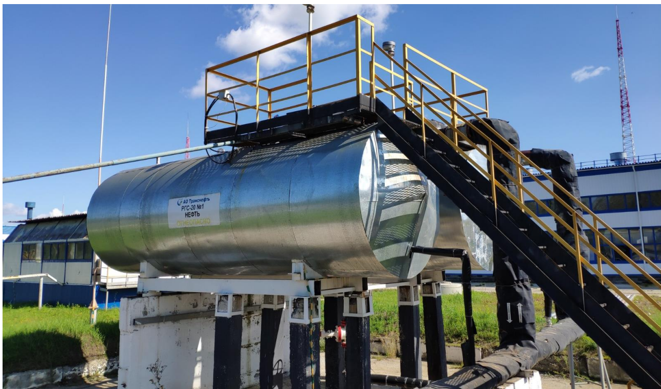
Рисунок 1 – Общий вид резервуара РГС-20 зав.№1
