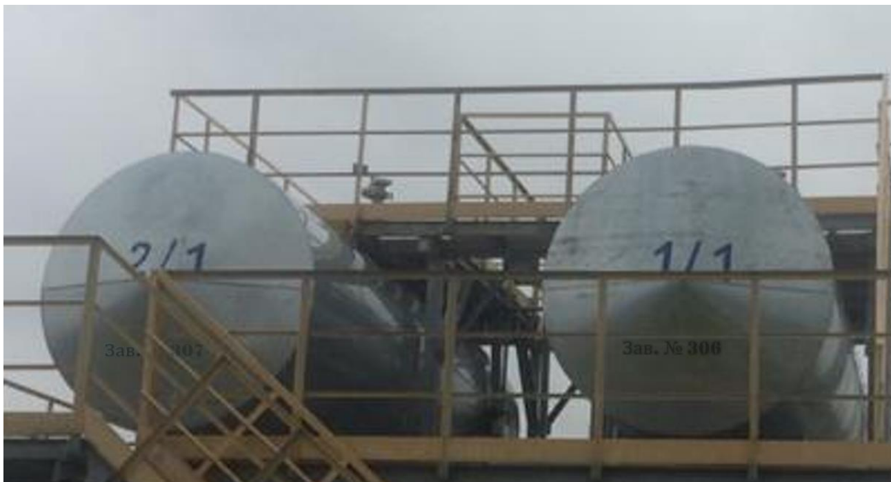
Рисунок 1 – Общий вид резервуаров РГС-20 №№306, 307
