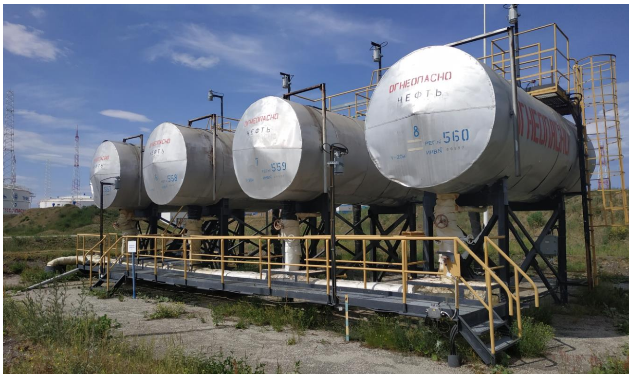
Рисунок 3 – Общий вид резервуаров РГС-20 зав.№№5, 6, 7, 8
