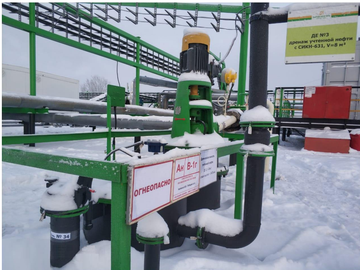
Рисунок 1 – Общий вид резервуара ЕП-8
