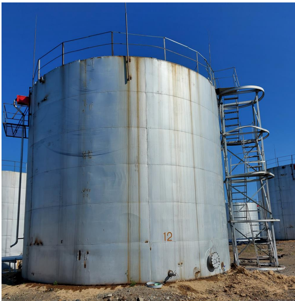
Рисунок 1 – Общий вид резервуара РВС-700 с заводским номером 12
