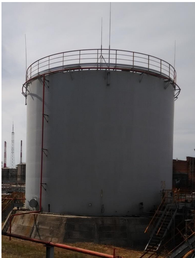
Рисунок 1 – Общий вид резервуара РВСП-2000 зав.№ 25
