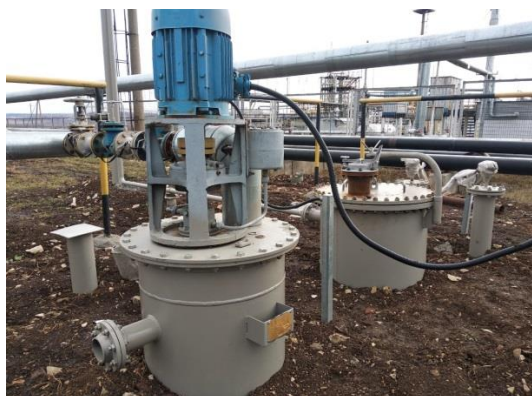
Рисунок 2 – Горловины и замерный люк резервуара стального горизонтального цилиндрического РГС-12,5
