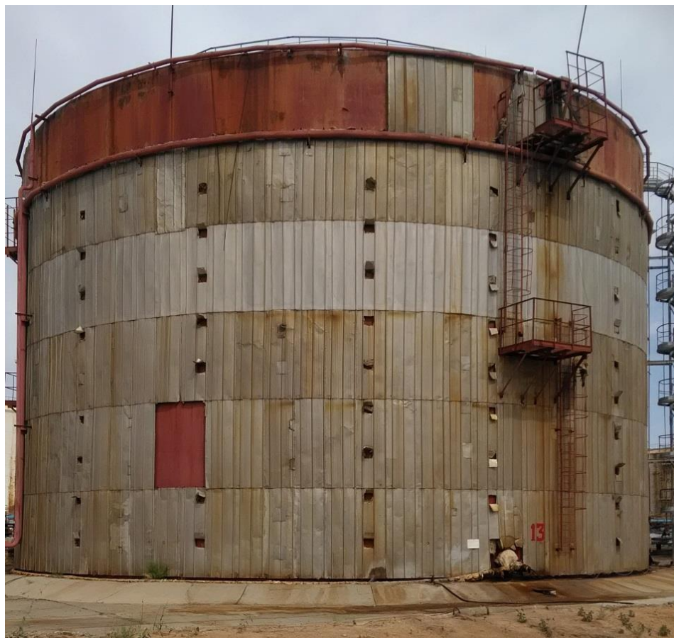
Рисунок 5 – Общий вид резервуара РВС-10000 зав.№ 13
