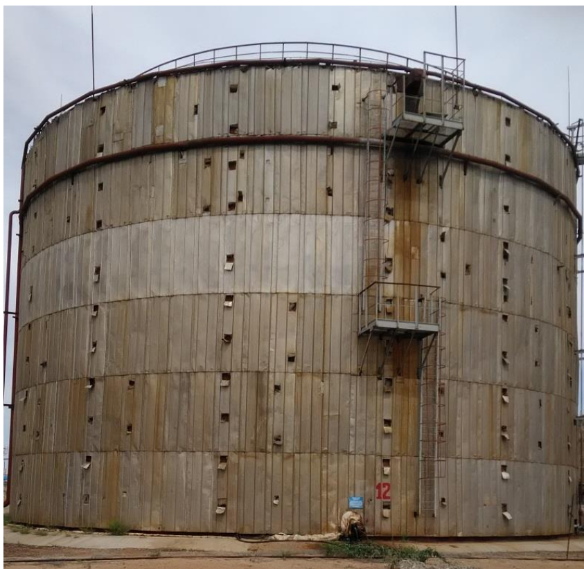
Рисунок 4 – Общий вид резервуара РВС-10000 зав.№ 12
