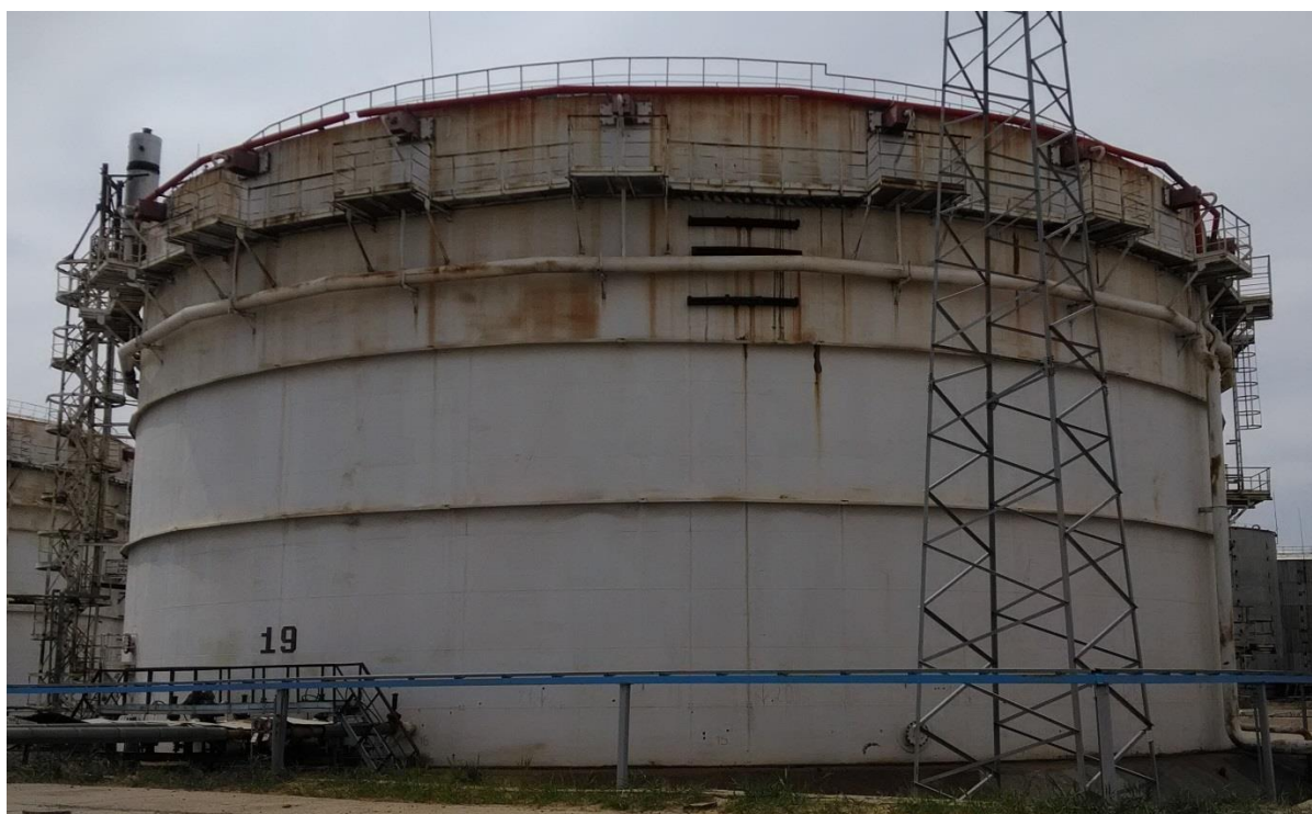
Рисунок 3 – Общий вид резервуара РВСП-20000 зав.№ 19
