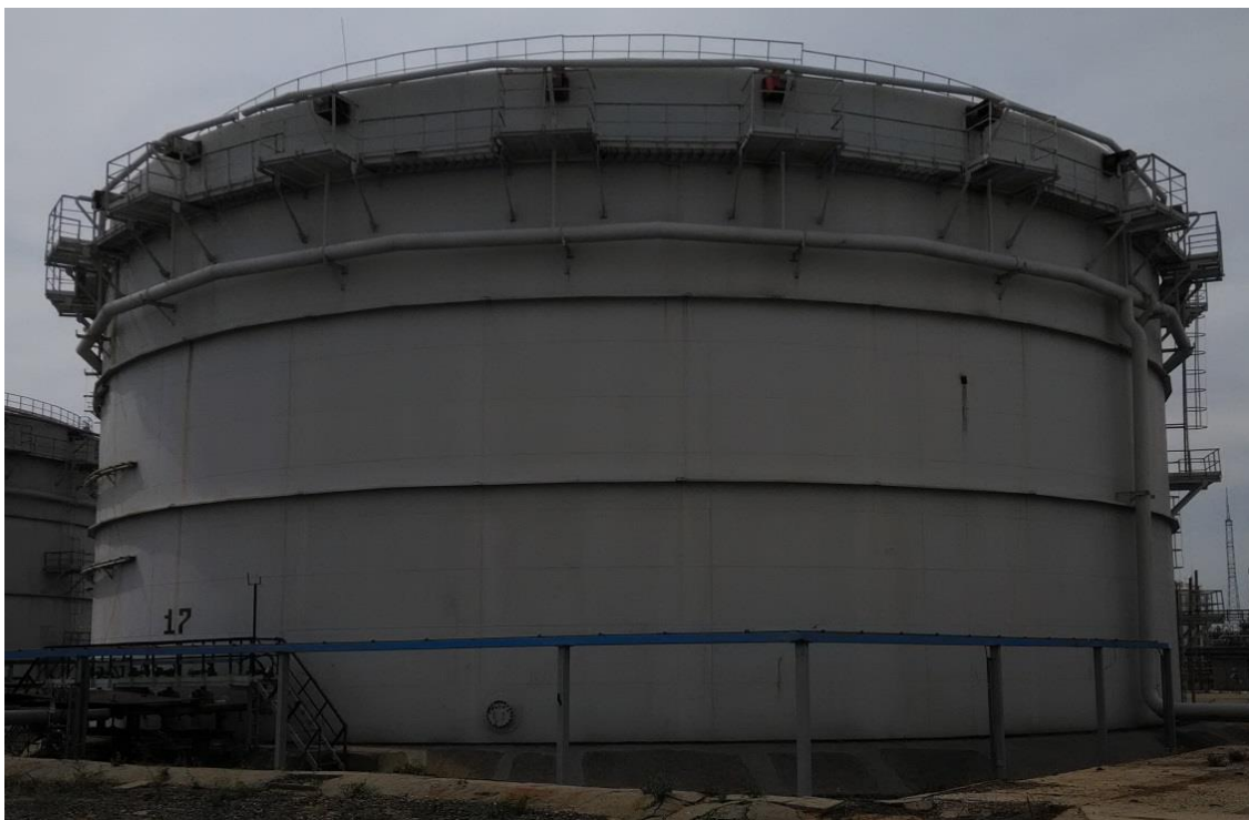
Рисунок 1 – Общий вид резервуара РВСП-20000 зав.№ 17
