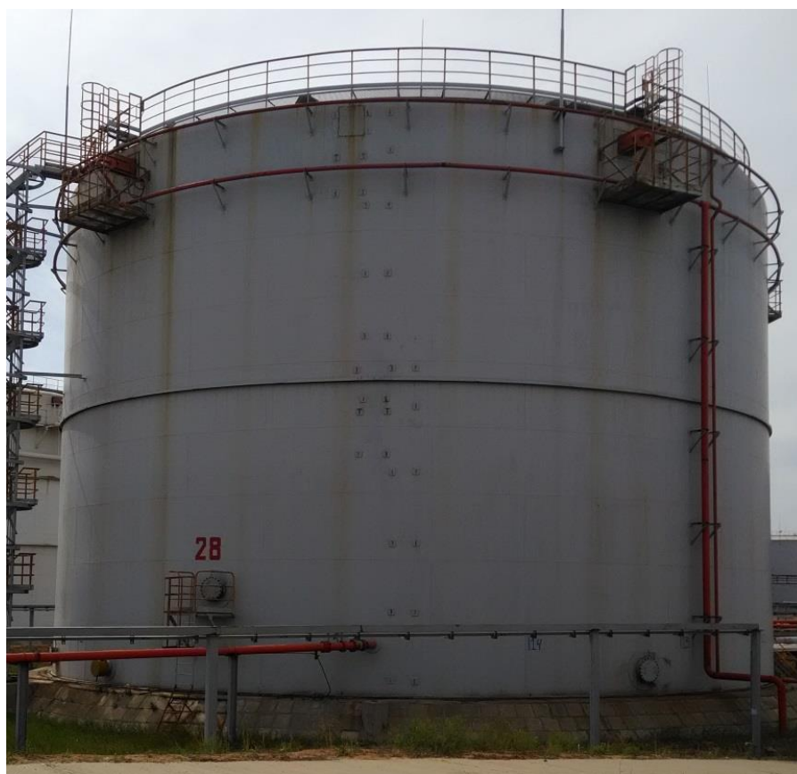
Рисунок 2 – Общий вид резервуара РВСП-10000 зав.№ 28
