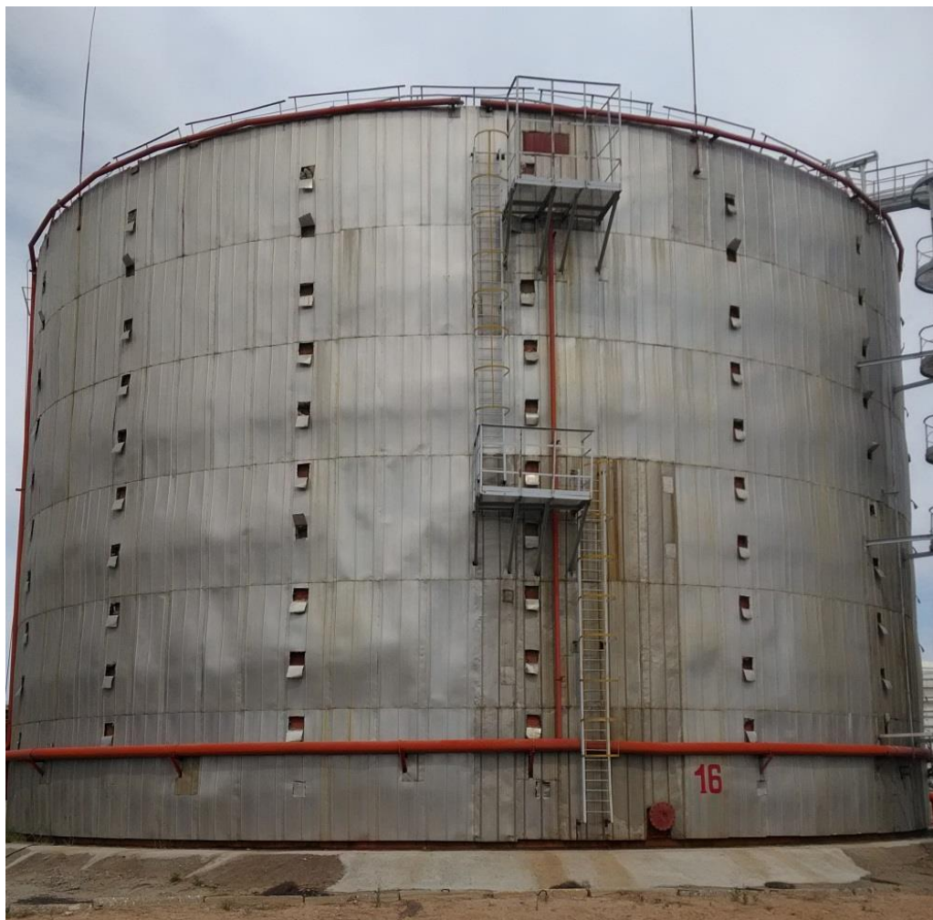
Рисунок 7 – Общий вид резервуара РВС-10000 зав.№ 16
