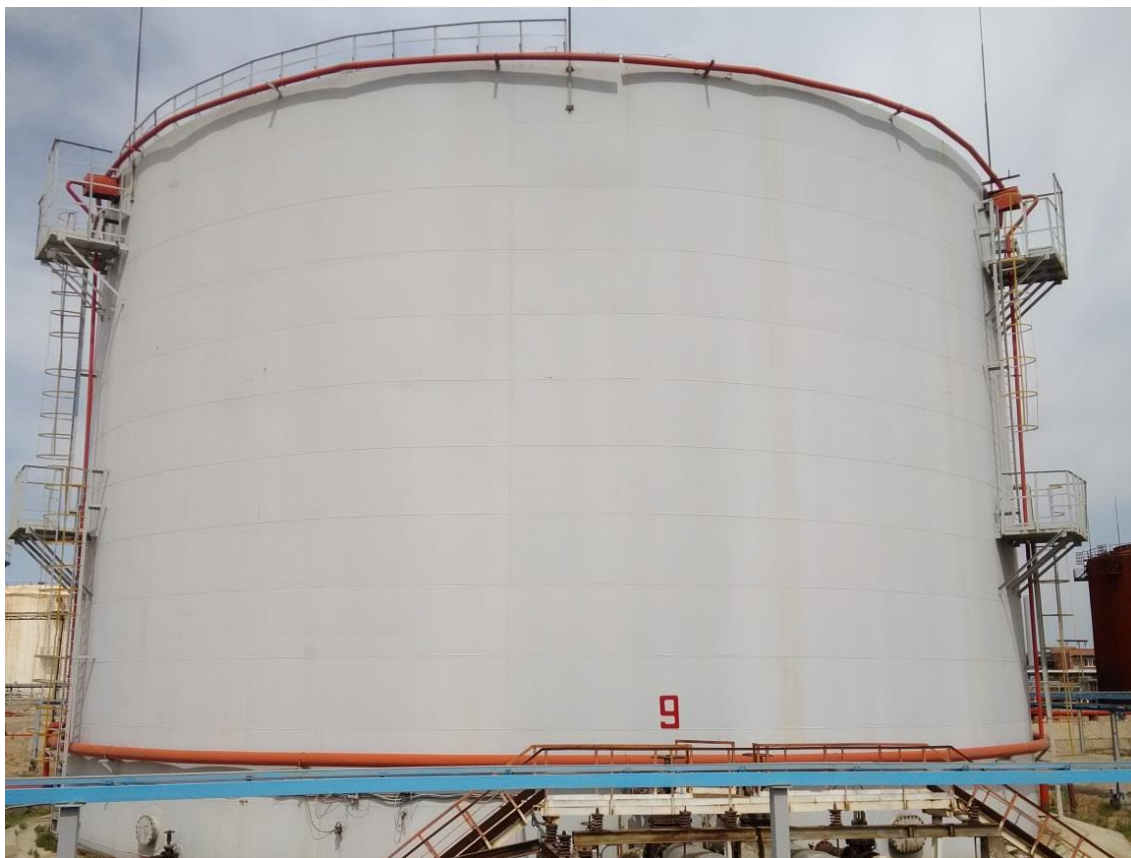
Рисунок 1 – Общий вид резервуара РВС-10000 зав.№ 9
