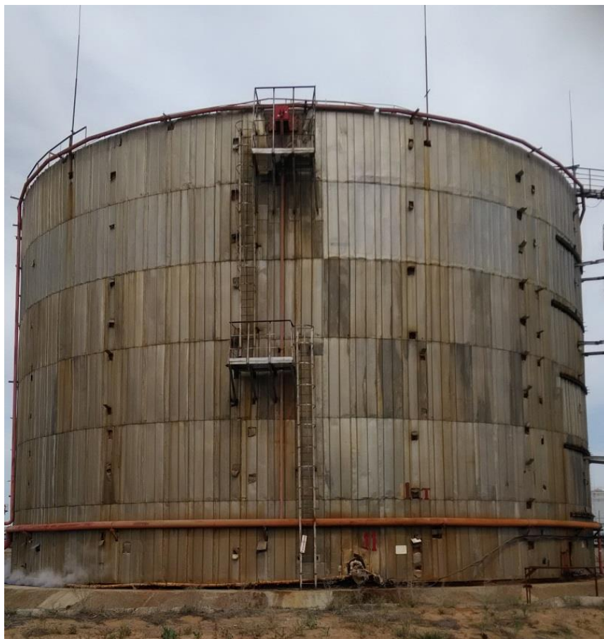
Рисунок 3 – Общий вид резервуара РВС-10000 зав.№ 11
