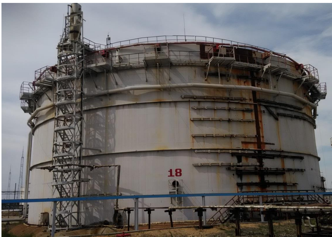
Рисунок 2 – Общий вид резервуара РВСП-20000 зав.№ 18
