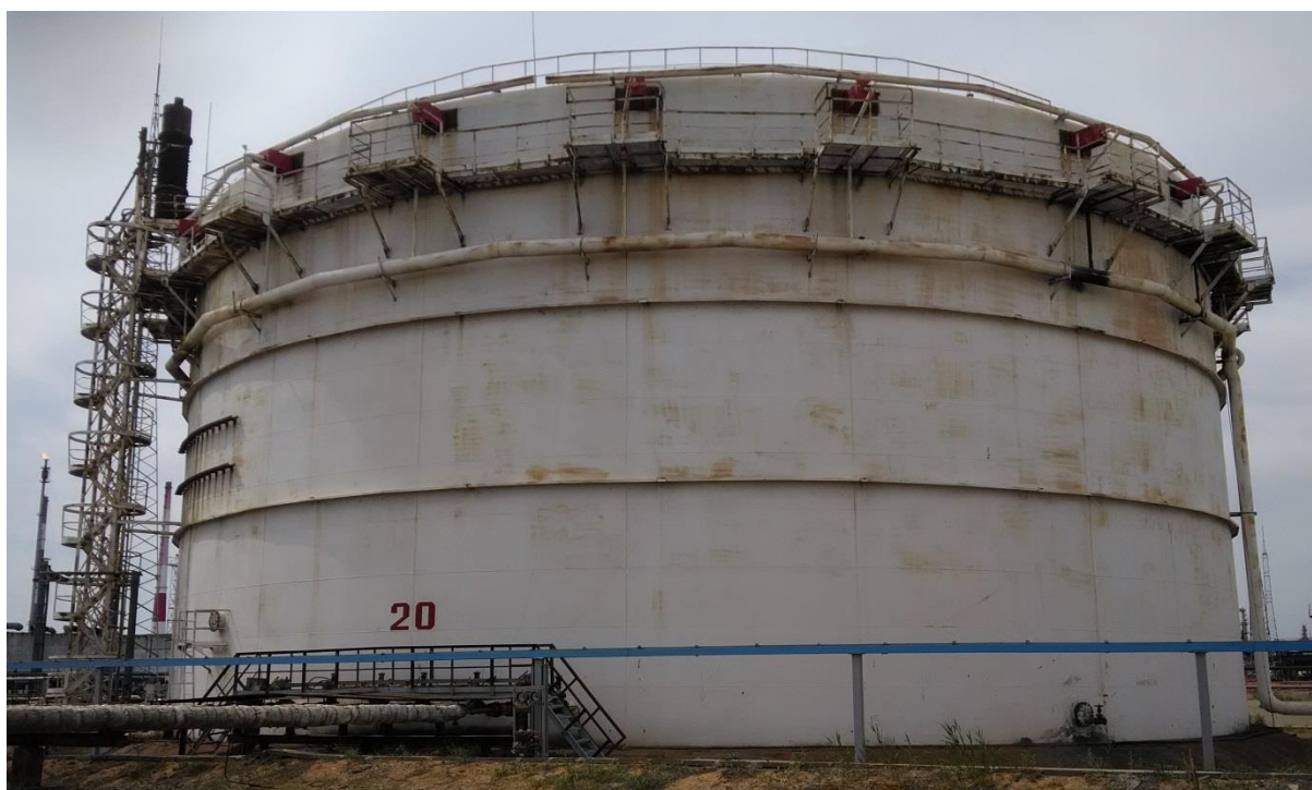
Рисунок 4 – Общий вид резервуара РВСП-20000 зав.№ 20
