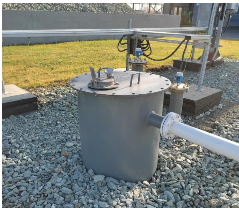
Рисунок 2 – Общий вид резервуара РГСП-200
