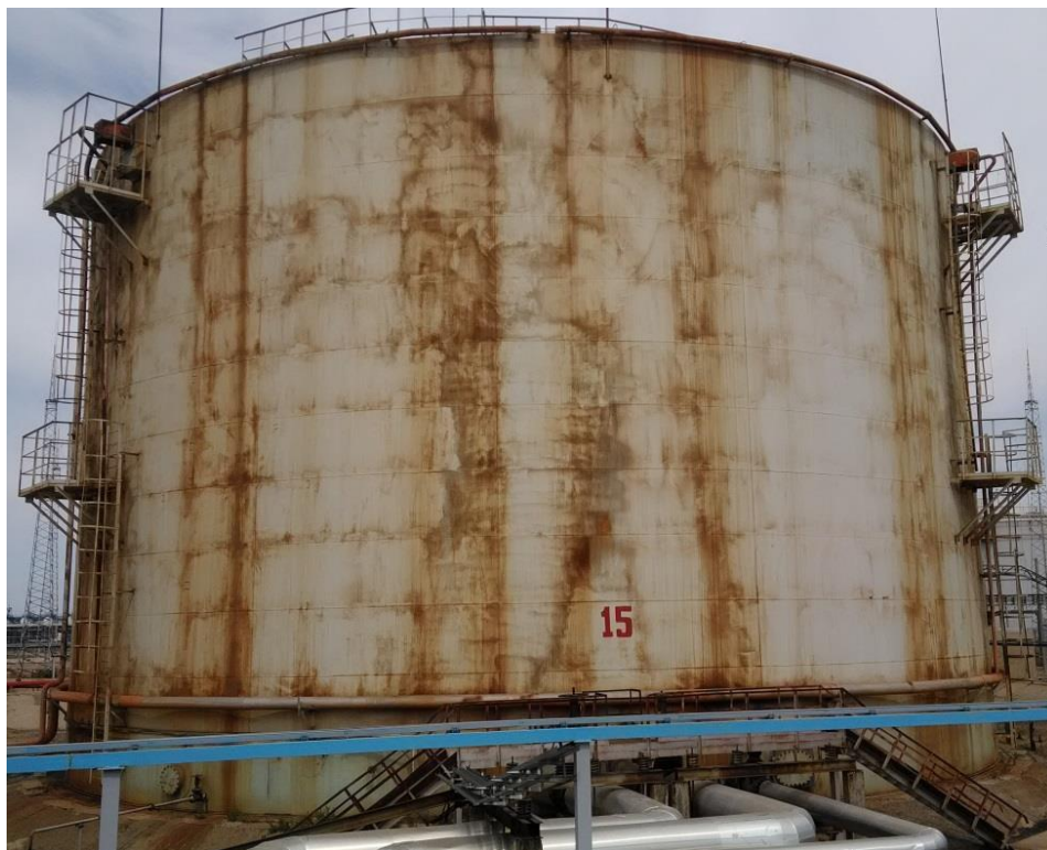
Рисунок 6 – Общий вид резервуара РВС-10000 зав.№ 15
