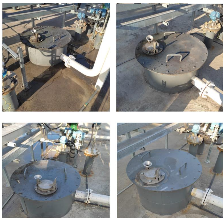
Рисунок 2 – Общий вид резервуаров ЕП-25
