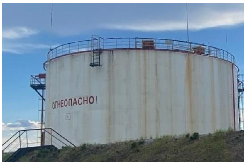
Рисунок 1 – Общий вид резервуара
