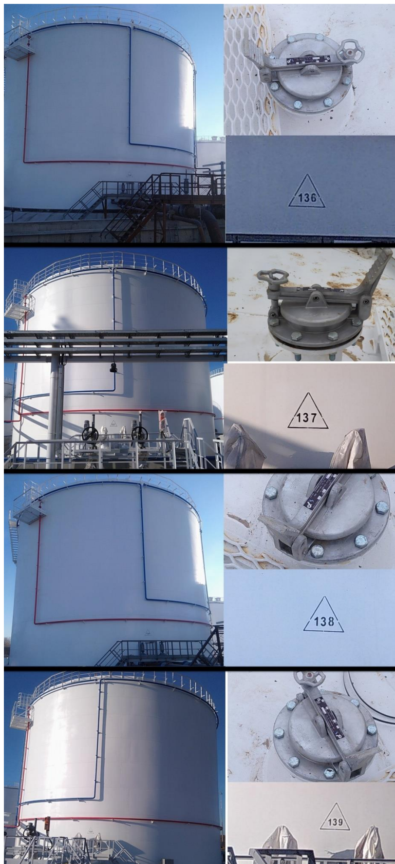
Рисунок 4 – Общий вид резервуаров РВС-5000 (зав.№№136, 137, 138, 139)
