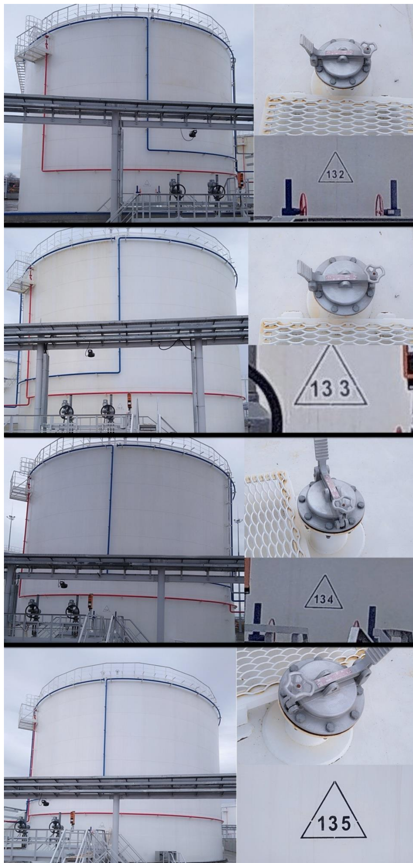
Рисунок 3 – Общий вид резервуаров РВС-5000 (зав.№№132, 133, 134, 135)
