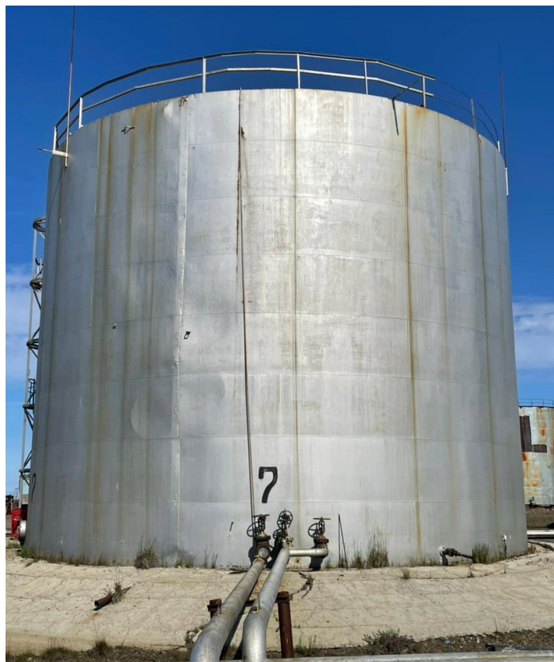
Рисунок 1 – Общий вид резервуара РВС-2000 с заводским номером 7
