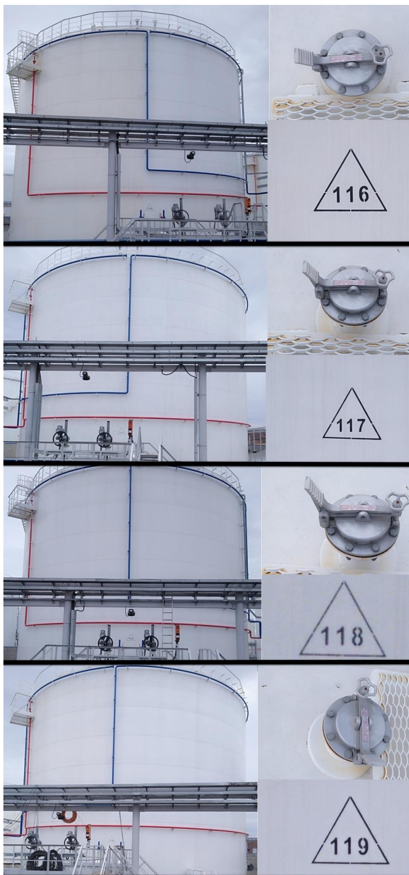
Рисунок 1 – Общий вид резервуаров РВС-5000 (зав.№№116, 117, 118,119)
