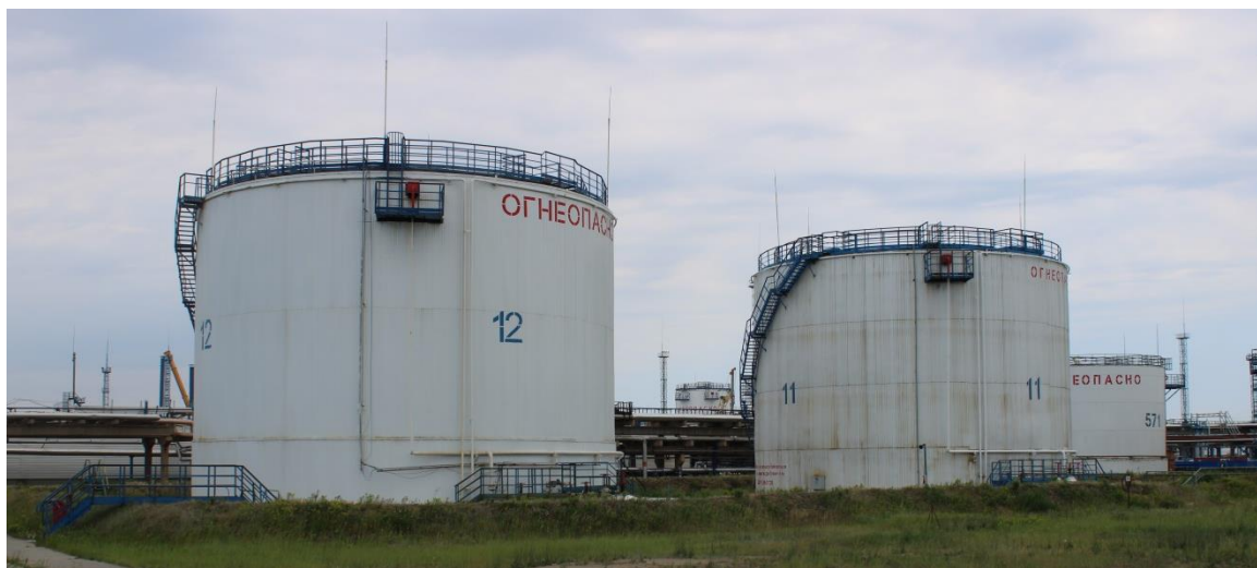
Рисунок 1 – Общий вид резервуаров
