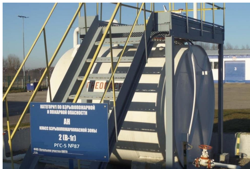
Рисунок 1 – Общий вид резервуара РГС-5 зав. № 87
