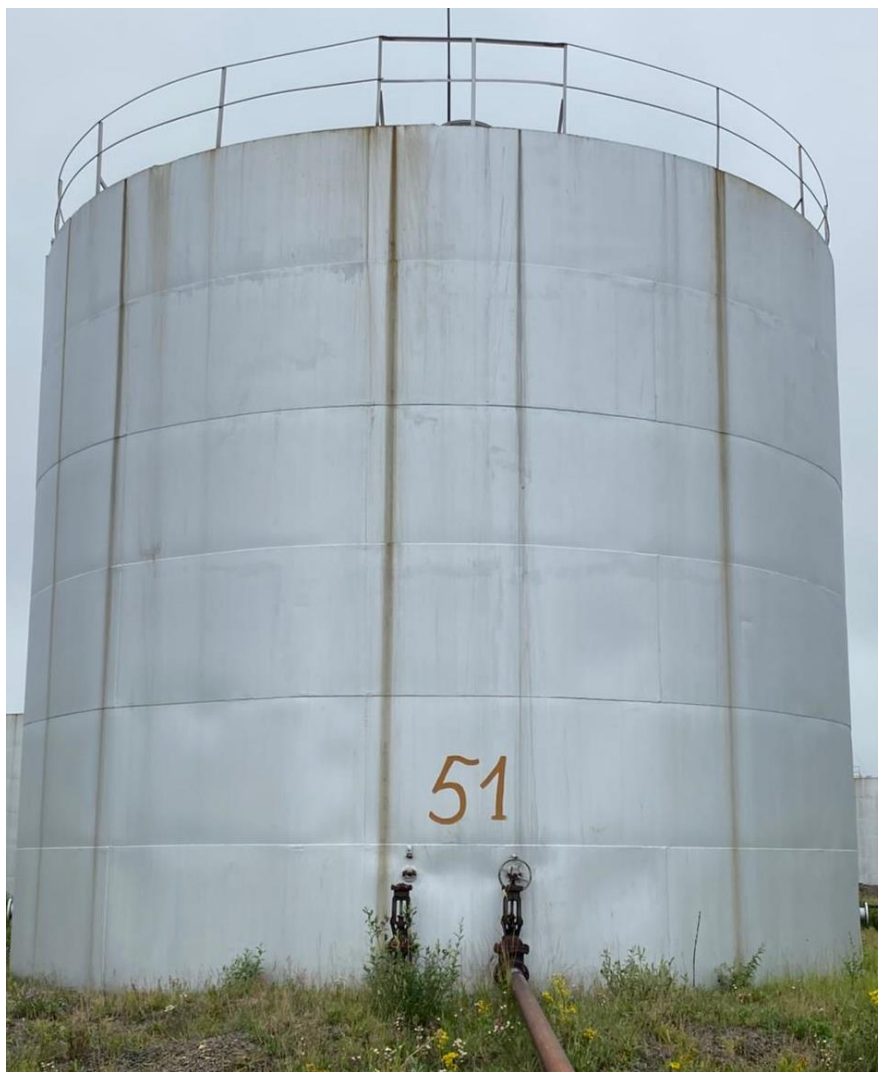
Рисунок 1 – Общий вид резервуара РВС-700
