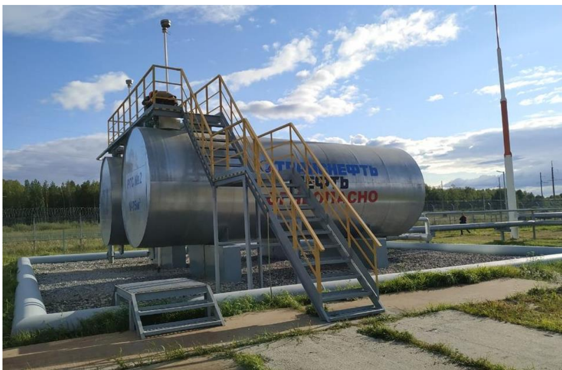
Рисунок 2 – Общий вид резервуаров РГС-75
