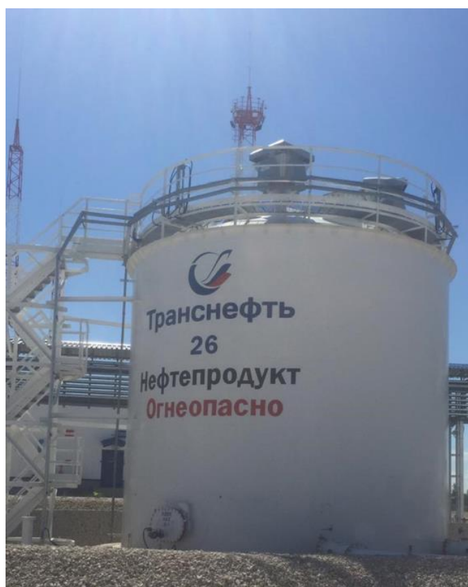
Рисунок 2 – Общий вид резервуара РВС-400 зав. № 26
