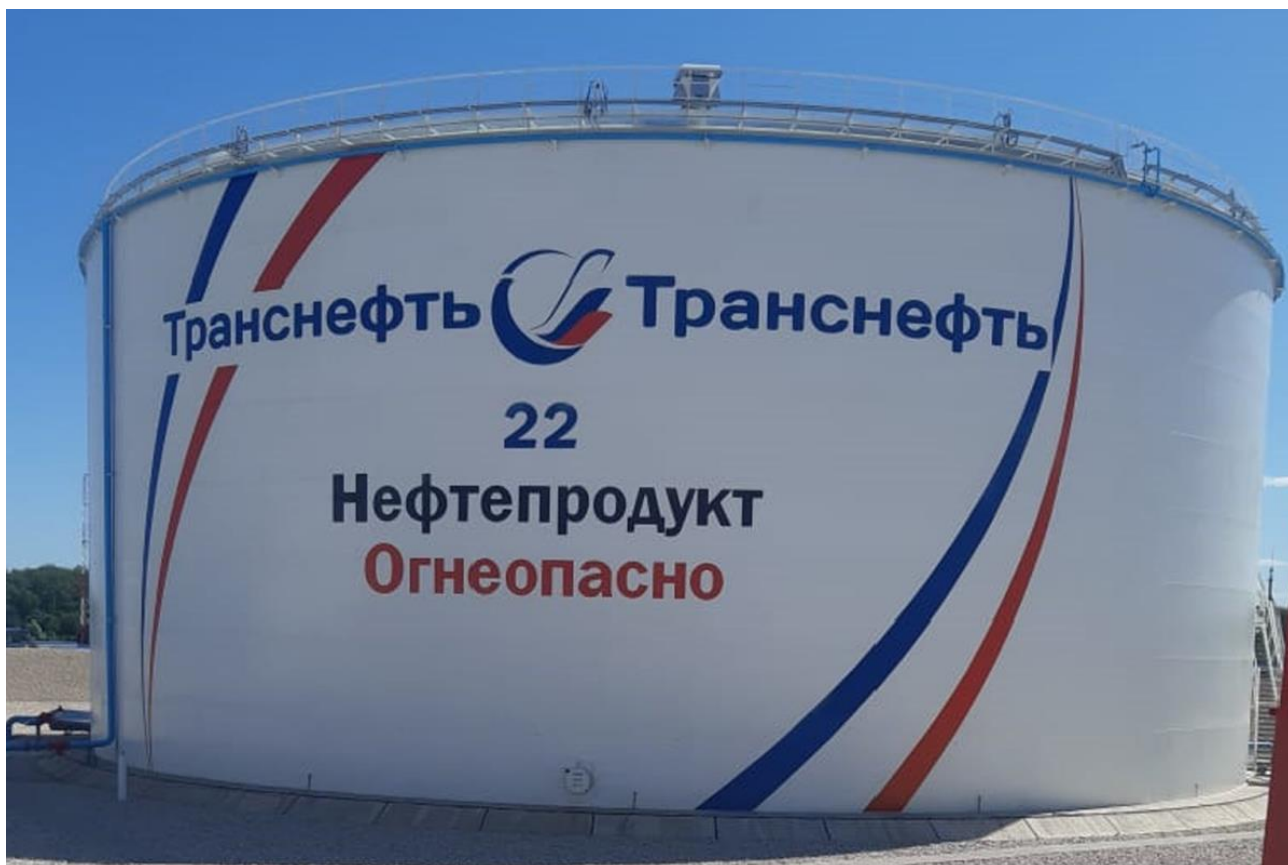
Рисунок 1 – Общий вид резервуара РВС-30000
