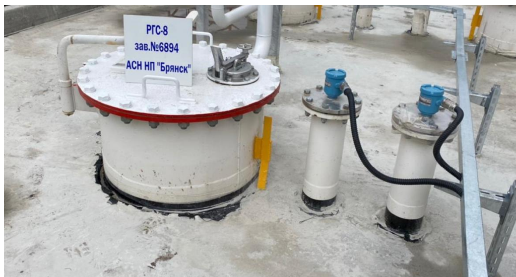
Рисунок 1 – Общий вид резервуара РГС-8
