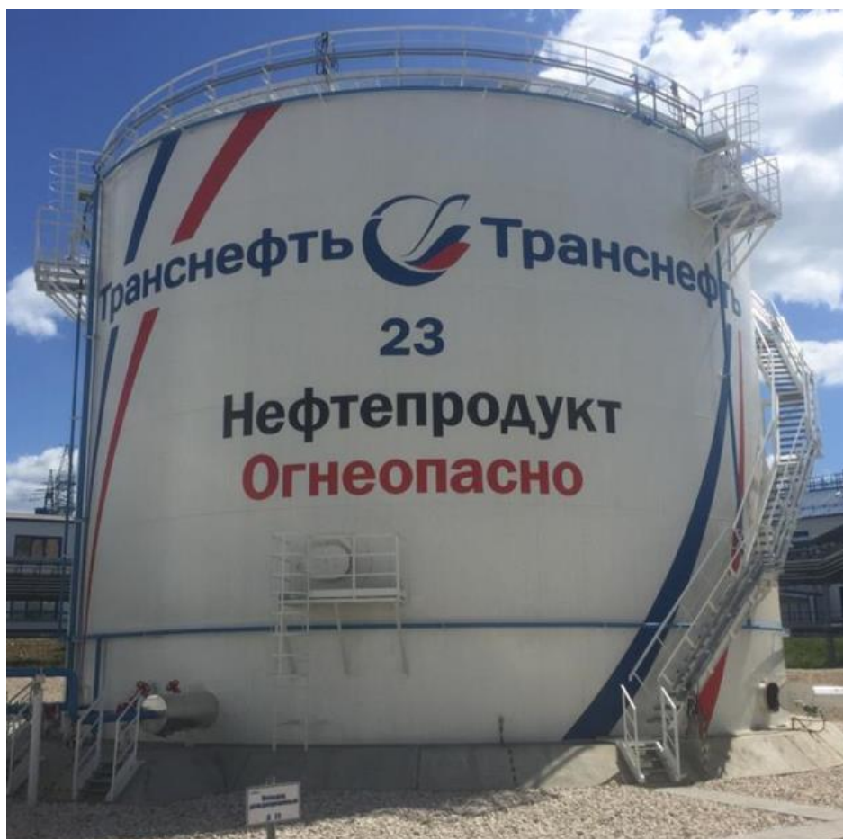
Рисунок 3 – Общий вид резервуара РВСП-5000 зав. № 23
