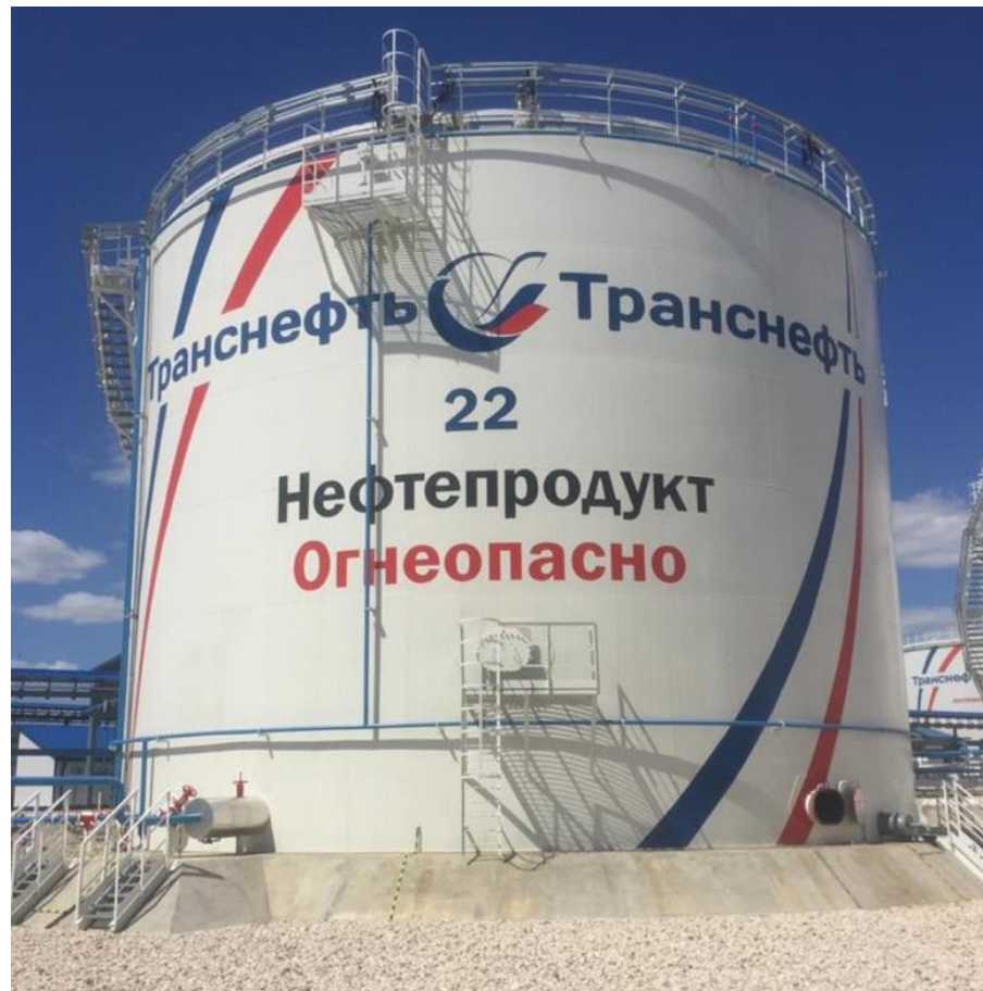
Рисунок 2 – Общий вид резервуара РВСП-5000 зав. № 22
