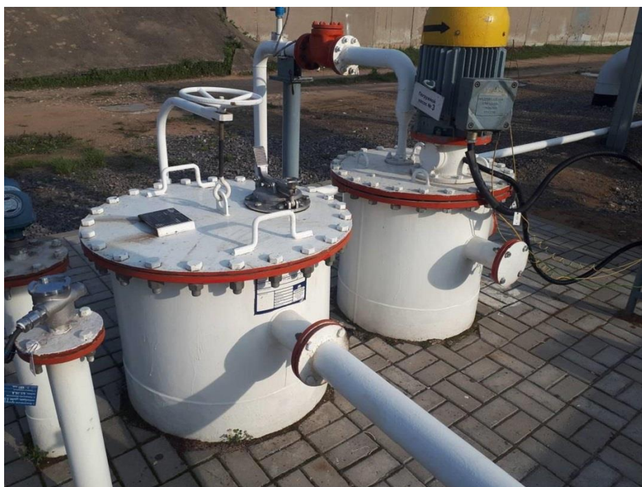
Рисунок 2 – Общий вид резервуара РГС-8
