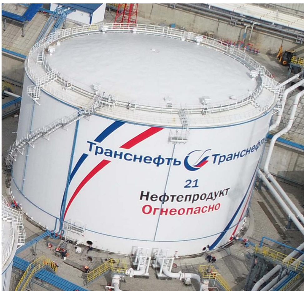
Рисунок 2 – Общий вид резервуара РВС-30000 зав. № 21
