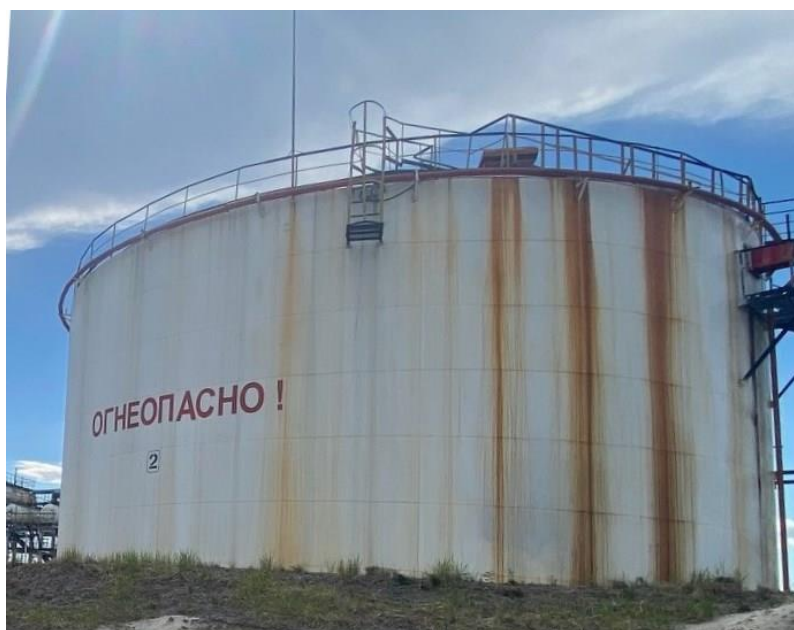
Рисунок 1 – Общий вид резервуара
