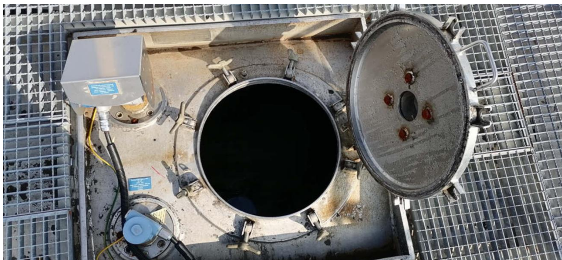
Рисунок 2 – Общий вид резервуара РГС-25
