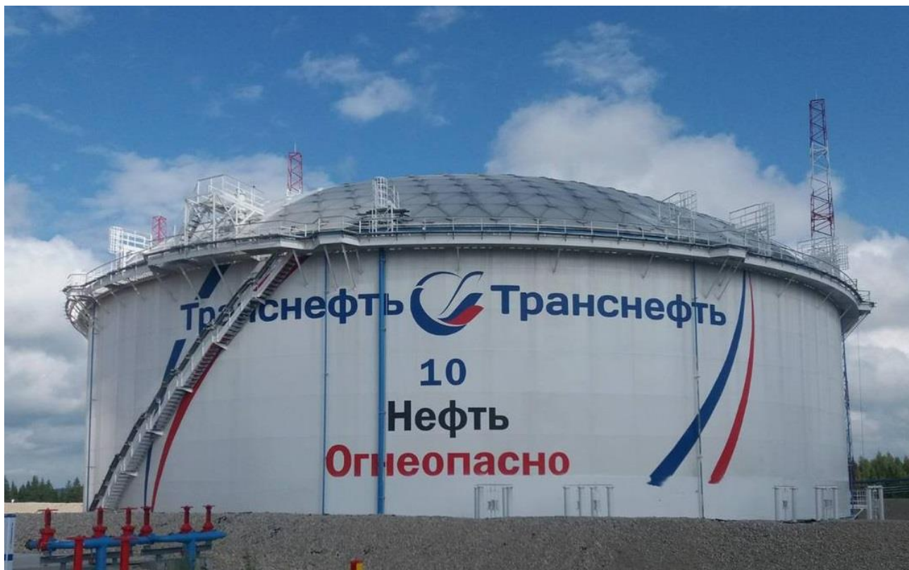
Рисунок 1 – Общий вид резервуара РВСПА-50000
