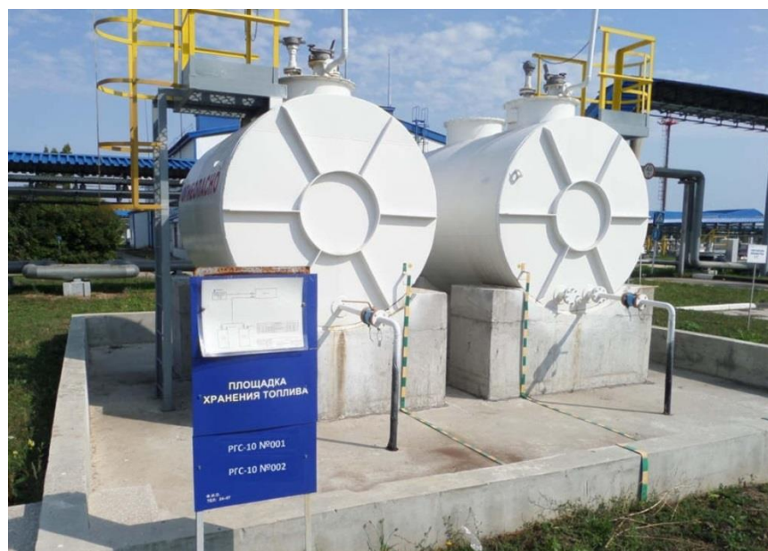
Рисунок 1 – Общий вид резервуаров РГС-10
