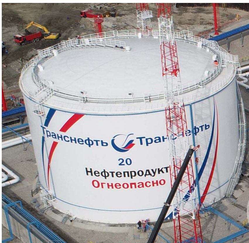
Рисунок 1 – Общий вид резервуара РВСП-30000 зав. № 20
