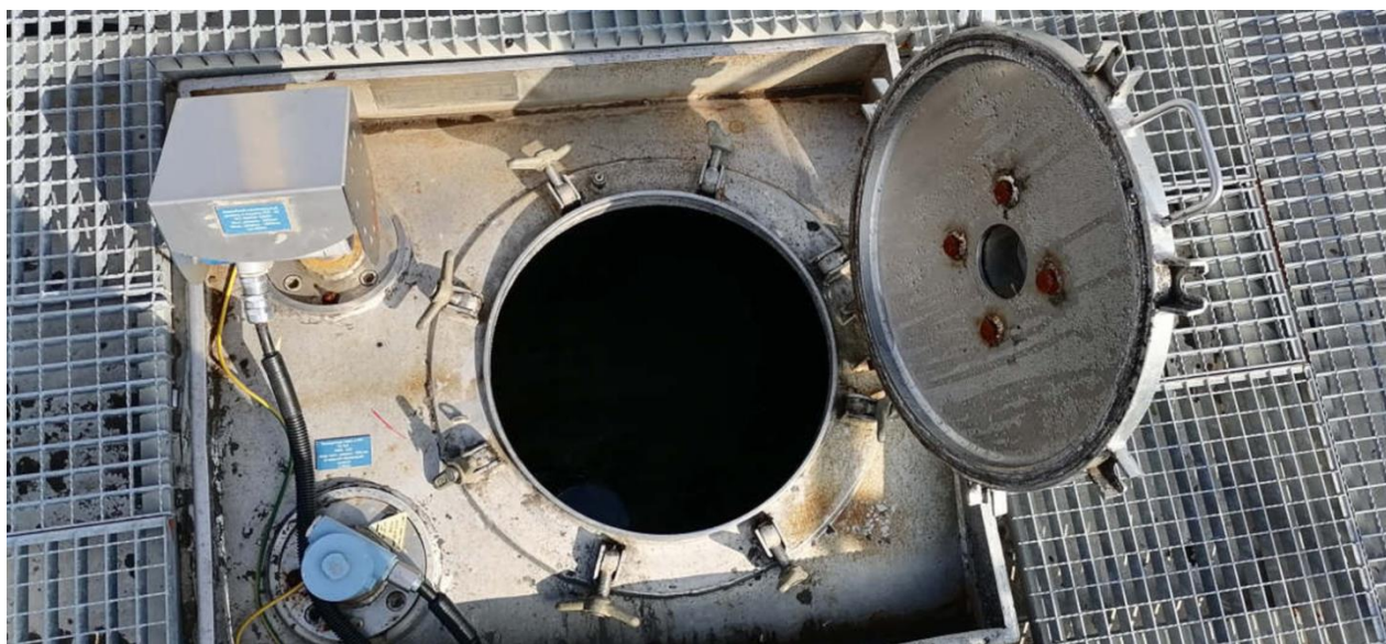
Рисунок 2 – Общий вид резервуара РГС-24
