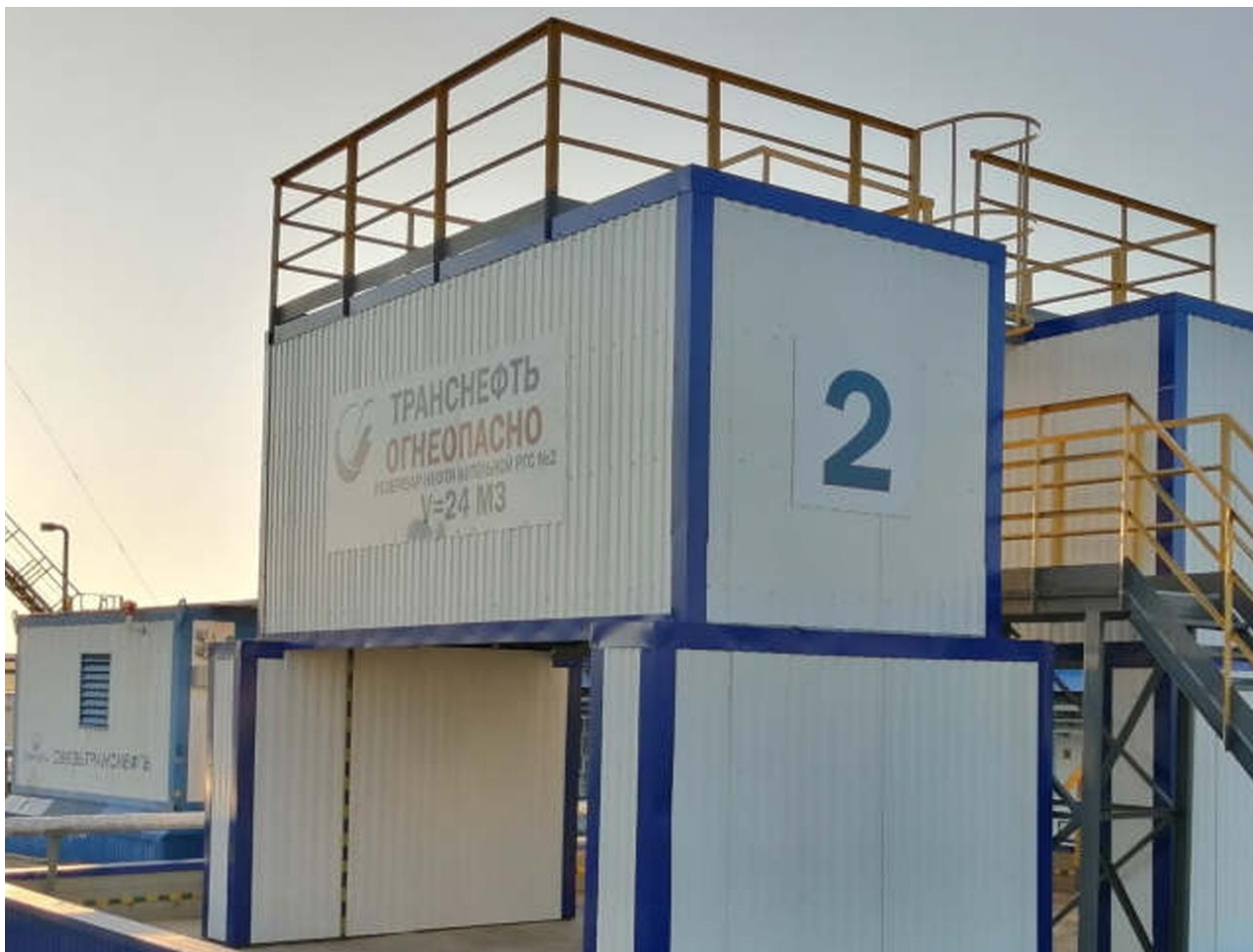
Рисунок 1 – Общий вид резервуара РГС-24
