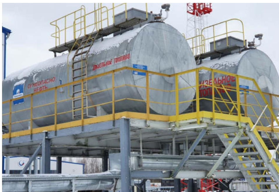
Рисунок 1 – Общий вид резервуаров РГС-40
