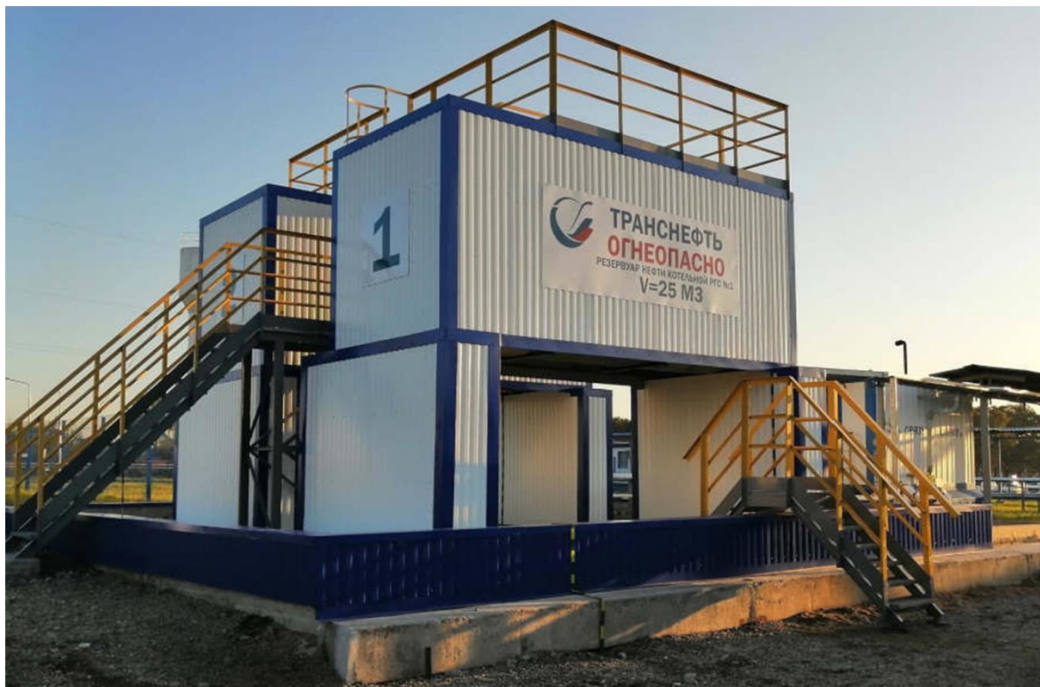
Рисунок 1 – Общий вид резервуара РГС-25
