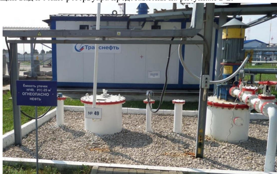
Рисунок 1 – Общий вид резервуара РГС-25
