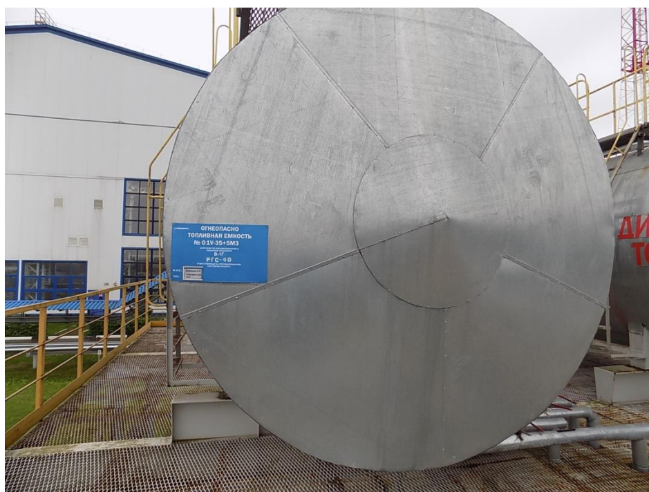
Рисунок 2 – Общий вид резервуара РГС-40 зав.№ 01
