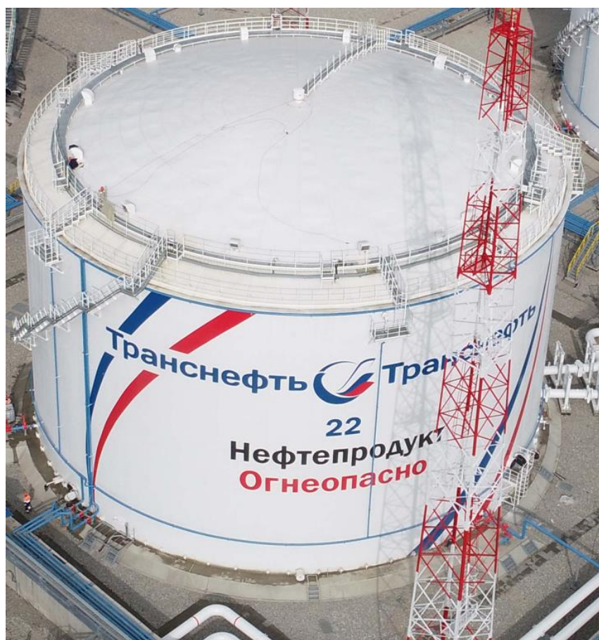
Рисунок 2 – Общий вид резервуара РВСП-30000 зав. № 22
