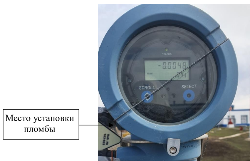
Рисунок – 2 Схема установки пломб для защиты от несанкционированного доступа преобразователя серии 2700.
