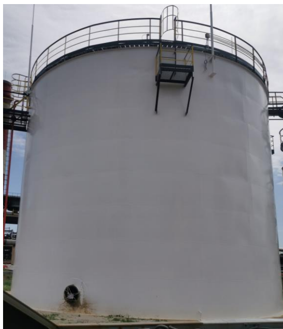
Рисунок 1 – Общий вид резервуара
