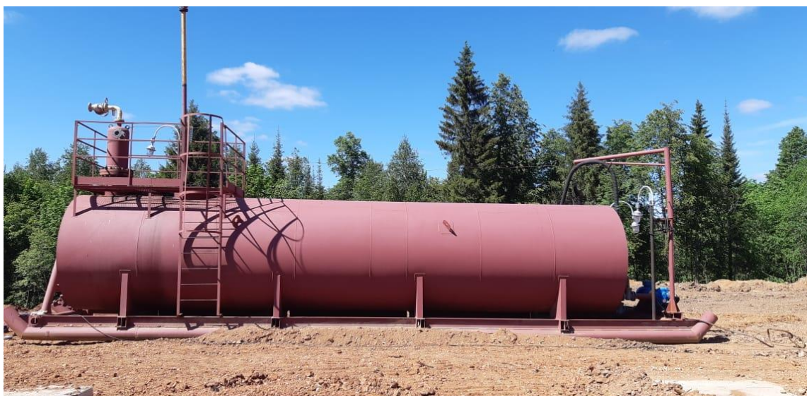
Рисунок 1 – Общий вид резервуара стального горизонтального цилиндрического РГС-50
