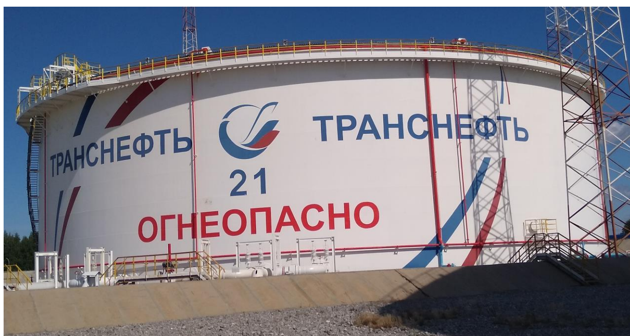
Рисунок 5 – Общий вид резервуара РВСПК-50000 с заводским номером 21
