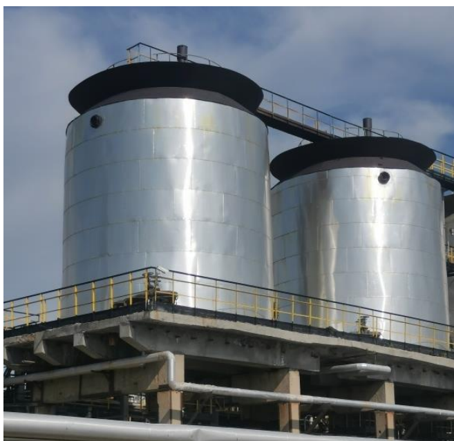
Рисунок 1 – Общий вид резервуаров РВС-400
