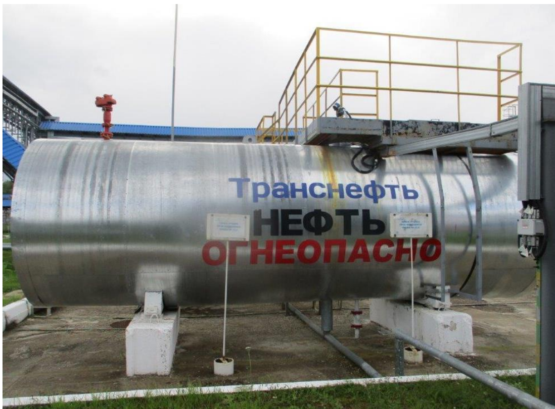
Рисунок 2 – Общий вид резервуара РГС-20 с заводским номером 6
