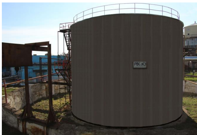
Рисунок 1 – Общий вид резервуара стального вертикального цилиндрического РВС-1000
