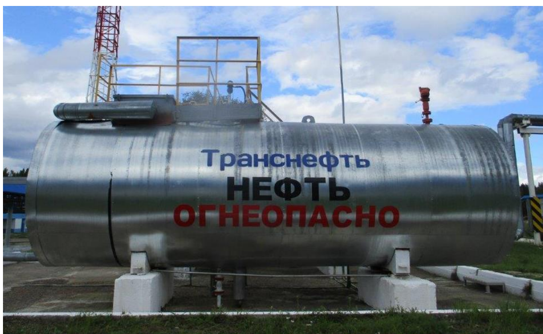
Рисунок 3 – Общий вид резервуара РГС-20 с заводским номером 9
