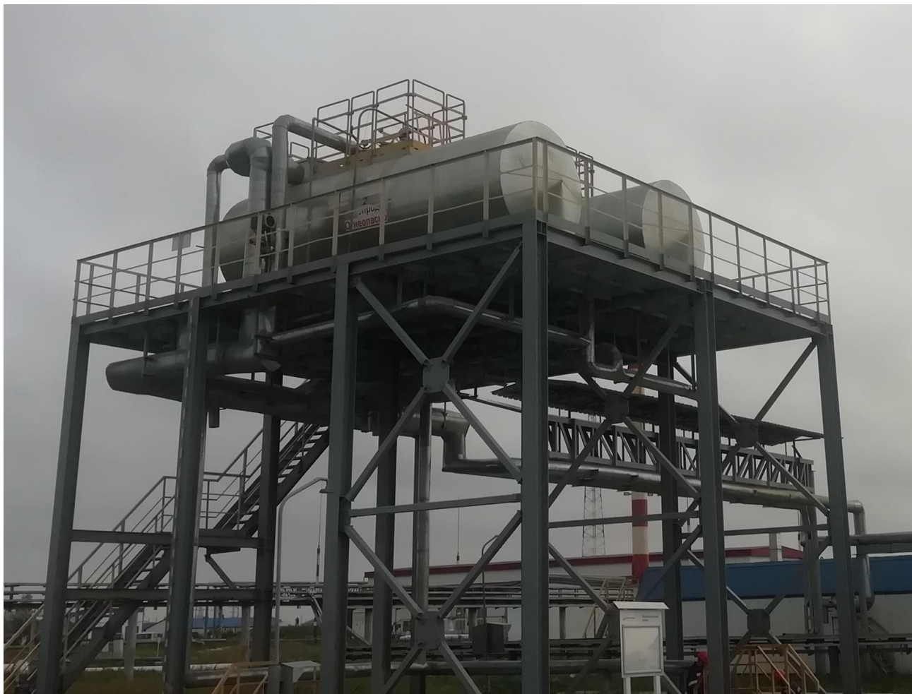
Рисунок 2 – Общий вид резервуаров РГС-20
