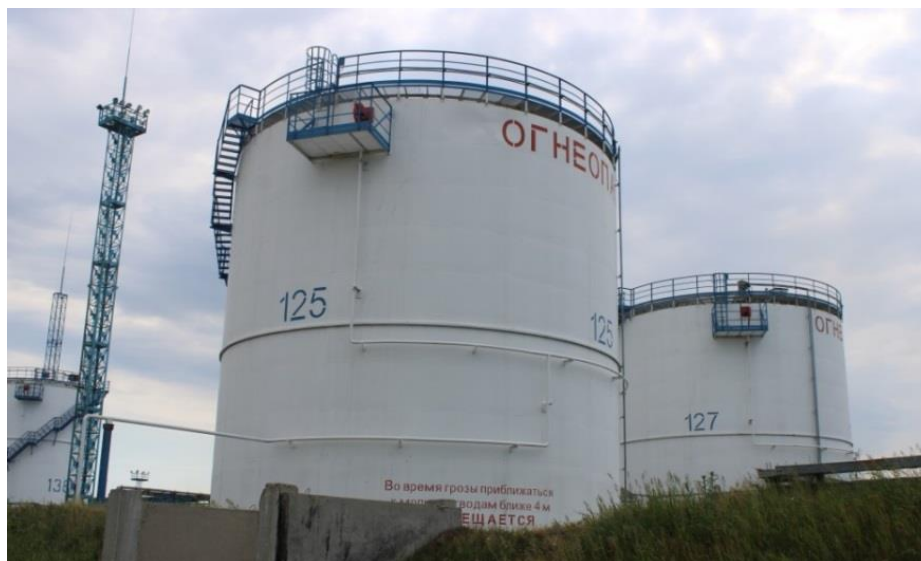
Рисунок 1 – Общий вид резервуара
