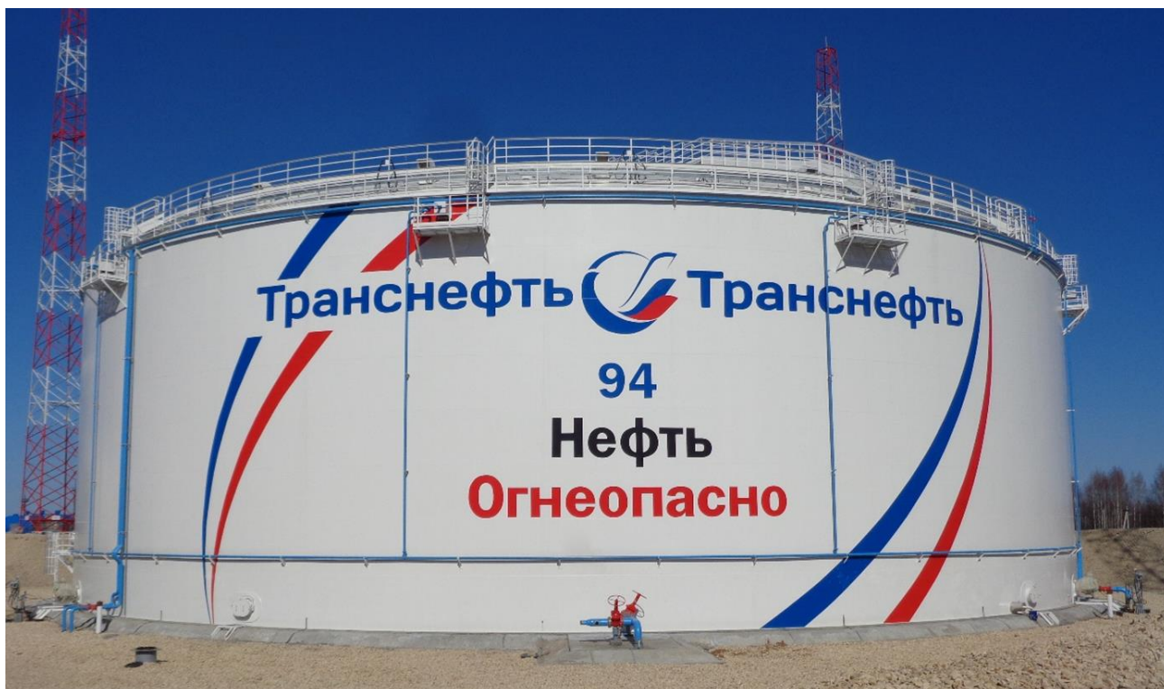
Рисунок 1 – Общий вид резервуара РВСП-50000
