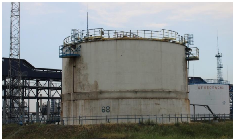
Рисунок 1 – Общий вид резервуара
