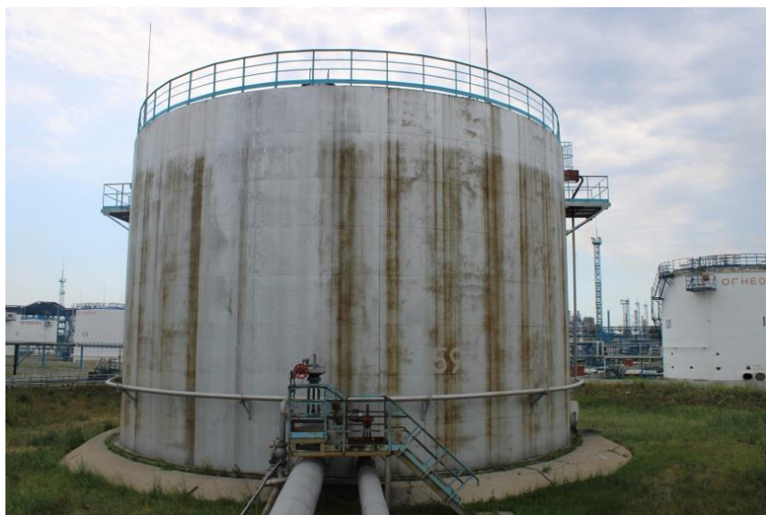
Рисунок 1 – Общий вид резервуаров
