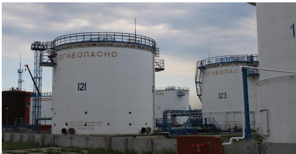
Рисунок 1 – Общий вид резервуаров
