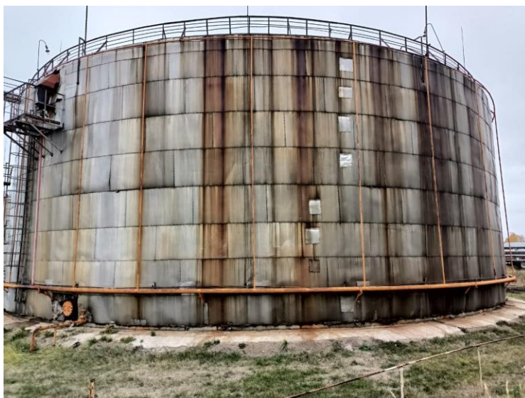
Рисунок 1 – Общий вид резервуара стального вертикального цилиндрического РВС-10000
