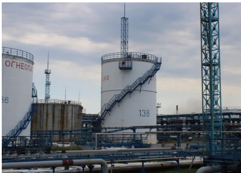
Рисунок 1 – Общий вид резервуара
