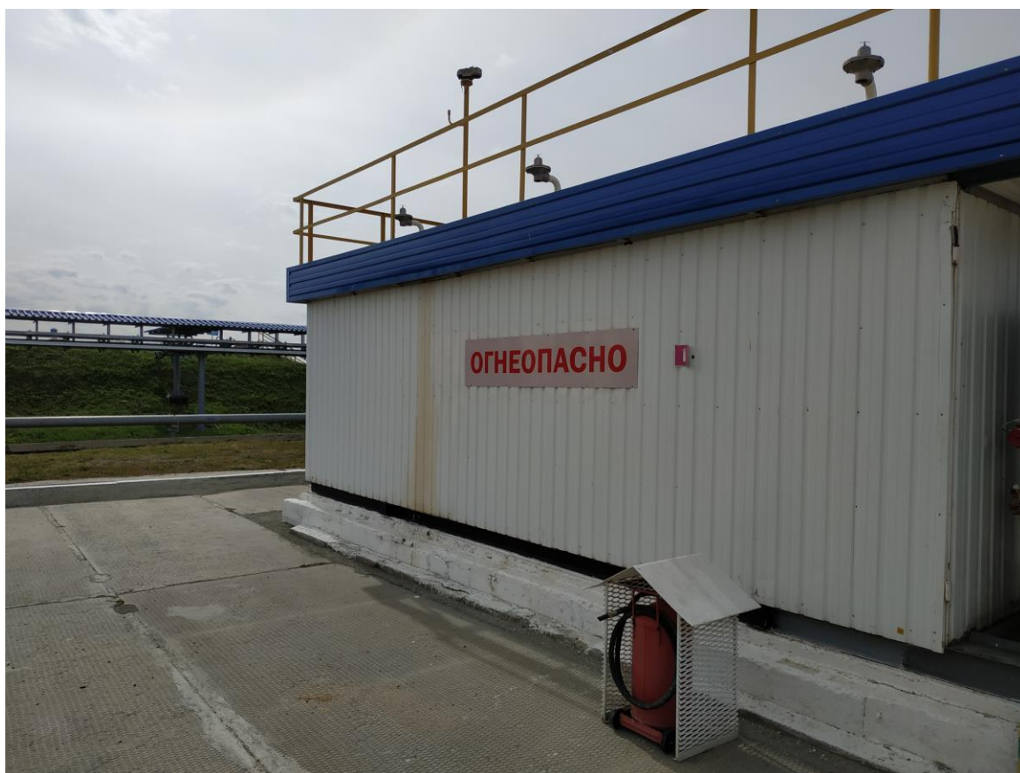
Рисунок 2 – Общий вид резервуаров РГС-10
