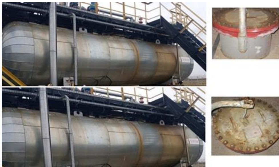
Рисунок 1 – Общий вид резервуаров стальных горизонтальных цилиндрических РГС-25 (заводские номера V-911A, V-911B)
