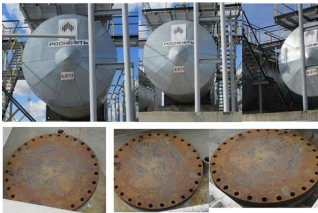
Рисунок 9 – Общий вид резервуаров стальных горизонтальных цилиндрических РГС-200 с заводскими номерами Е-2/10, Е-2/11, Е-2/12
