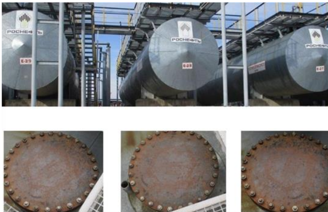
Рисунок 8 – Общий вид резервуаров стальных горизонтальных цилиндрических РГС-200 с заводскими номерами Е-2/7, Е-2/8, Е-2/9
