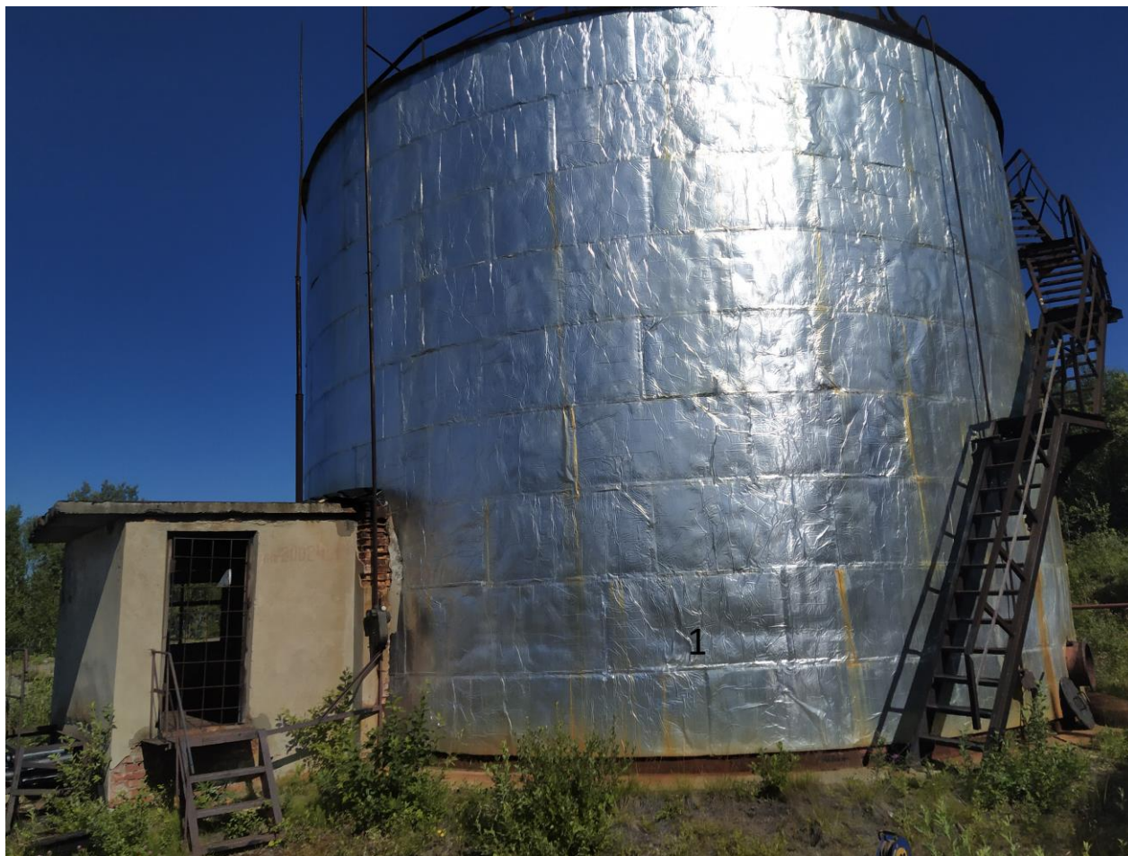
Рисунок 1 – Общий вид резервуара РВС-1000
