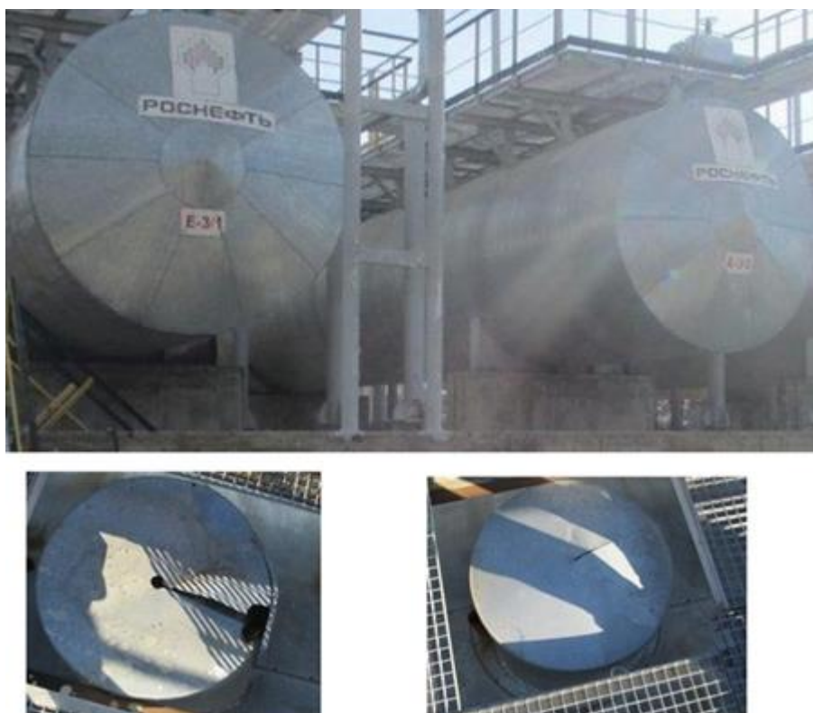
Рисунок 12 – Общий вид резервуаров стальных горизонтальных цилиндрических РГС-200 с заводскими номерами Е-3/1, Е-3/2
