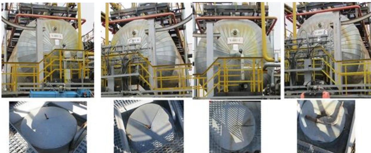
Рисунок 1 – Общий вид резервуаров стальных горизонтальных цилиндрических РГС-200 с заводскими номерами V-601 A, V-601 B, V-601 C, V-601 D
