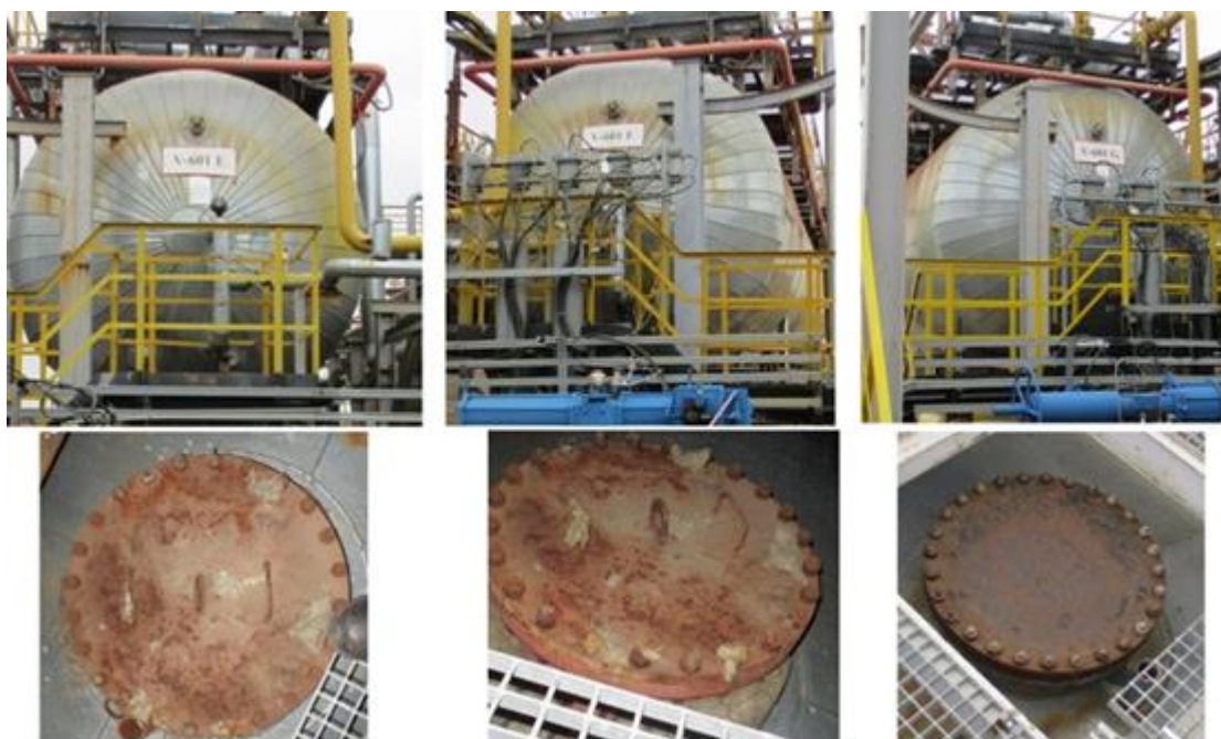
Рисунок 2 – Общий вид резервуаров стальных горизонтальных цилиндрических РГС-200 с заводскими номерами V-601 E, V-601 F, V-601 G
