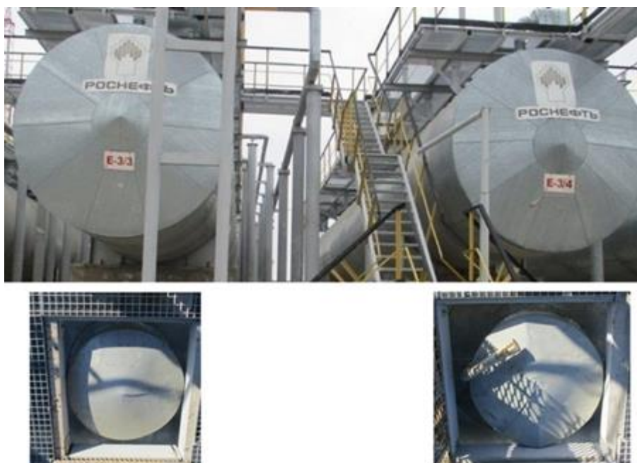
Рисунок 13 – Общий вид резервуаров стальных горизонтальных цилиндрических РГС-200 с заводскими номерами Е-3/3, Е-3/4
